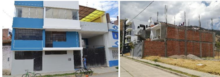
Figura 55. Izquierda: edificación con sistema estructural aporticado. Derecha: edificación con sistema estructural de albañilería confinada
