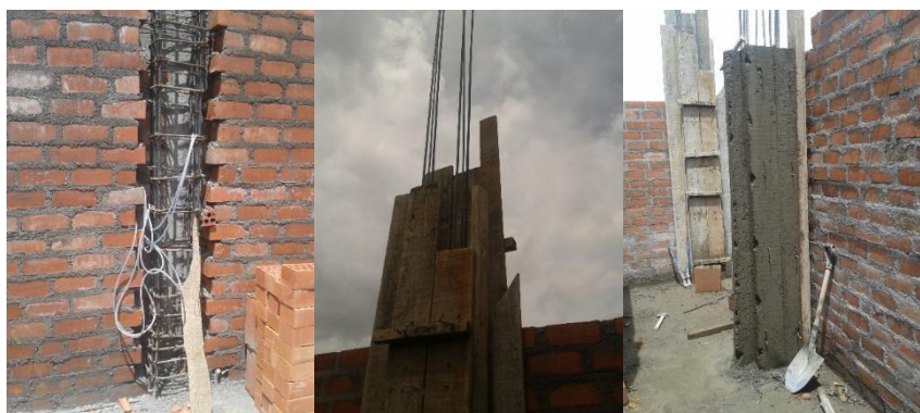
Figura 32. Proceso constructivo de muro de albañilería confinada armado, encofrado y desencofrado
