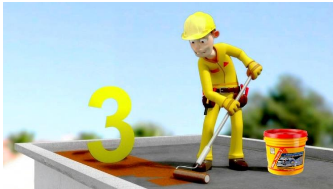
Figura 195. Uso de Sika Techo 3, debe de realizarse a dos capas para garantizar la impermeabilización del techo y no dejar aberturas
