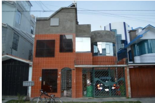
Figura 161. Fotografía de la edificación 41
