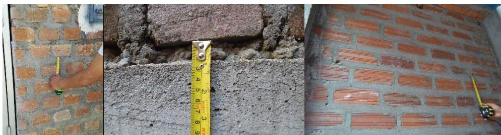
Figura 60. Espesor de juntas en muros analizados, varían de 1 a 3 centímetros
