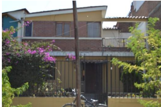
Figura 160. Fotografía de la edificación 1
