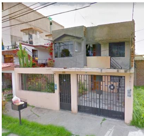
Figura 162. Fotografía de la edificación 45
