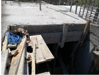
Figura 71. Edificación de albañilería confinada analizada con losa aligerada de 20 cm
