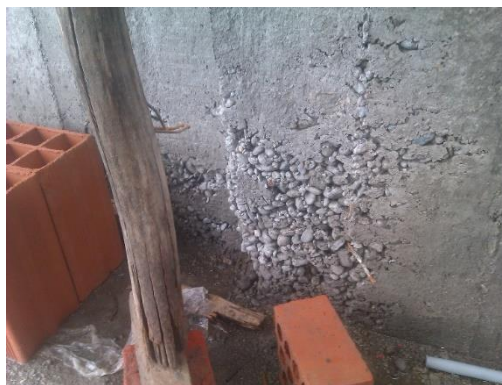
Figura 31. Cangrejera presentada en la base de la columna
