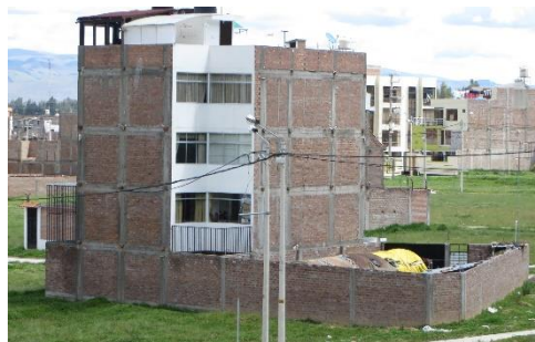
Figura 85. Edificación de cuatro niveles que basa su comportamiento estructural en muros con unidades artesanales
