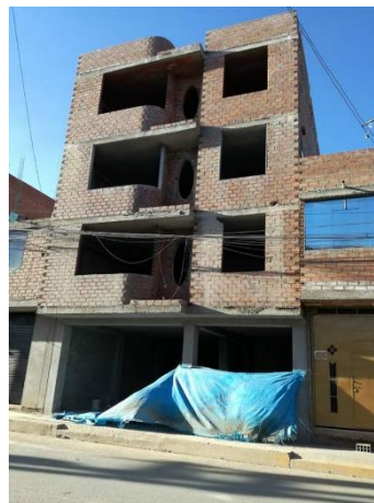
Figura 86. Edificación de cuatro niveles que basa su comportamiento estructural en muros con unidades pandereta
