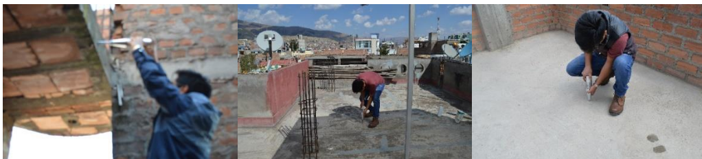
Figura 73. Toma de muestra de la resistencia a la compresión de la losa
