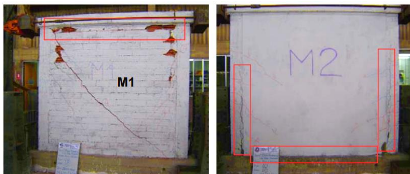
Figura 188. Comparación del desempeño estructural ante cargas dinámicas de un muro portante con ladrillos pandereta y uno reforzado con la malla electro soldada (basado en estudios realizados en el Perú)
