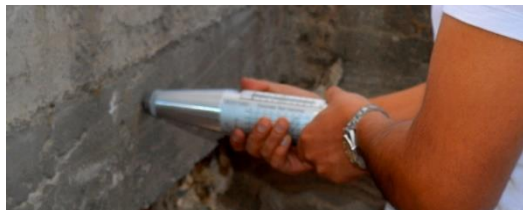
Figura 52. Ensayo con esclerómetro aplicado a los elementos estructurales de las edificaciones analizadas
