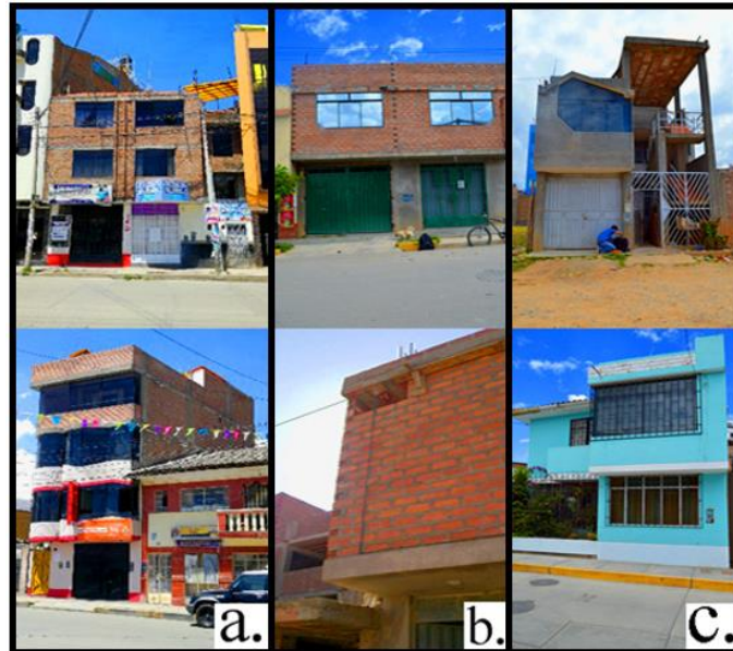
Figura 7. Edificaciones ubicadas en el distrito de Huancayo
