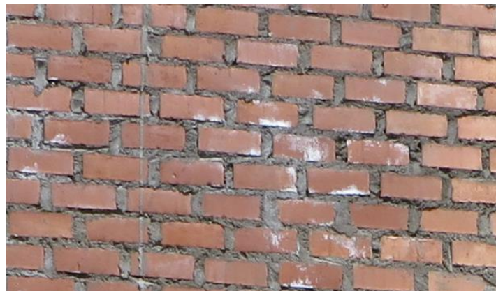
Figura 58. Unidades de albañilería confinada que muestran buena adherencia
