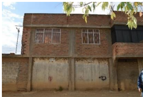
Figura 77. Edificación de albañilería confinada (N° 007), utiliza unidades artesanales en muros portantes
