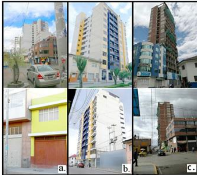
Figura 6. Edificaciones ubicadas en el distrito de Huancayo
