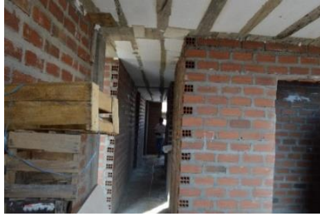
Figura 78. Edificación de albañilería confinada (N° 30), utiliza unidades pandereta en muros portantes
