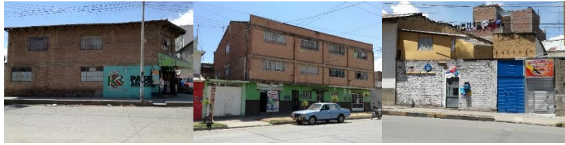
Figura 63. Edificaciones de albañilería confinada sin columnas de confinamiento
