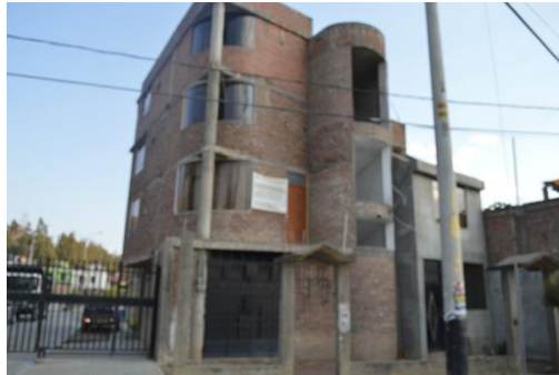
Figura 164. Edificación de albañilería confinada de hasta de cuatro pisos con ladrillos artesanales en Huancayo
