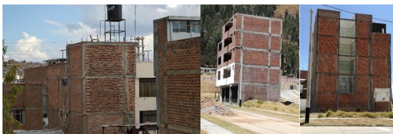
Figura 56. Tres edificaciones de albañilería confinada con unidades pandereta, artesanales y ladrillo King Kong tipo IV respectivamente
