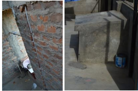
Figura 61. Izquierda: tubería que cruza los muros portantes de las edificaciones, Derecha: Ducto colocado para evitar el paso de tuberías a través de los muros
