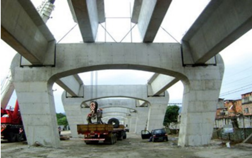
Figura 21. Vigas de hormigón para el tren eléctrico. Fuente: El Comercio, 2009.
