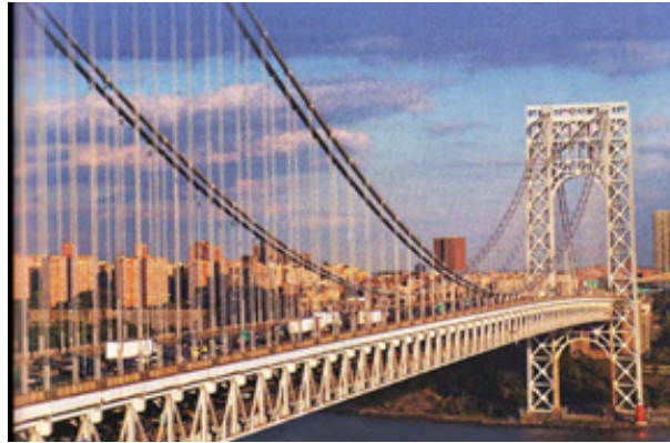
Figura 26. Puente Middle Bridge - Massachusetts. Fuente: Tecnología de estructuras. MacHannon, 2013.
