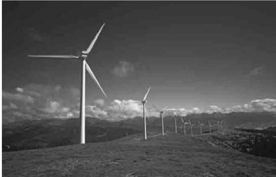
Figura 68: El viento realiza trabajo sobre el rotor de la turbina de viento (aeroturbina), lo que ocasiona que esta gire y active un generador eléctrico. Fuente: Bedford & Fowler, 2008, p. 412.
