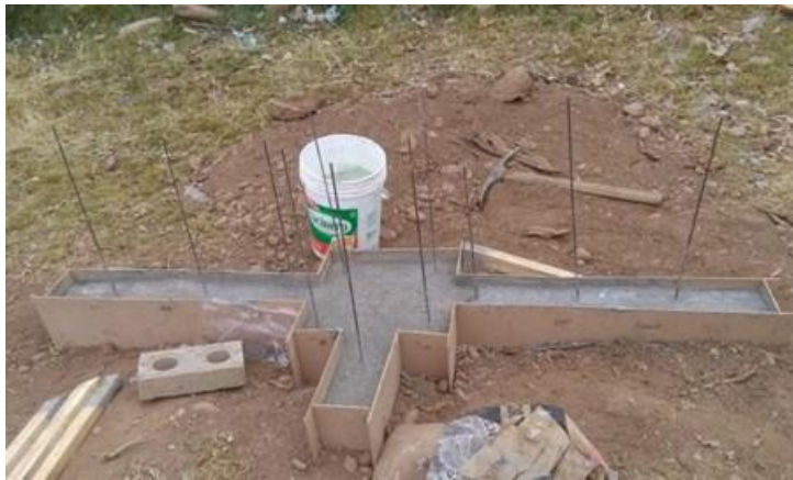
Fotografía 55: Vaciado de cimiento y sobrecimiento
