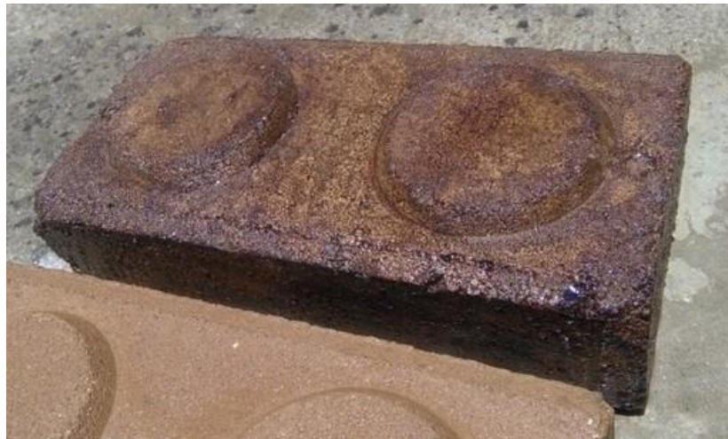
Fotografía 54: BTC impermeabilizado con Barniz después de la precipitación
