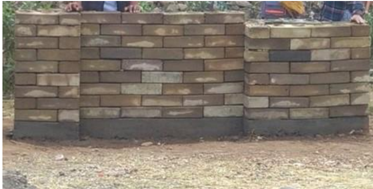
Fotografía 57: Limpieza del muro de BTC
