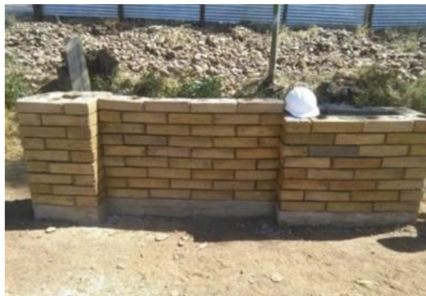
Fotografía 59: Limpieza del muro
