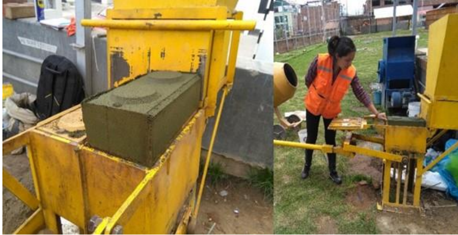
Fotografía 10: BTC compactado listo para retirar del molde
