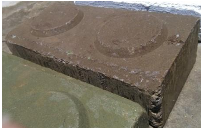
Fotografía 51: BTC no impermeabilizado con sábila después de precipitación
