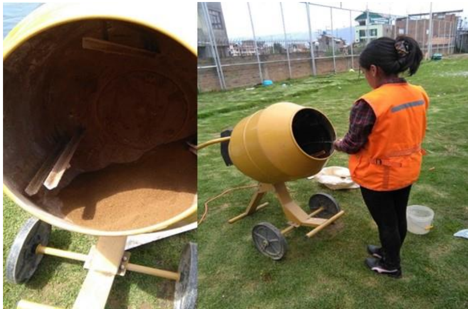
Fotografía 6: Preparación de mezcla y adición de agua por aspersión
