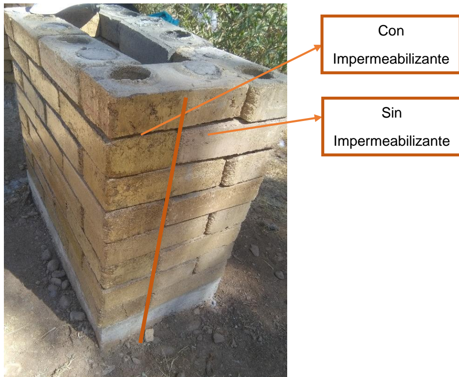
Figura 21: Diferencia de muro con y sin impermeabilizante
