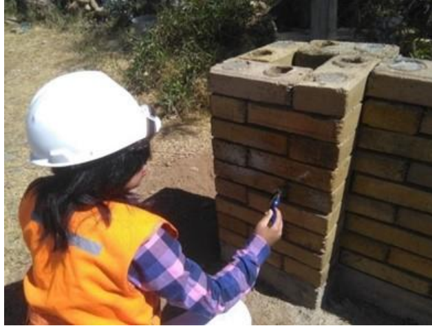
Fotografía 60: Aplicación del Impermeabilizante en el muro de BTC
