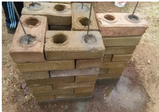
Fotografía 58: Vaciado de orificios del BTC
