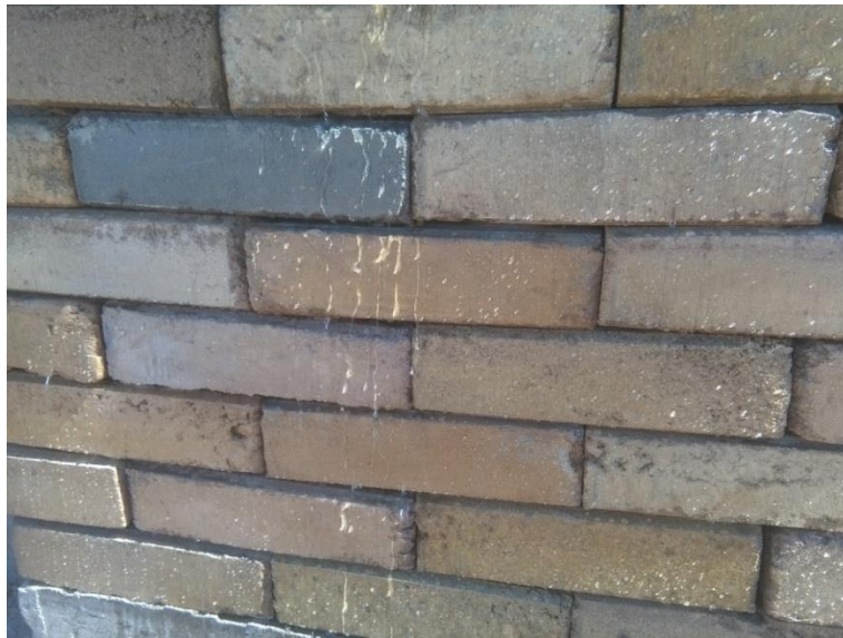
Fotografía 61: Muro de BTC con la simulación de precipitaciones
