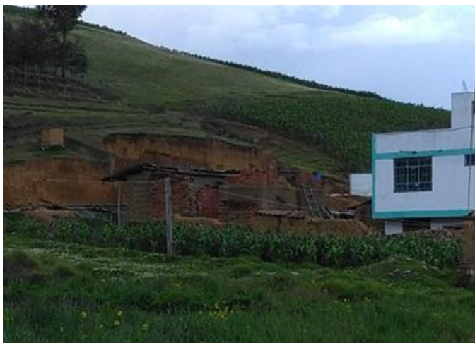
Fotografía 1: Ladrillera artesanal en Cochas Grande
