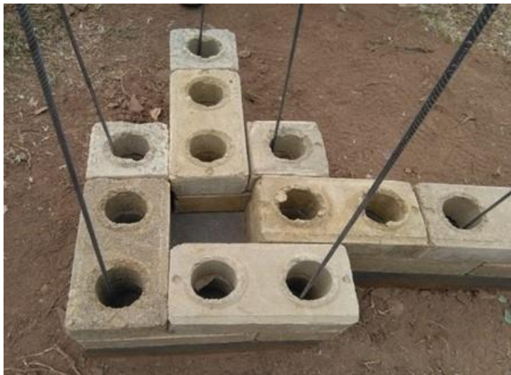
Fotografía 56: BTC en los muros
