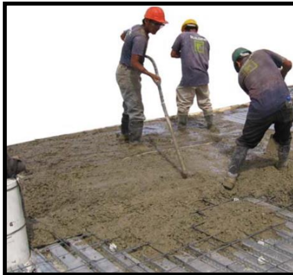
Figura 34: Placa colaborante sirviendo como encofrado para el vaciado del concreto
