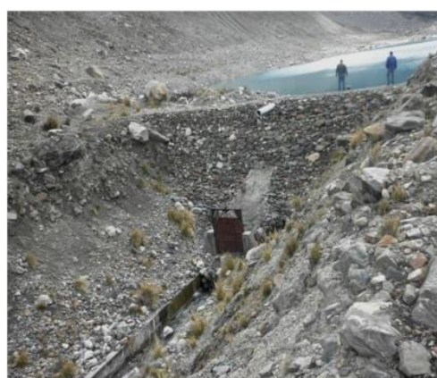
Compuerta y canal de salida de laguna.
