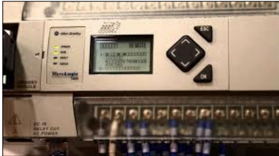
Figura 13: Equipo – PLC
