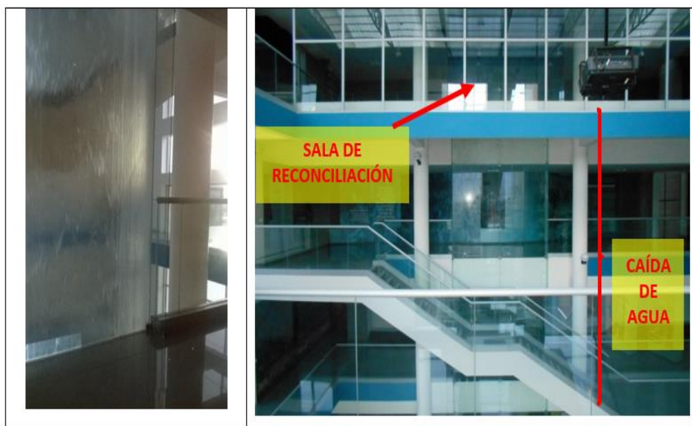
Figura 59: Caída de agua desde el espacio de la reconciliación (cuarto nivel) y llega hasta el Hall (primer nivel).
