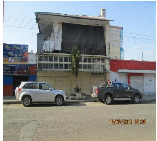
Fotografía N°08: Jr. Breña/Arequipa - Jr. Moquegua (PC-08)
