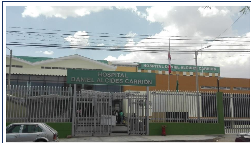
Fotografía 1. Vista general del Hospital Daniel Alcides Carrión.
