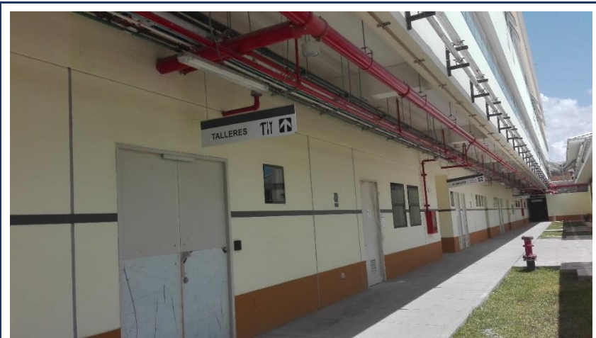
Fotografía 4. Vista del sótano del Bloque A.
