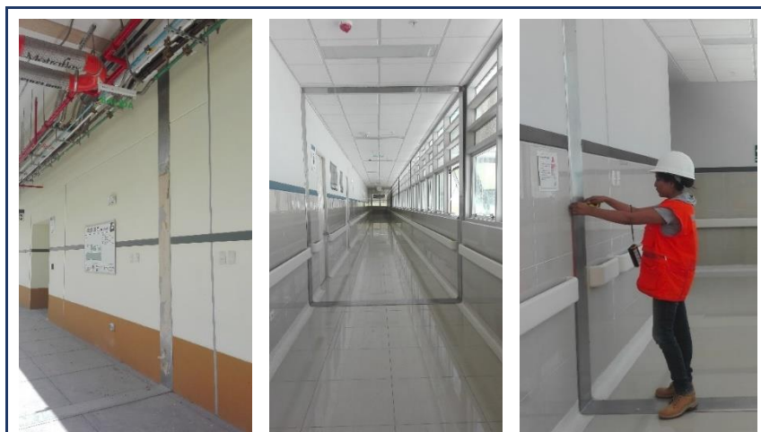
Fotografía 3. Vista de la junta sísmica que separa al Bloque A en dos módulos.
