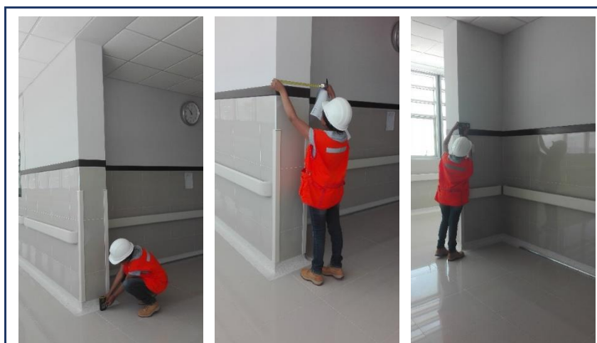
Fotografía 9. Toma de medidas de elementos estructurales.
