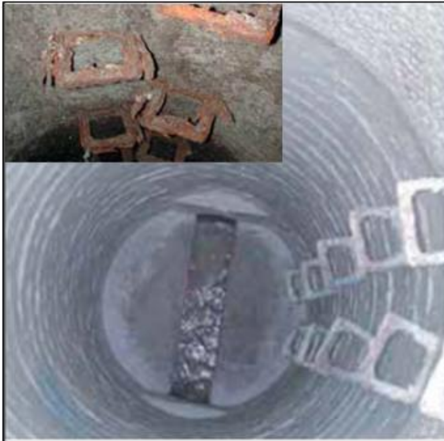
Figura 10: Polímero en planta de tratamiento de agua residual.
