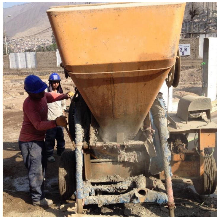
Descripción: Mezclado de los materiales del concreto.
