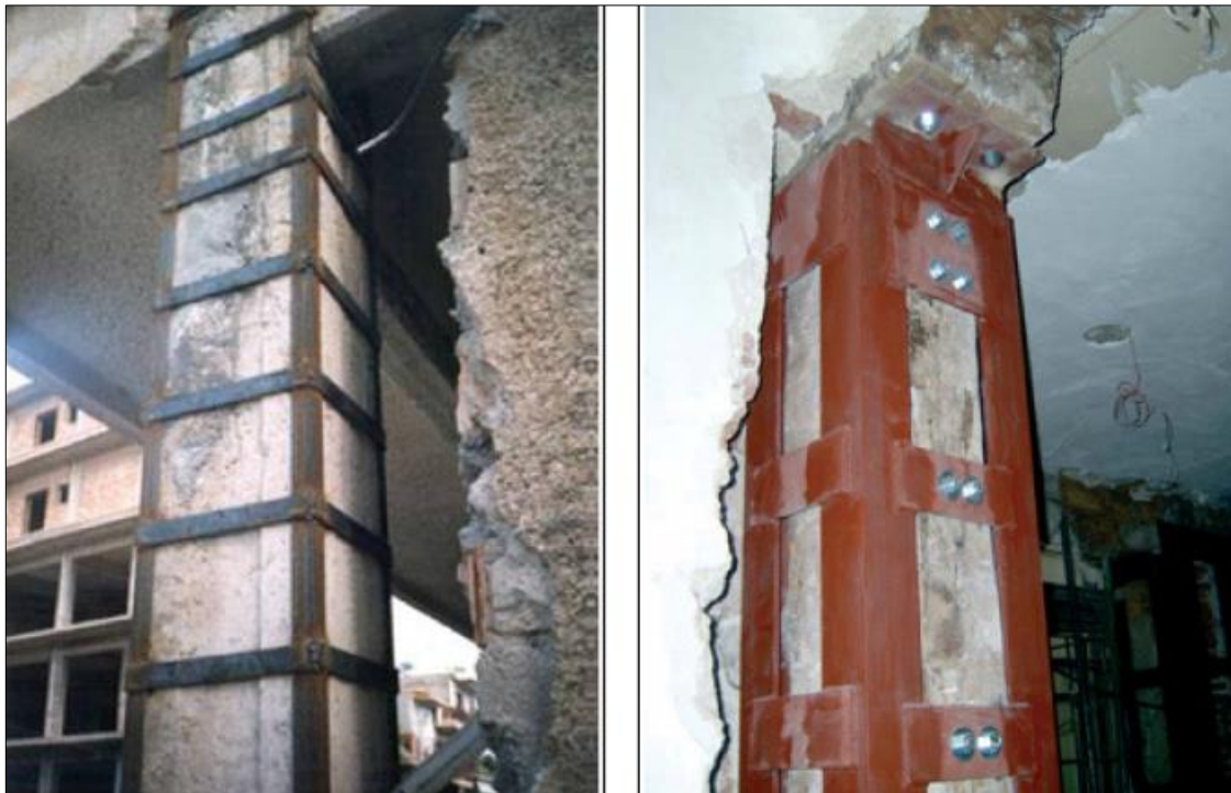
Figura 25: Refuerzo de columnas de edificación con angulares y presillas.
