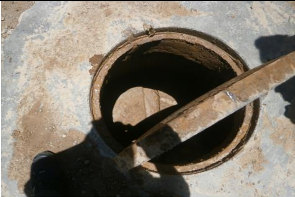
Anexo 27: Buzón Existente
