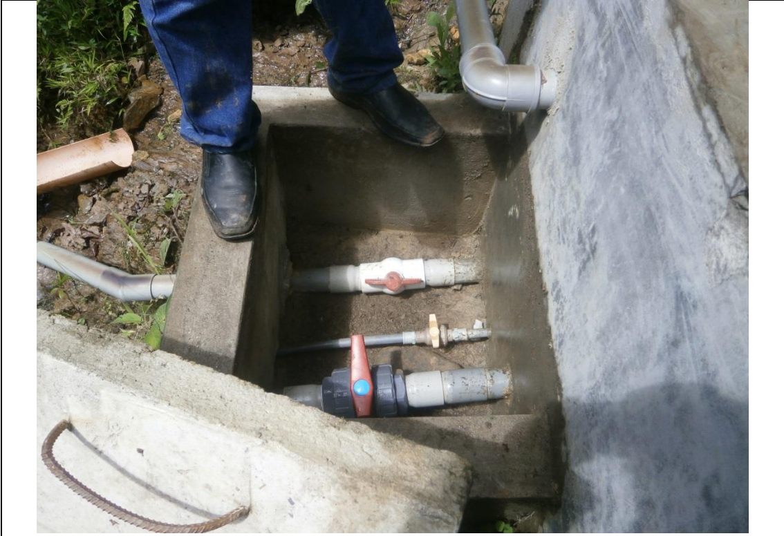
Anexo 33: Inspección Ocular de la Cámara Seca de la Obra de Captación
