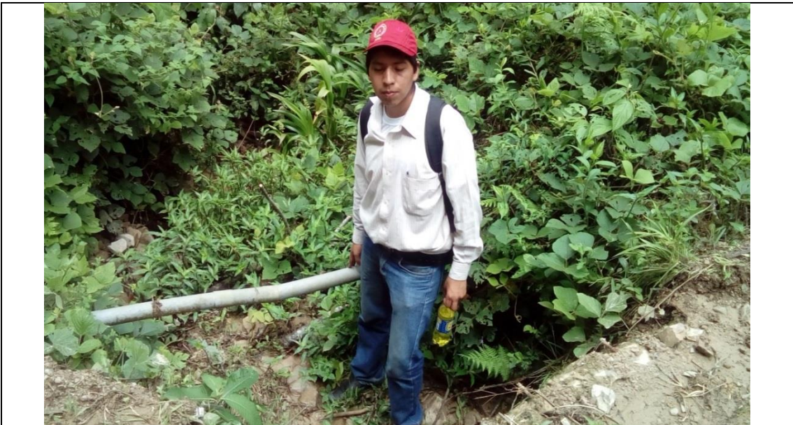
Anexo 20: Inspección de la Línea de Conducción Existente, Presencia de hongos Fuente: Elaboración Propia
