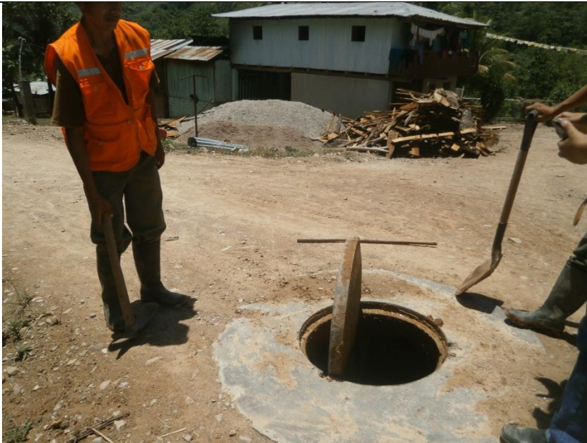
Anexo 23: Apertura de Buzón Existente
