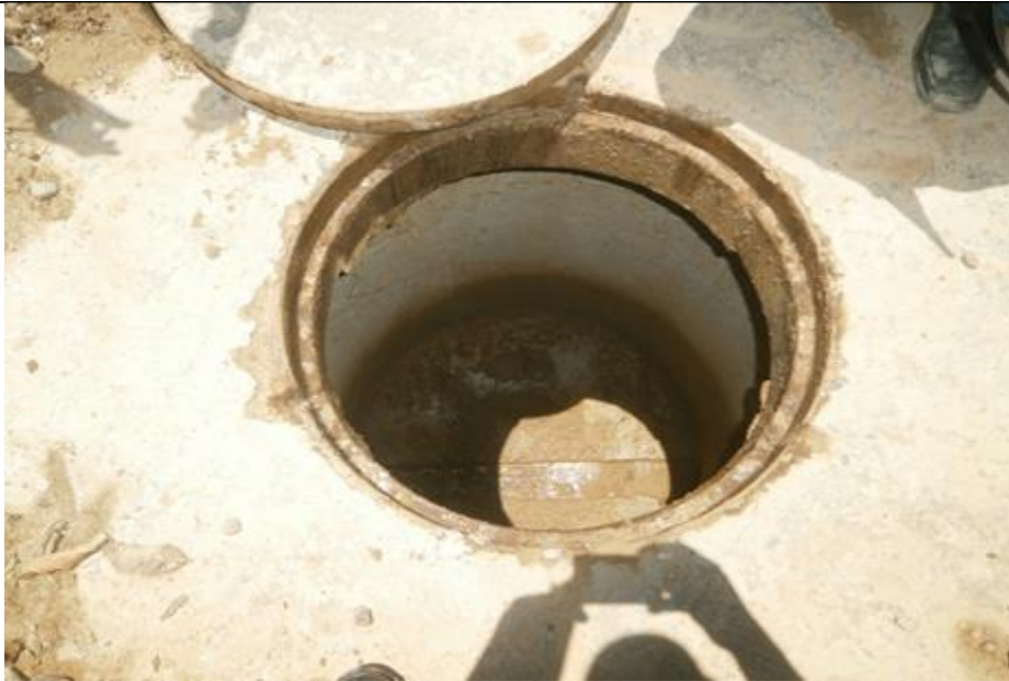
Anexo 25: Buzón existente
