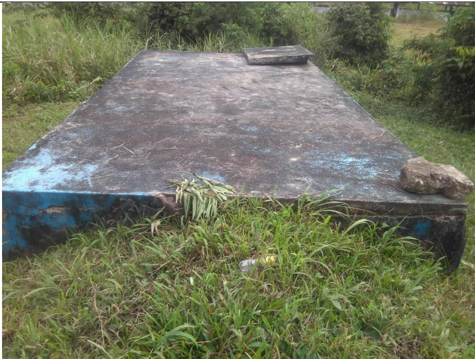
Anexo 26: Reservorio existente
