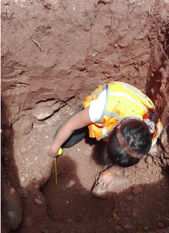
Figura 103. Test de percolación para determinación de UBS.
