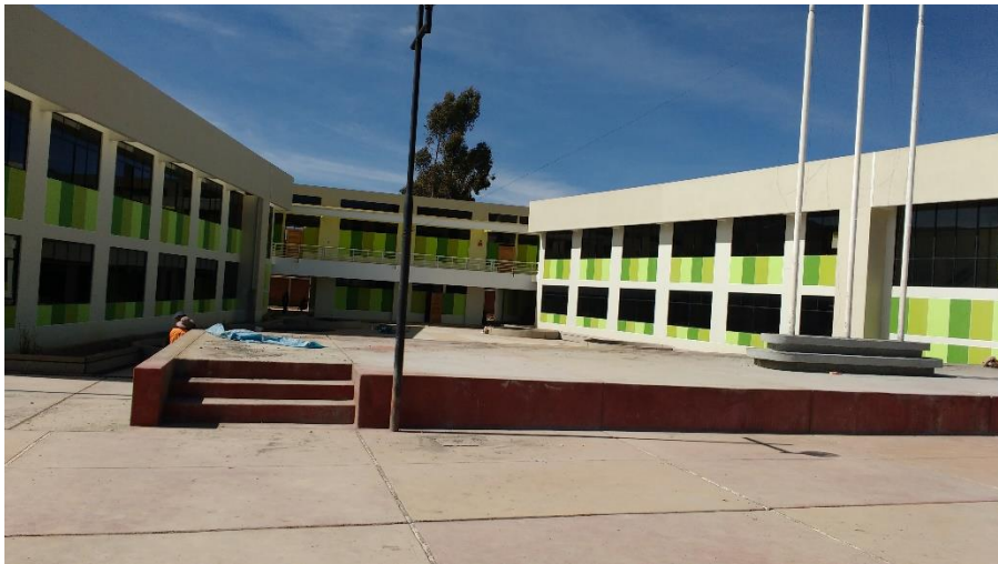
FOTOGRAFÍA N° 2: Instalaciones en construcción de la obra “Mejoramiento y ampliación de los servicios de educación secundaria en la I.E. Nuestra Señora De Cocharcas del Distrito De Paucará – Acobamba- Huancavelica”
