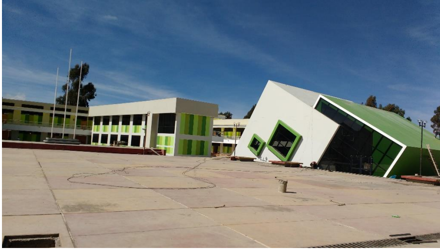
FOTOGRAFÍA N° 3: Instalaciones en construcción de la obra “Mejoramiento y ampliación de los servicios de educación secundaria en la I.E. Nuestra Señora De Cocharcas del Distrito De Paucará – Acobamba- Huancavelica”
