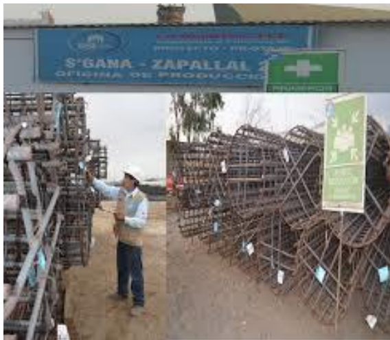
Imagen 9: Supervisión de pilotes
