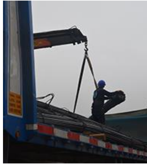
Imagen 14: Descarga de pilotes
