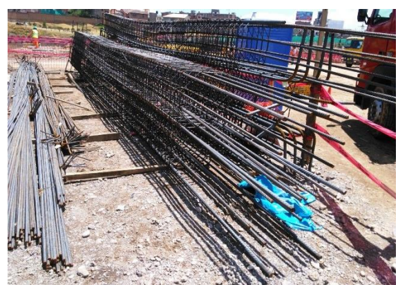
Imagen 6: Pilotes y columnas
