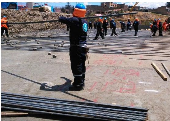
Imagen 11: cargar de acero de puñada
