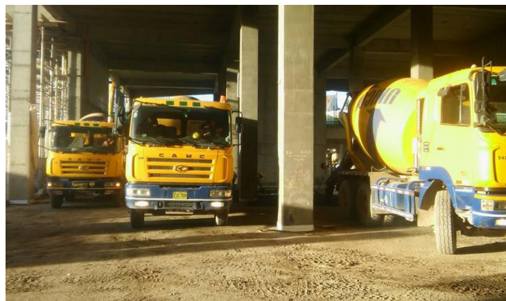
Imagen 28. Programación de camiones mixer en obra
