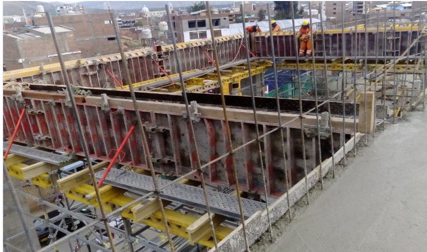
Imagen 37. Encofrado de viga
