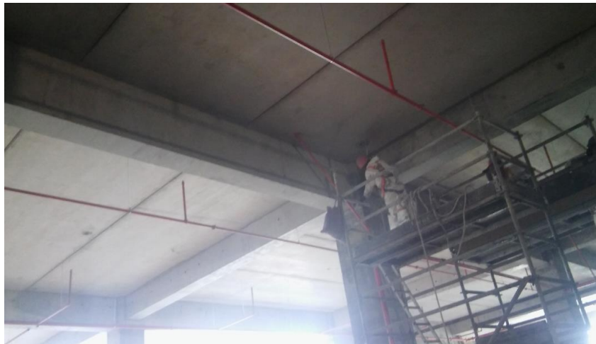
Imagen 100. Acabado de Losa con pre losa - Limpieza
