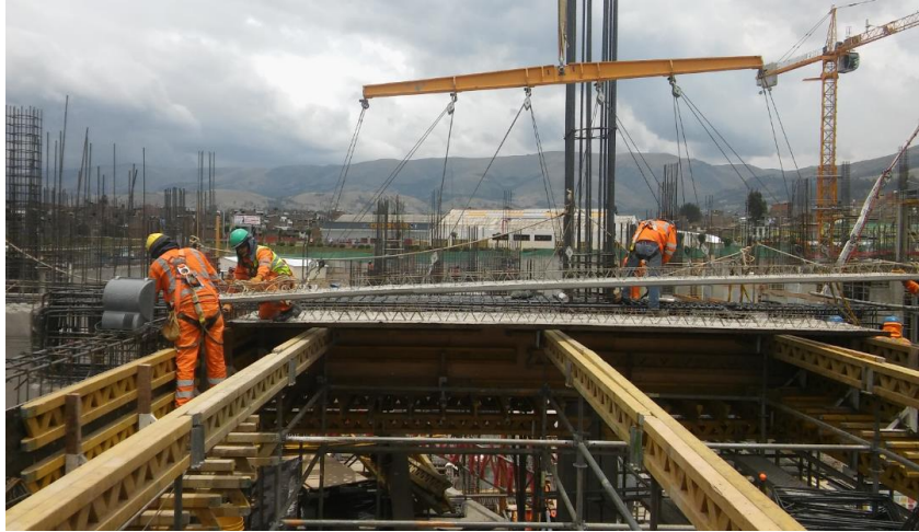
Imagen 41. Colocación de pre losas
