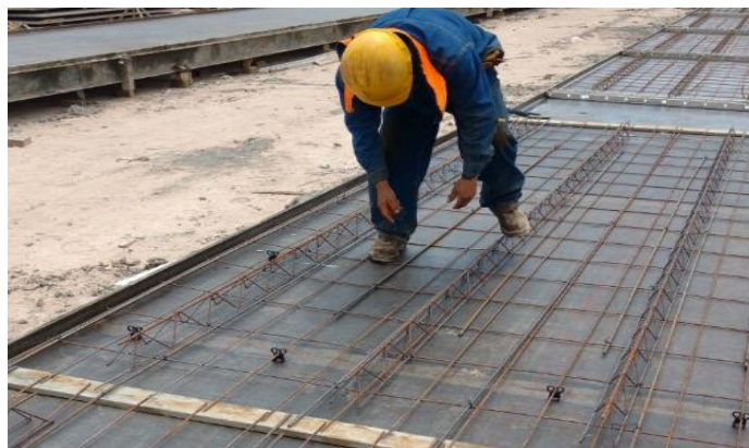
Imagen 54. Colocación de separadores
