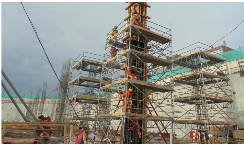
Imagen 25. Encofrado de verticales - columna
