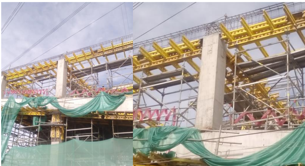
Imagen 33. Armado de acero en viga
