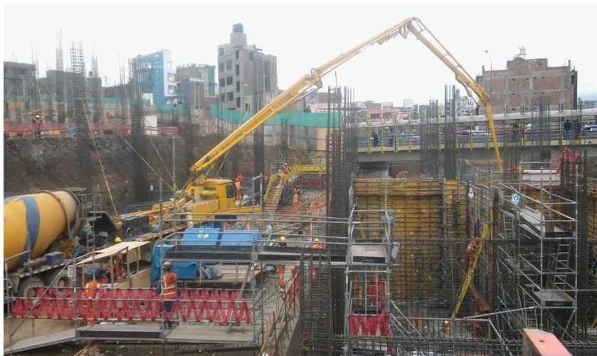
Imagen 30. Vaciado de placa con bomba
