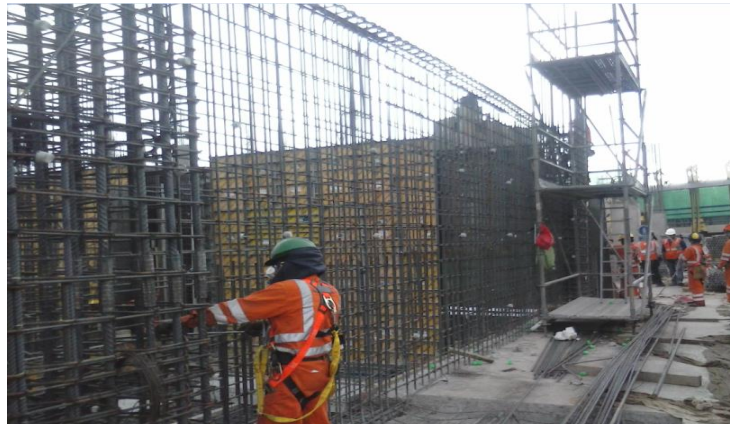
Imagen 22. Armado de elementos verticales - placa
