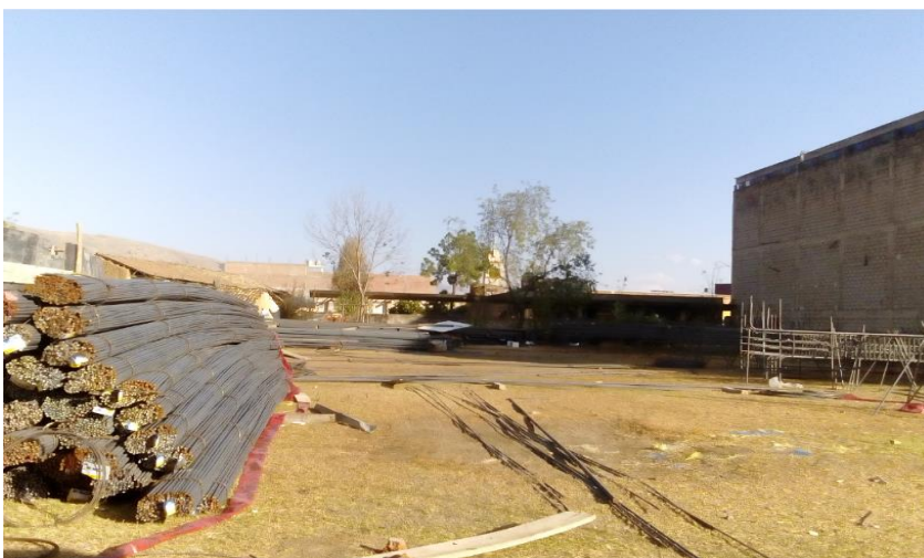
Imagen 49. Habilitación y armado de columna
