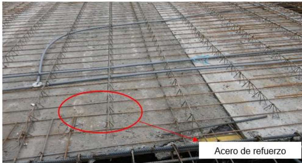
Imagen 82. Acero de refuerzo encima de pre losa
