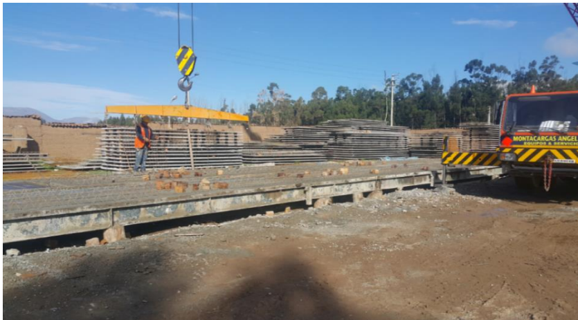
Imagen 56. Desmoldaje de pre losa
