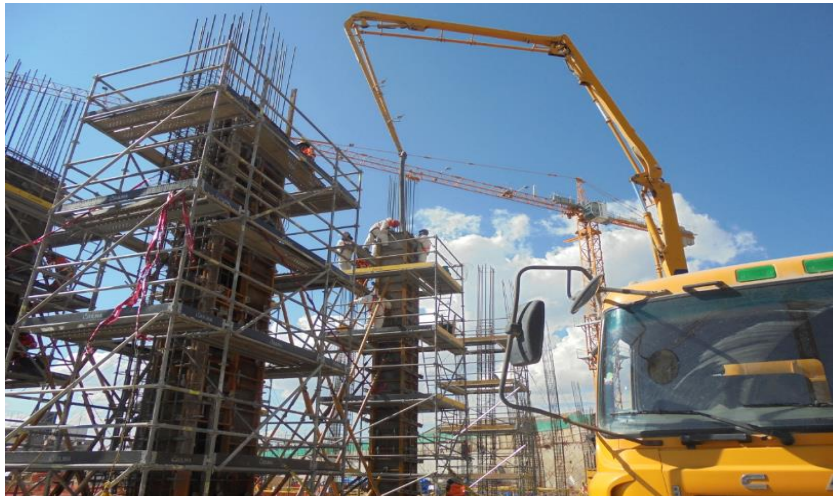
Imagen 29. Vaciado de columna con bomba
