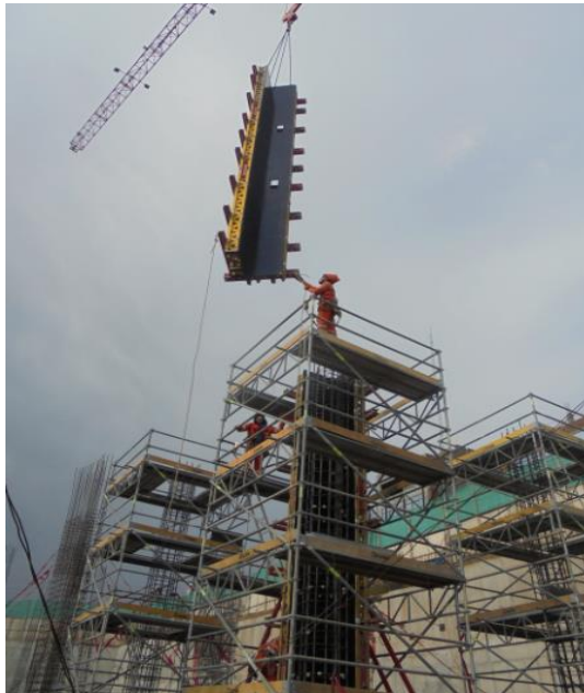
Imagen 24. Izaje de paneles - Encofrado para columna
