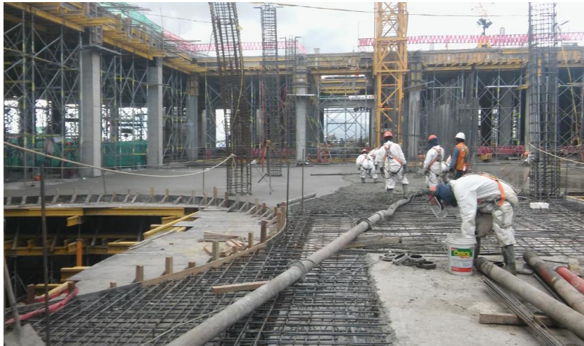
Imagen 48. Procedimiento de vaciado de losa
