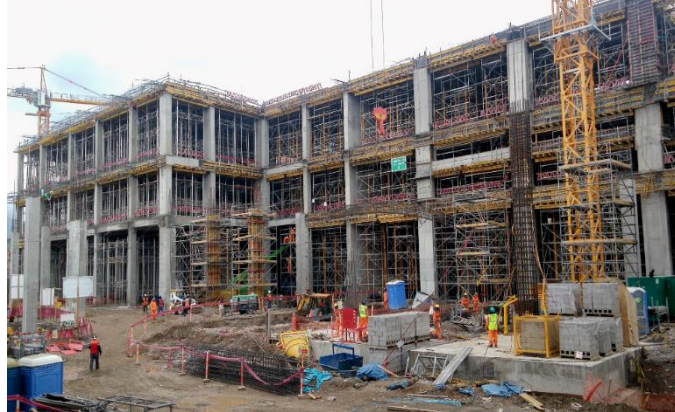
Imagen 5. Sistema constructivo industrializado
