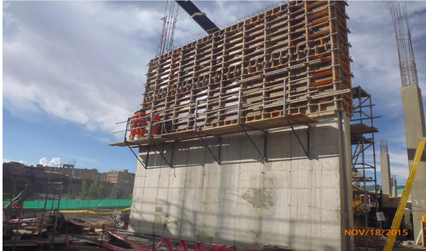
Imagen 26. Encofrado de verticales - placa
