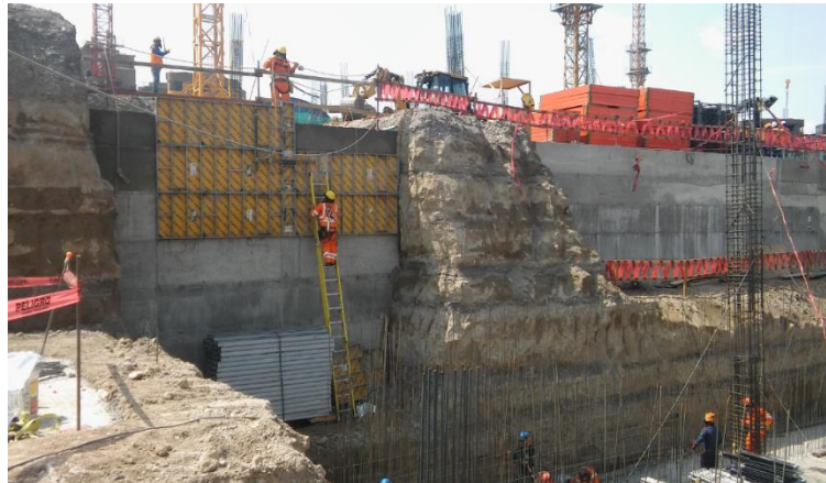
Imagen 27. Desencofrado de verticales – placas
