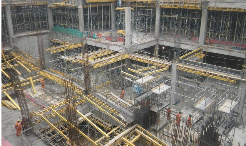
Imagen 38. Apuntalamiento de losas
