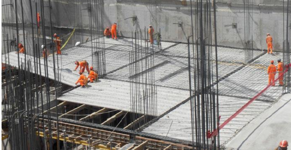
Imagen 2. Montaje de pre losa
