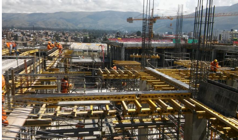
Imagen 32. Plataforma en parte inferior de viga
