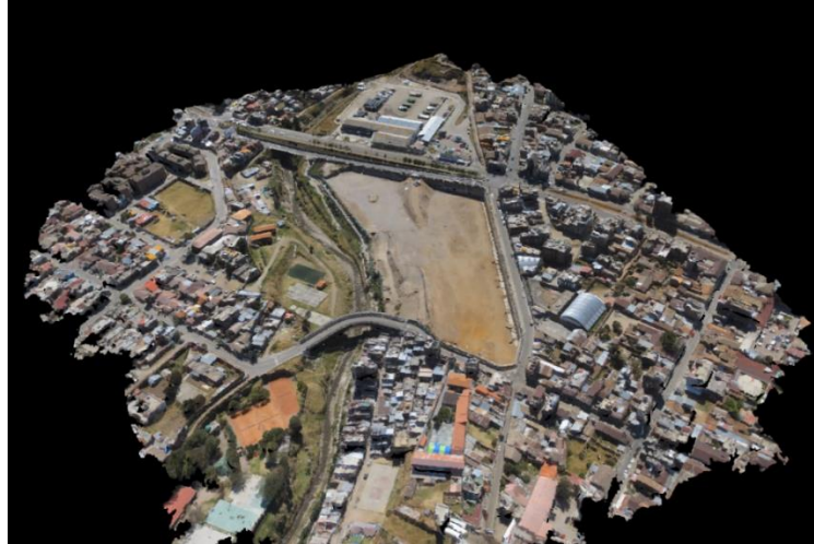
Imagen 13. Fotografía aérea del terreno
