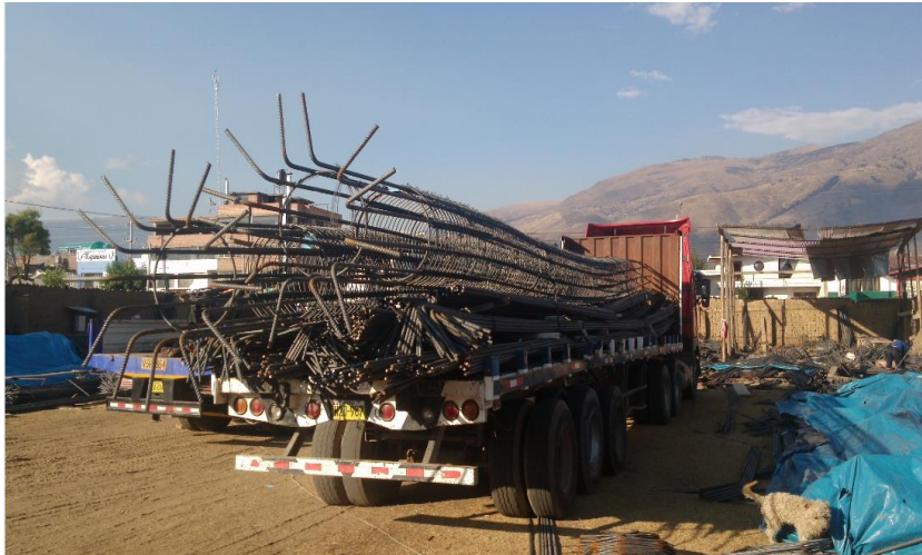
Imagen 50. Cargado de columna
