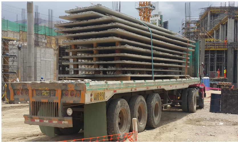
Imagen 59. Cargado de pre losas
