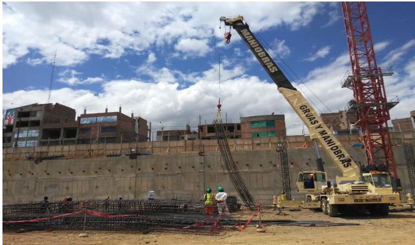
Imagen 21. Izaje de elemento vertical pre armado
