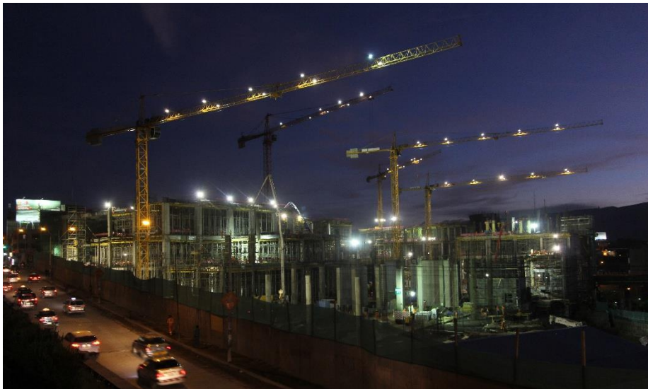
Imagen 97. Izaje de Prefabricados con torres grúa
