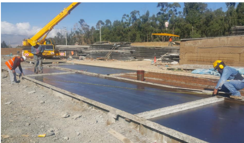
Imagen 52. Trazo y encofrado de pre losa
