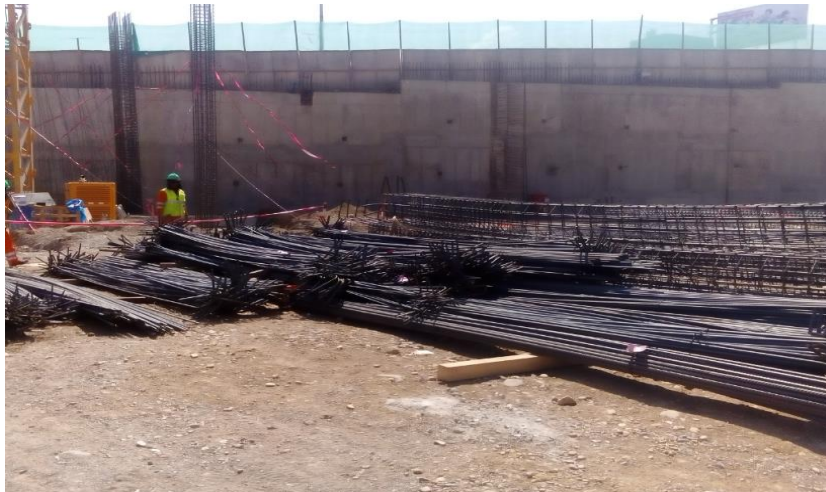
Imagen 20. Habilitación de acero en obra
