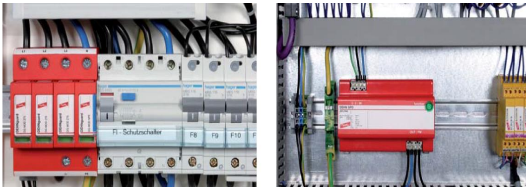
Gráfico 4. Modo de conexión en paralelo del DPS. Ejemplo: industria
