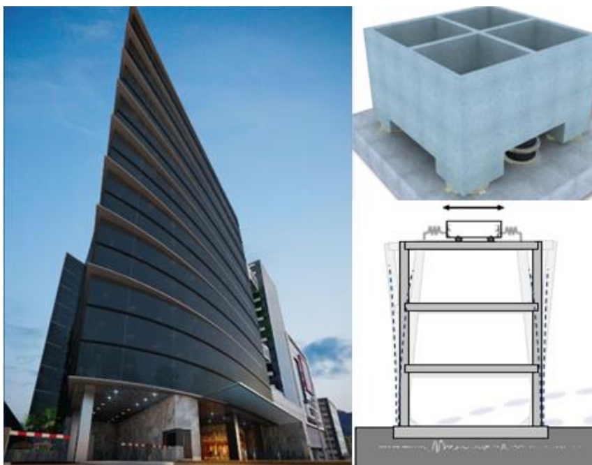
Imagen 8: Sistema Inercial acoplado en el edificio Holguín
