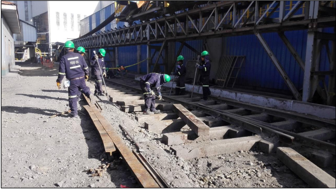
Fotografía 3: FCCA realiza la desinstalación de vía en el frente 1.
