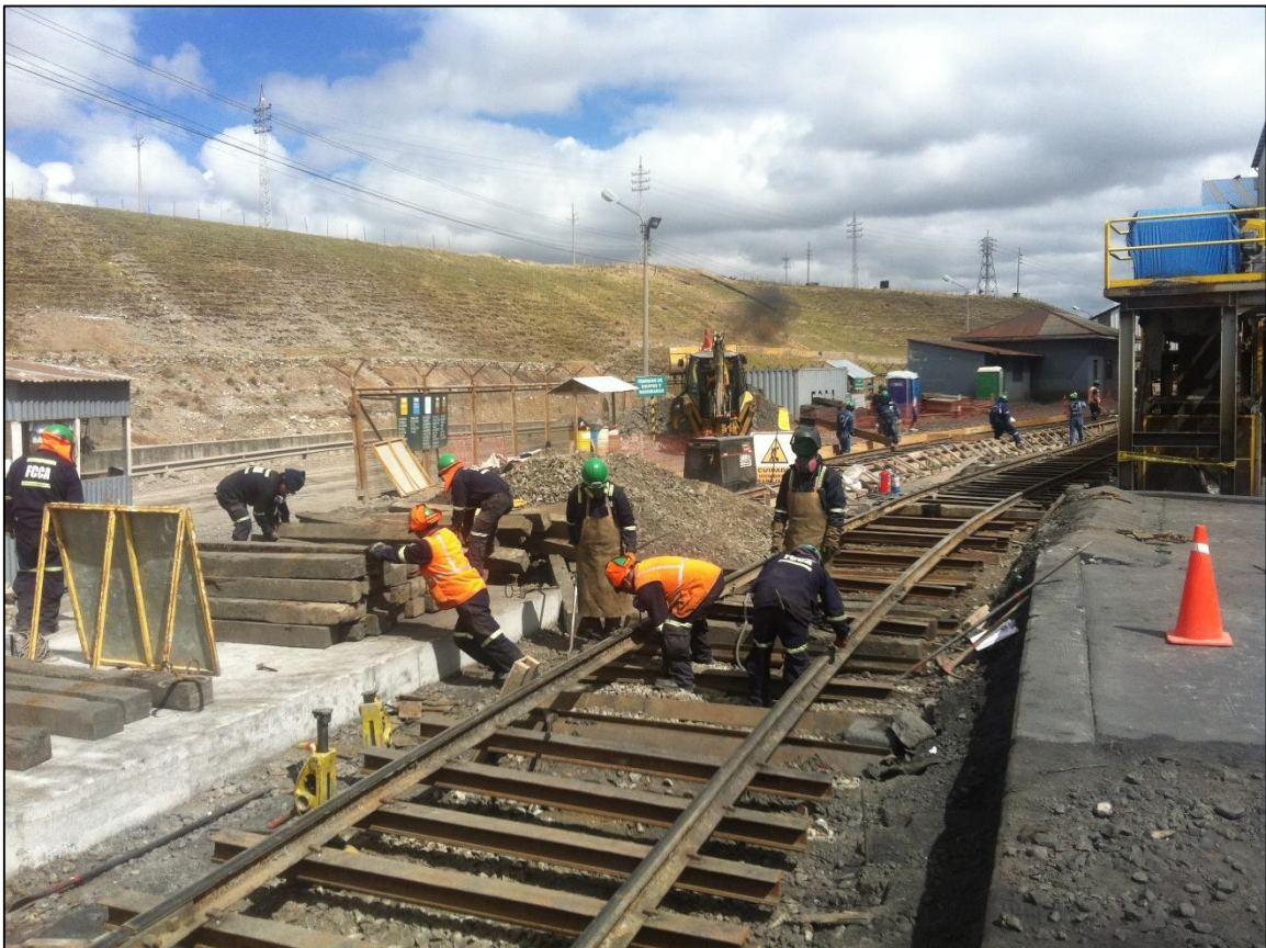
Fotografía 10: Ecosem libera el frente 3 y el FCCA instala la vía en el frente 4.
