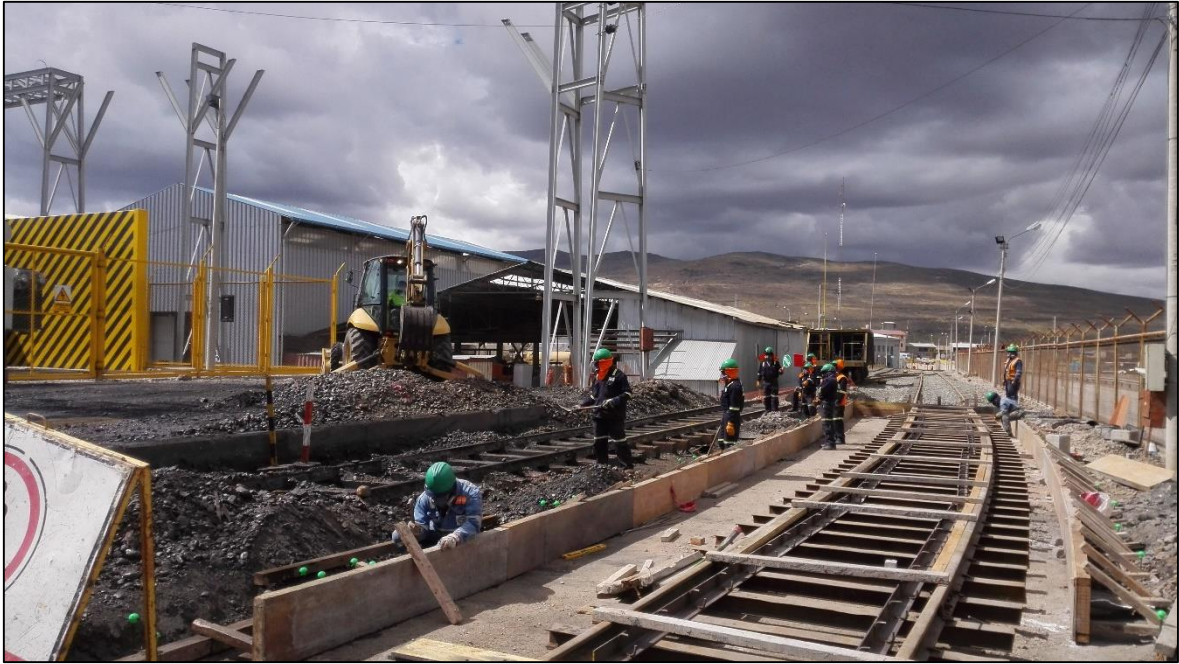
Fotografía 7: FCCA desinstala la vía en el frente 4 y la empresa Ecosem hace el encofrado en el frente 3.
