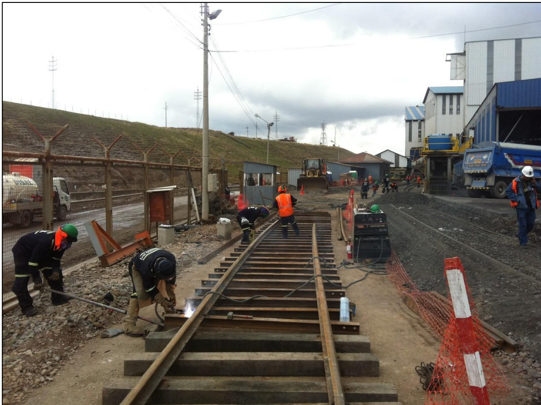
Fotografía 6: En el frente 3 se instala la vía y en el frente 4, el descajonado de vía férrea.
