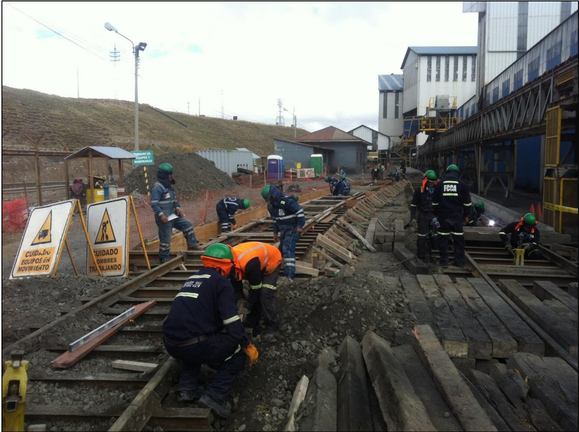
Fotografía 11: Ecosem realiza el encofrado del frente 2. El FCCA instala el frente 4 y desinstala el frente 3b.
