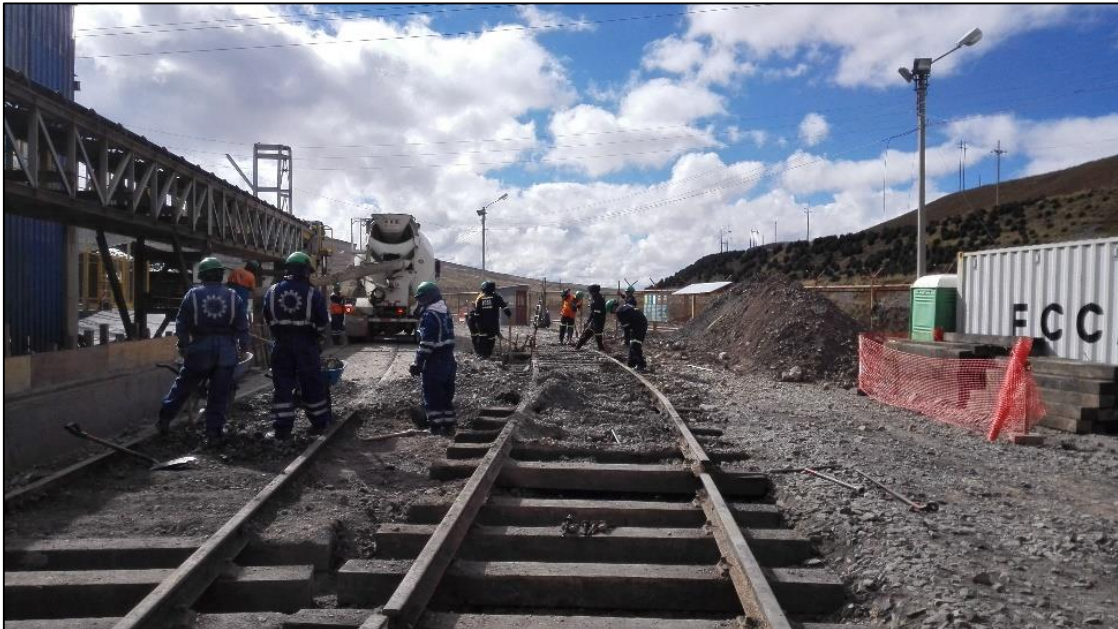
Fotografía 2: FCCA realiza el descajonado de vía y Ecosem vaciado de muro.
