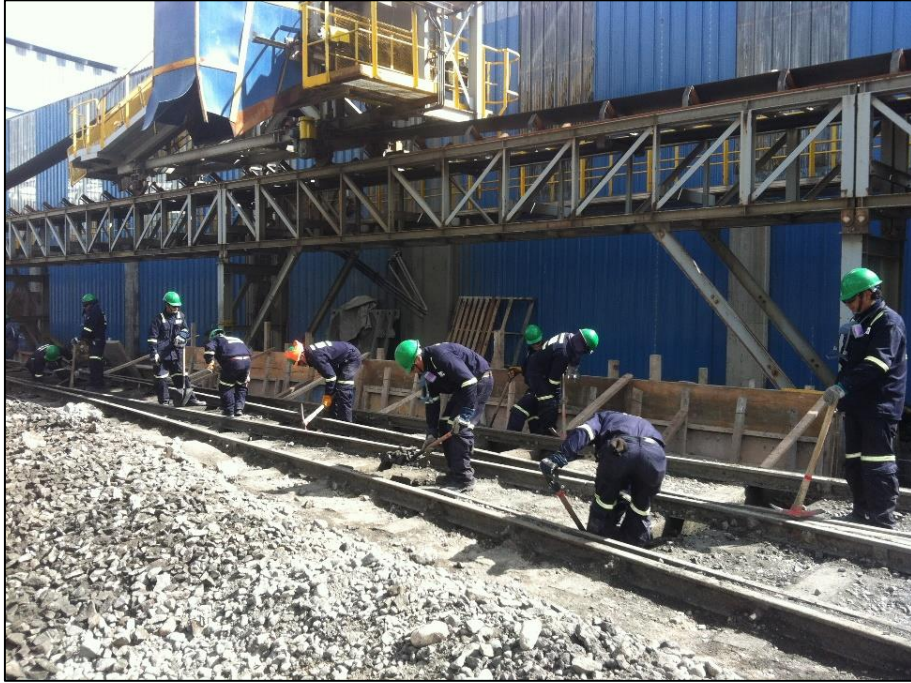
Fotografía 1: Se realiza la actividad de descajonado de vía en el frente 1.
