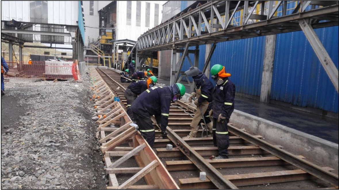
Fotografía 5: FCCA instala la vía férrea en el frente 1.
