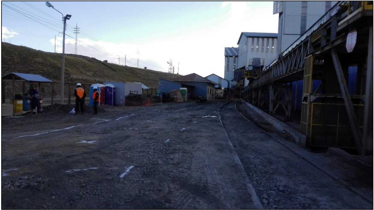
Figura 3-5: Vista general del proyecto.
