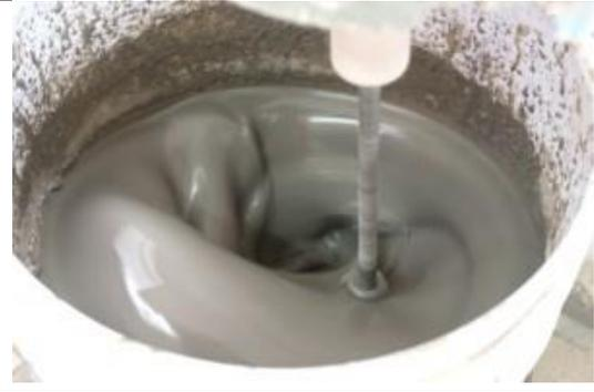
Mezcle hasta formar una pasta viscosa, consistente y sin grumos.
