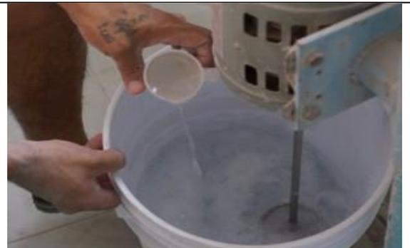
Determine la cantidad de agua, recordando que debe de agregar un máximo de 40 % de agua del total del material seco. Para los 20 Kg. de pasta seca use 8 litros de agua.
