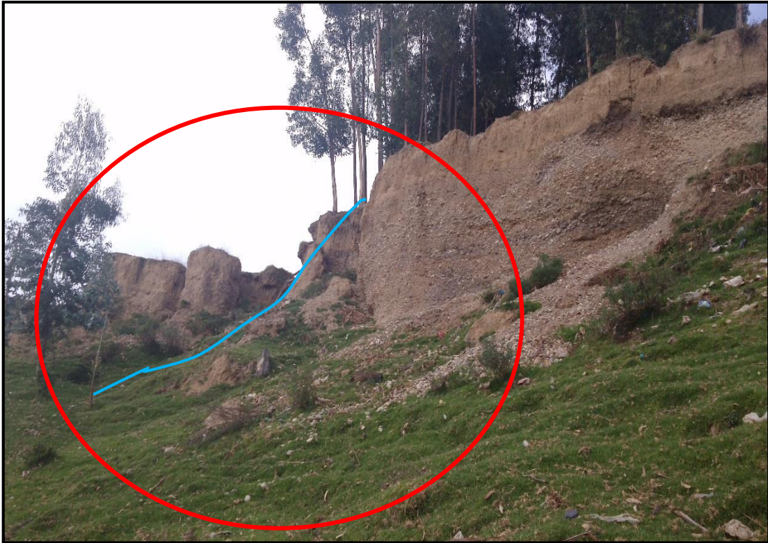
Fotografía 3 Vista del Talud y falla de desprendimiento
