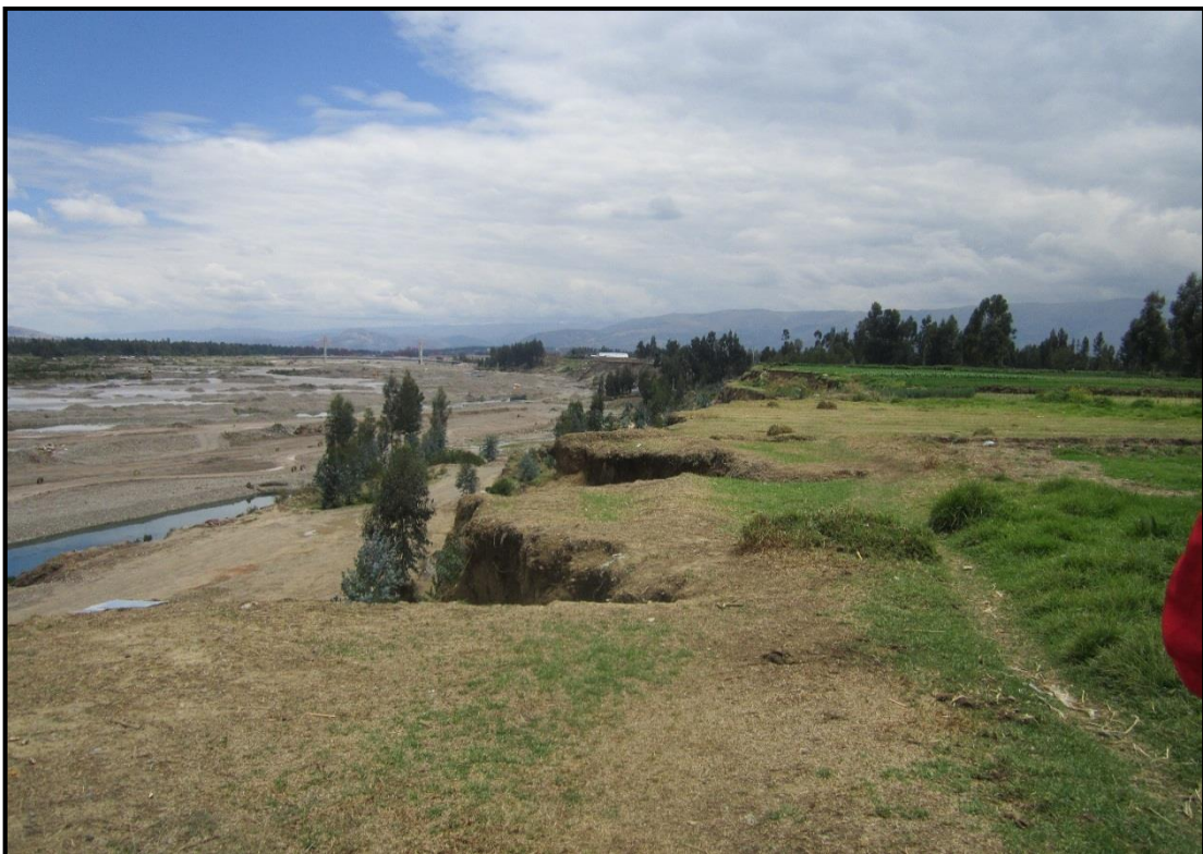
Fotografía 12 Vista de talud de la parte superior
