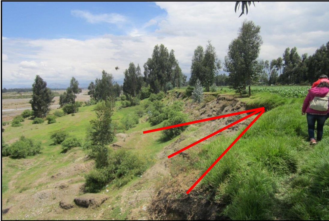
Fotografía 9 Vista de quebradas donde se presenta el deslizamiento
