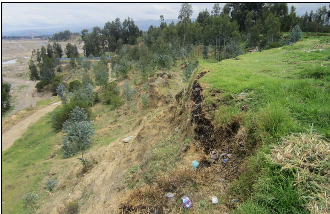
Fotografía 14 Talud protegido con vegetación existente
