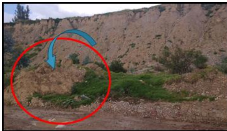
Figura 4: Deslizamiento real en la zona de estudio
