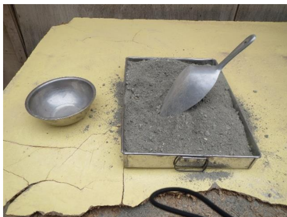
Figura 44: Medidas de agregado y cemento ya batidos.
