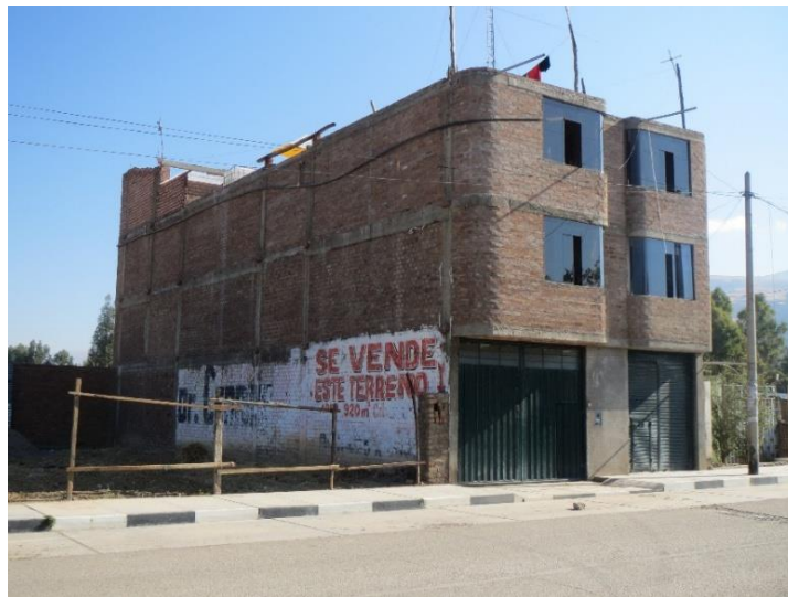
Figura 4: Vivienda típica de 3 pisos, ubicada al norte de la provincia de Huancayo.
