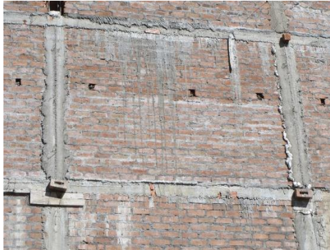
Figura 6: Muros con ladrillos artesanales
