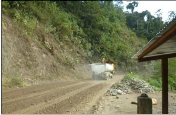
Figura 37. Incorporación de dilución agua y Proes a la mezcla en seco
