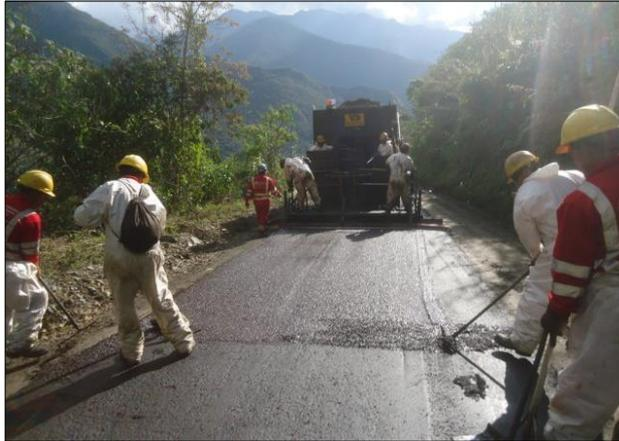
Figura 46. Slurry Seal en la base estabilizada
