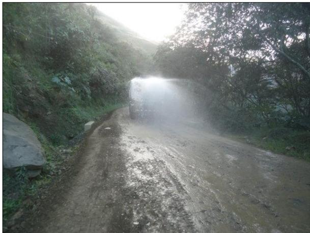
Figura 42. Sellado de la base estabilizada
