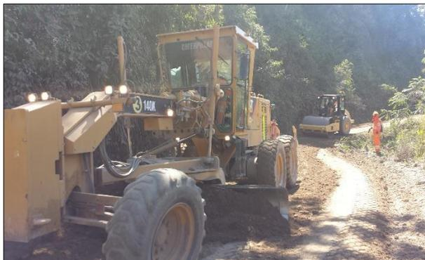
Figura 39. Conformación de la base estabilizada
