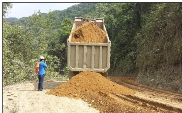
Figura 27. Recarga de material a estabilizar
