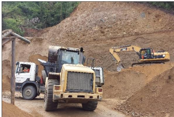
Figura 26. Extracción de cantera, zarandeo y carguío de material con plasticidad
