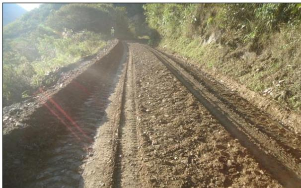
Figura 38. Mezclado aditivo líquido Proes, con material de recarga y Rocatech 70/30
