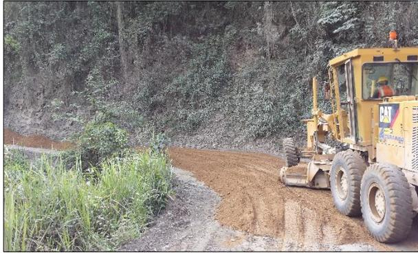
Figura 28. Tendido de material a estabilizar
