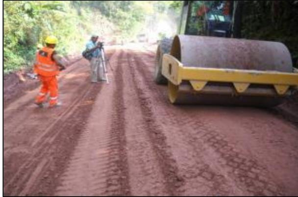
Figura 9. Compactación con rodillo vibratorio <sup>(26)</sup>.
