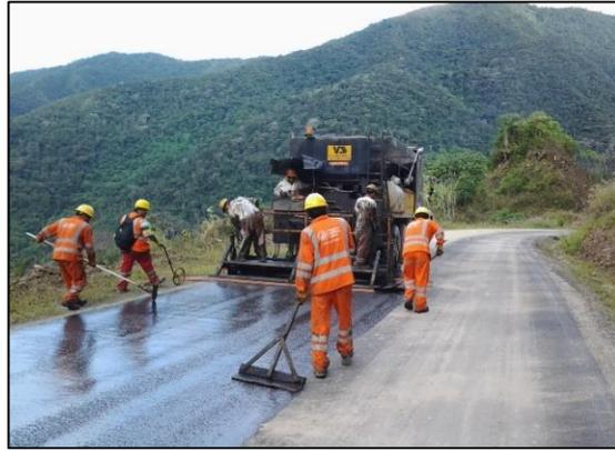
Figura 13. Lechada asfáltica (*slurry seal*)
