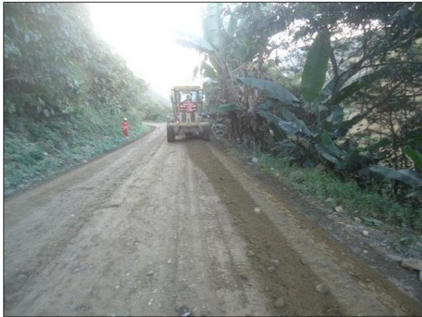
Figura 41. Refine de la base estabilizada
