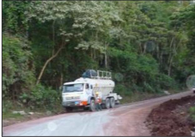
Figura 4. Aplicación aditivo sólido con camión esparcidor <sup>(26)</sup>.
