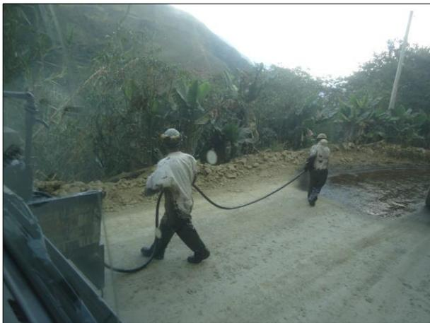
Figura 45. Riego de liga de la base estabilizada
