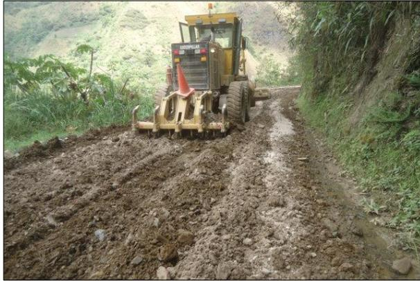
Figura 34. Escarificado de material con Rocatech 70/30
