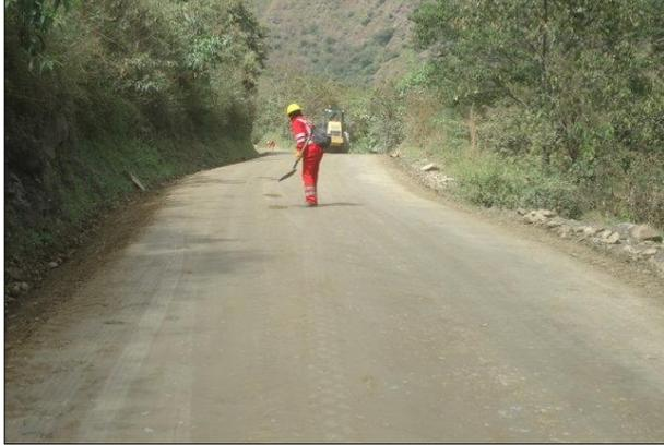
Figura 43. Sellado de huecos en la base estabilizada
