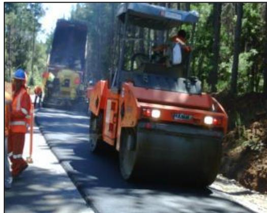
Figura 14. Colocación de mezcla asfáltica <sup>(26)</sup>.
