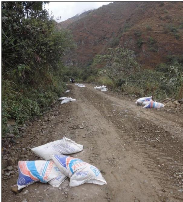
Figura 32. Rocatech 70/30 en bolsas, separado con la longitud correspondiente
