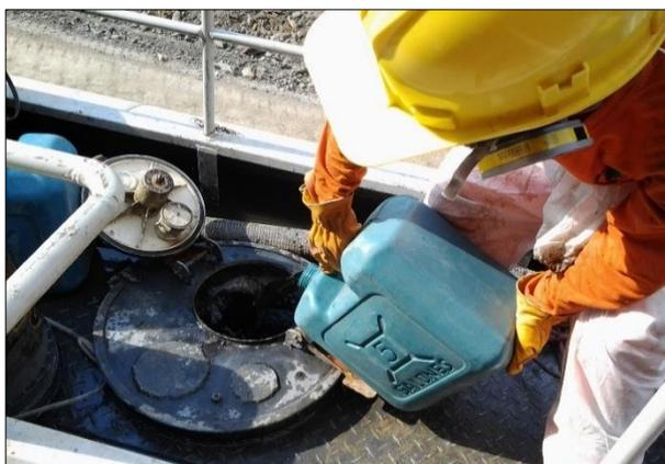
Fig. 36. Adición del aditivo líquido (Proes 100) en la cisterna con agua
