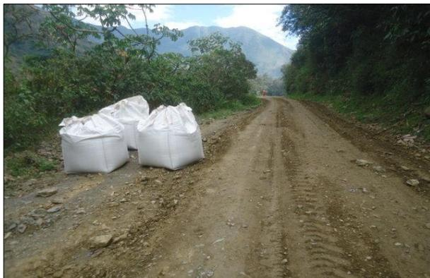
Figura 29. Rocatech 70/30 en big bag, separado con la longitud correspondiente
