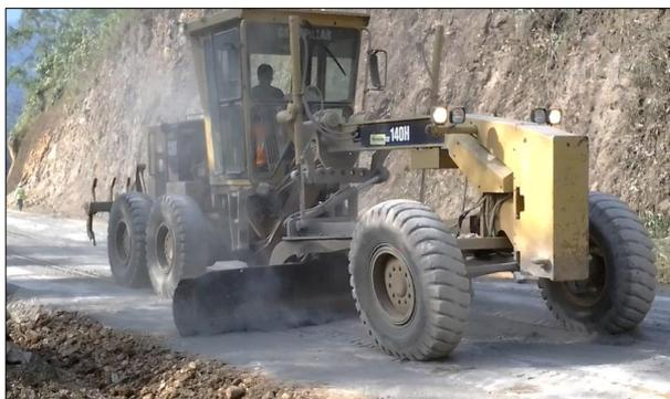
Figura 33. Tendido de Rocatech 70/30 en la plataforma a estabilizar
