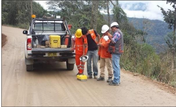
Figura 49. Control de compactación de la base con densímetro nuclear
