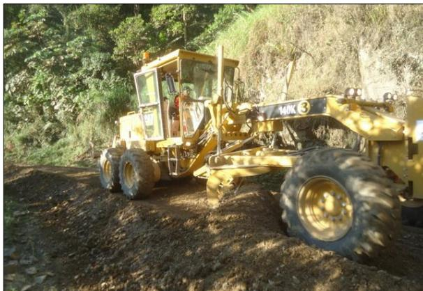
Figura 35. Mezclado de material de cantera con Rocatech 70/30 en seco
