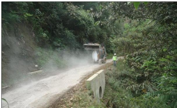
Figura 30. Aplicación del Rocatech 70/30 en la plataforma a estabilizar
