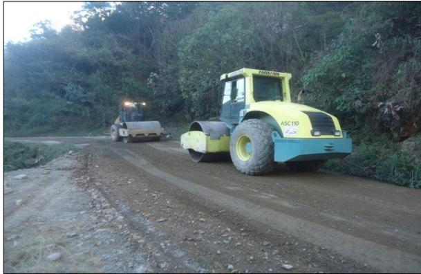
Figura 40. Compactación de la base estabilizada
