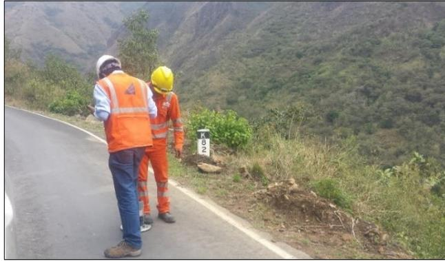
Figura 58. Medición con LWD en la base estabilizada a los 14 meses
