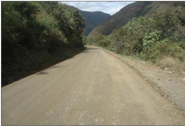
Figura 44. Acabado de la base estabilizada sin recubrimiento
