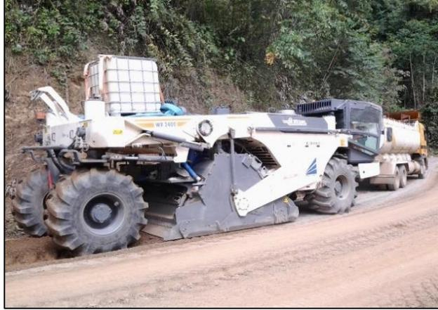
Figura 8. Mezclado con recicladora y cisterna
