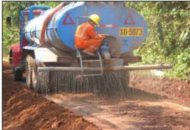
Figura 6. Adición aditivo líquido Proes <sup>(26)</sup>.
