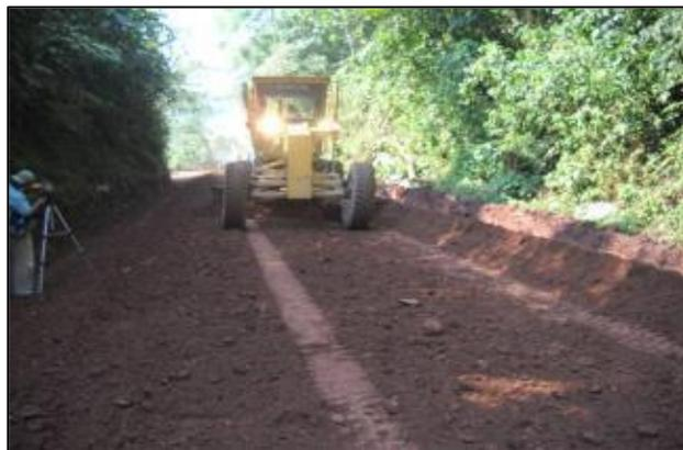
Figura 7. Mezclado aditivo líquido Proes con suelo <sup>(26)</sup>.
