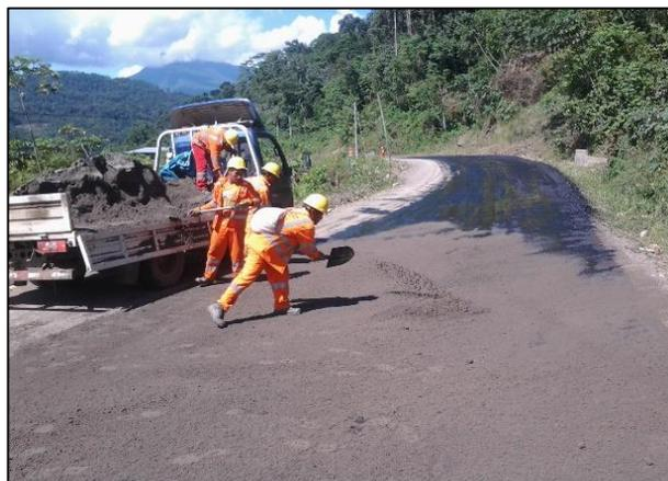
Figura 12. Imprimación asfáltica reforzada
