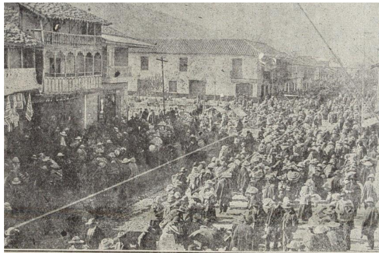
Fotografía. Plano general de la esquina del jirón Puno y la Calle Real visto de norte a sur. En la imagen se ve la Casa Castillo en un día de feria. Año, 1916. Diario "Pulso". Huancayo, 30 de setiembre de 1965, pp. 3.
