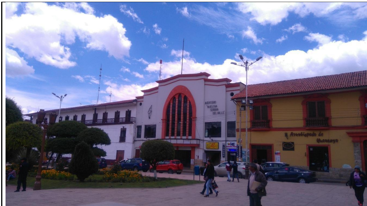
Fotografía. Estado actual del "Teatro Central", que sufrió un incendio en julio de 1986. Un año después volvió a abrir sus puertas con algunas modificaciones en la fachada y el interior. Hoy en día tiene la denominación de "Auditorio nuestra señora del valle". Año: 2015. Autor: Wari O. Gálvez.
