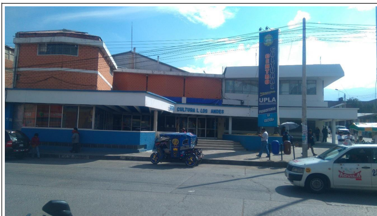
Fotografía. Estado actual del inmueble que funcionó como "Cine Mantaro". Funciona actualmente como un centro cultural inconstante y sin criterio. Por las características arquitectónicas y su relativa antigüedad podría ser el lugar apropiado para la sede de una filмотeca nacional. Año: 2015. Autor: Wari O. Gálvez.
