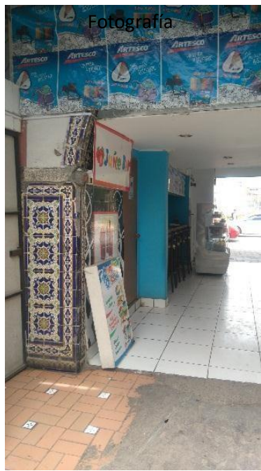
Fotografía. Plano entero del estado actual del arco que daba al ingreso del patio del Hotel
