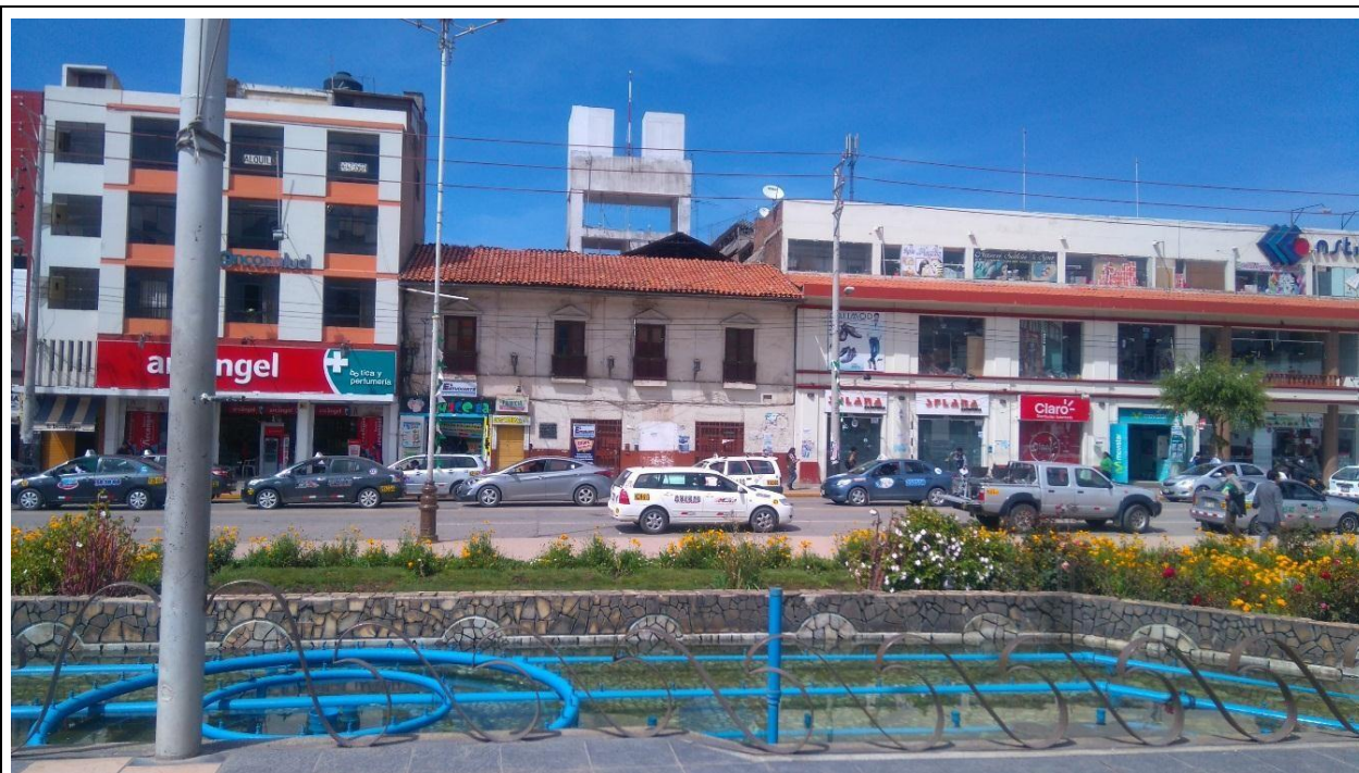
Fotografía. Inmueble actual en estado deprimido donde, a partir de la década de 1920, funcionó el Hotel Colón y el Cinema Teatro en uno de sus ambientes interiores. Año: 2015. Autor: Wari O. Gálvez.
