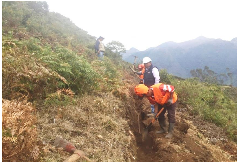
Figura 62: Vista Fotográfica donde se aprecia los trabajos de relleno y compactado de zanjas
