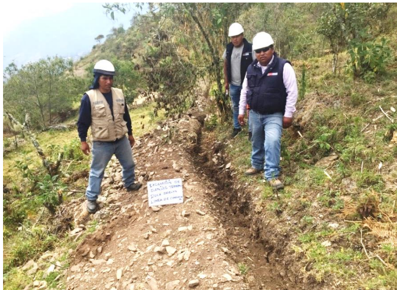
Figura 59: Vista Fotográfica en donde se aprecia la excavación de terreno semirocoso
