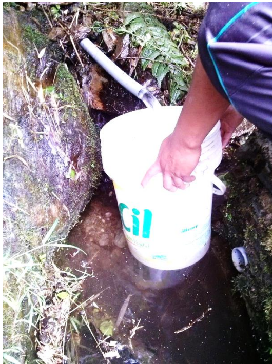
Figura 7: Captación quebrada "Chocton".
