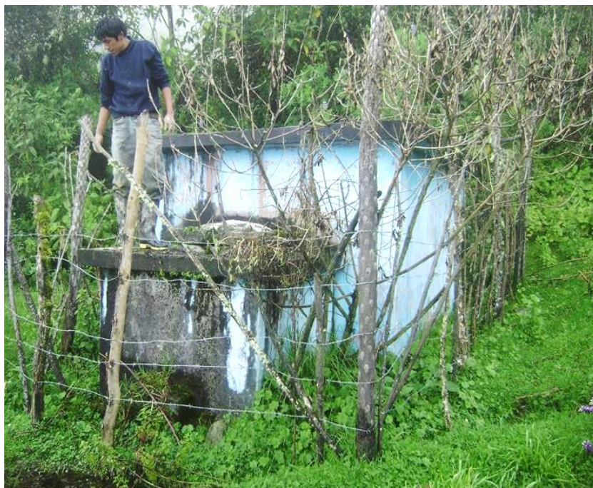
Figura 11: Reservorio apoyado de 6.00 m 3 de capacidad.
