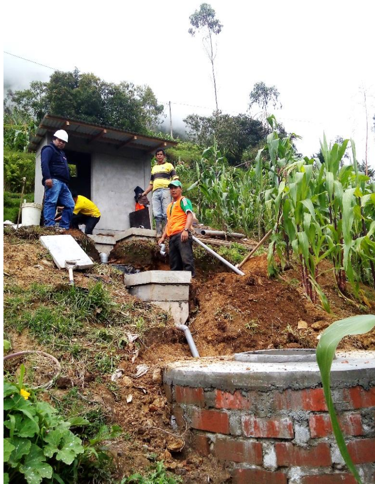
Figura 131: Vista fotográfica de instalación de cajas prefabricadas para tratamiento de aguas grises
