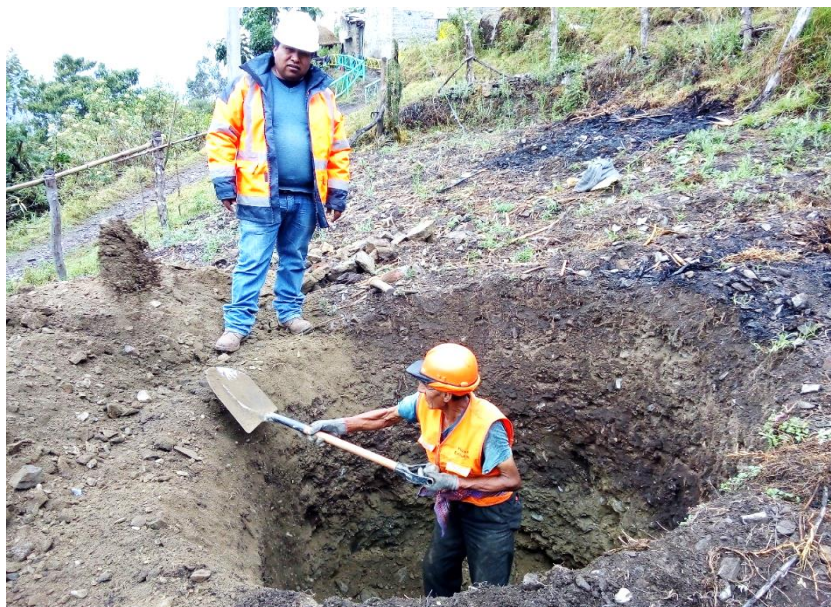
Figura 127: Vista fotográfica en proceso de excavación de hoyos para biodigestores
