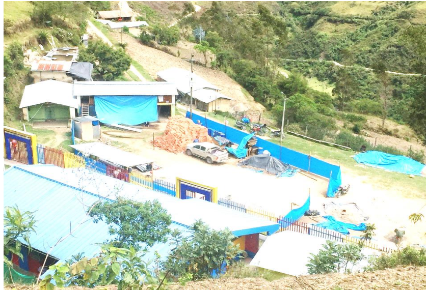
Figura 45: Vista fotográfica de campamento, oficinas y almacenes
