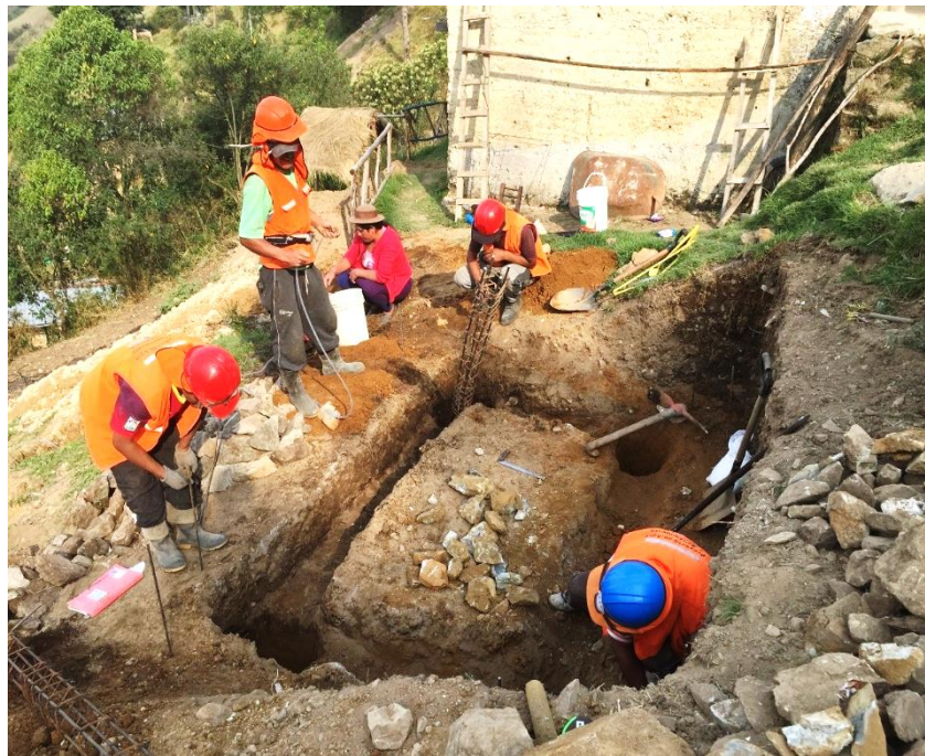
Figura 105: Vista fotográfica en proceso de excavaciones de cimientos corridos en UBS
