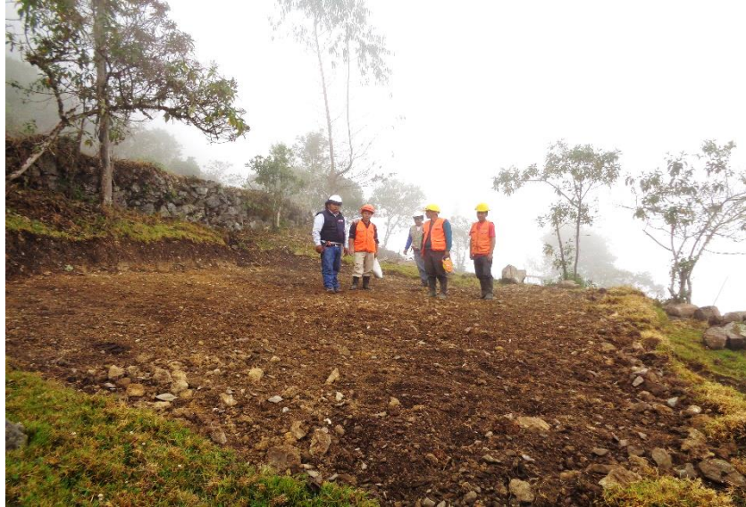
Figura 70: Vista fotográfica en trabajos preliminares en reservorios
