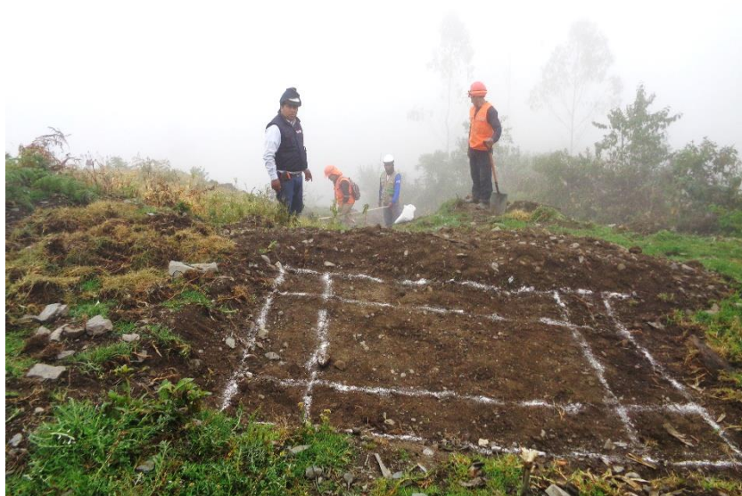
Figura 65: Trabajos de trazo y replanteo en CRP tipo VI
