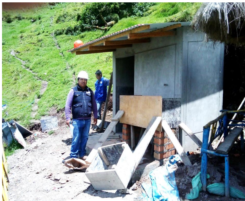
Figura 100: Vista fotográfica de verificación de vaciado de lavaderos
