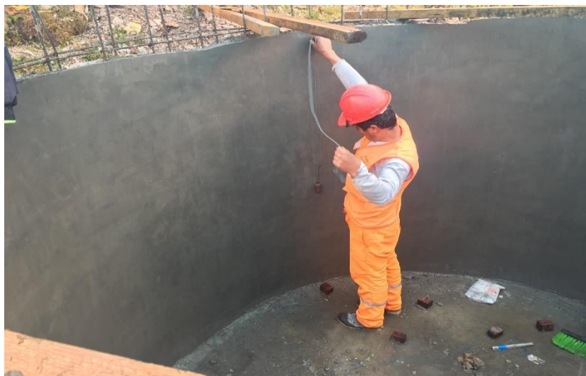
Figura 78: Vista fotográfica en proceso de verificación de revestimientos en reservorios
