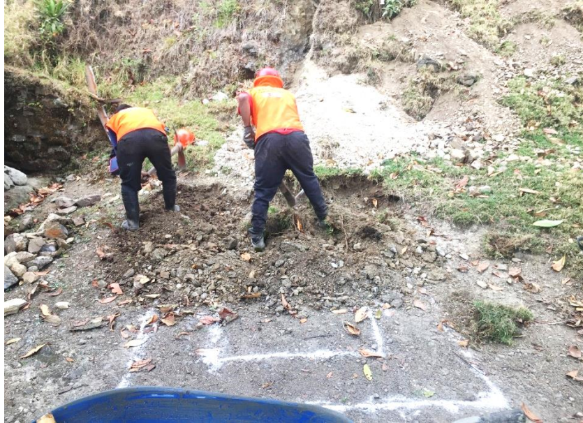
Figura 93: Vista fotográfica en los trabajos de excavación manual para CRP tipo
