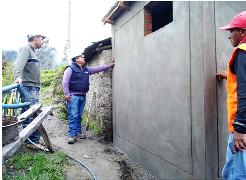
Figura 119: Vista fotográfica de verificación de revestimientos exteriores en UBS
