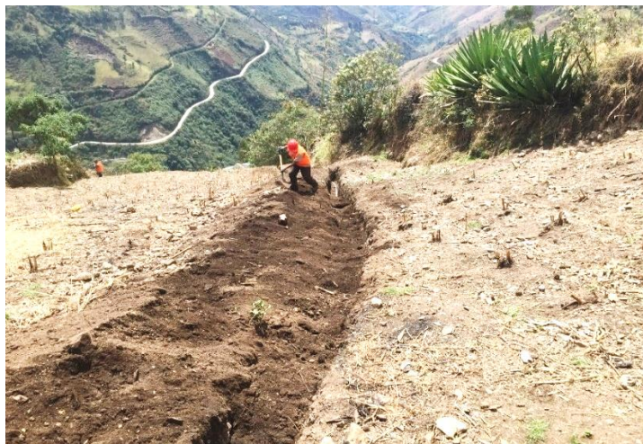
Figura 90: Vista Fotográfica donde se aprecia los trabajos de relleno y compactado
