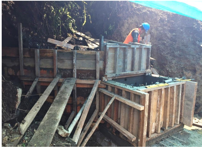
Figura 50: Vista Fotográfica de Encofrado en Captación
