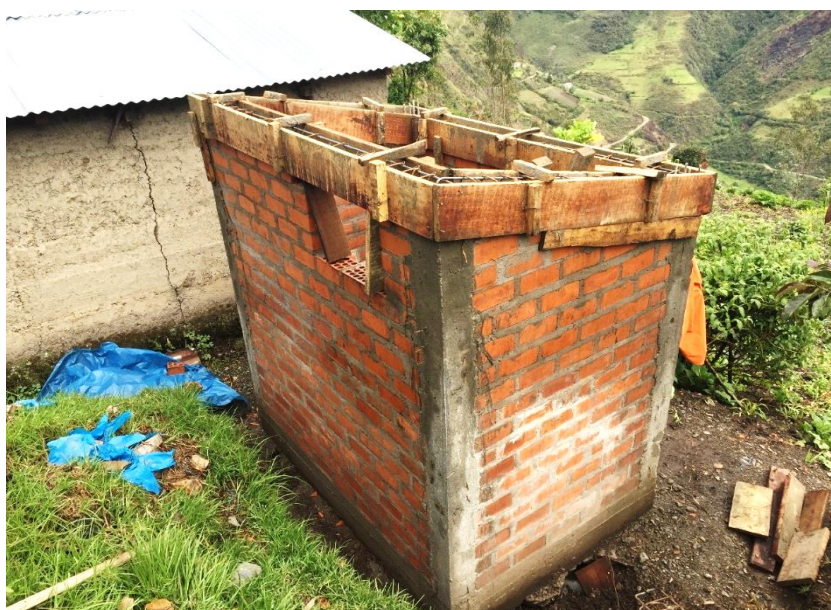
Figura 115: Vista fotográfica donde se aprecia el vaciado de vigas de UBS
