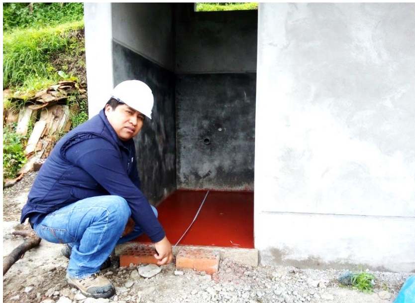
Figura 120: Vista fotográfica de verificación de vaciado de Pisos de UBS
