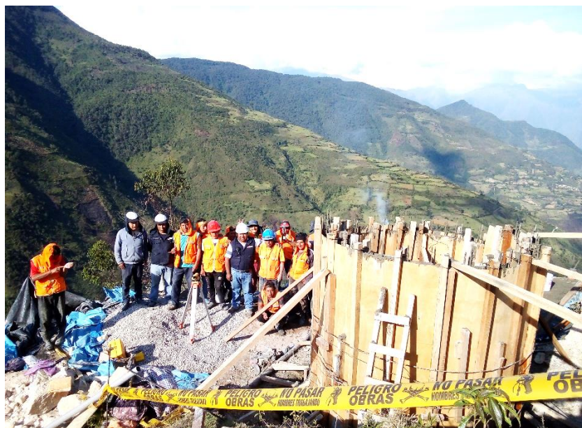
Figura 77: Vista fotográfica con personal de obra en el término de vaciado en reservorios
