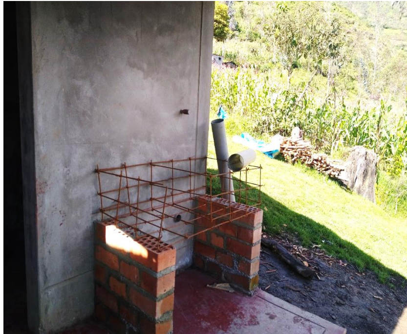
Figura 99: Vista fotográfica de colocado de aceros en lavaderos
