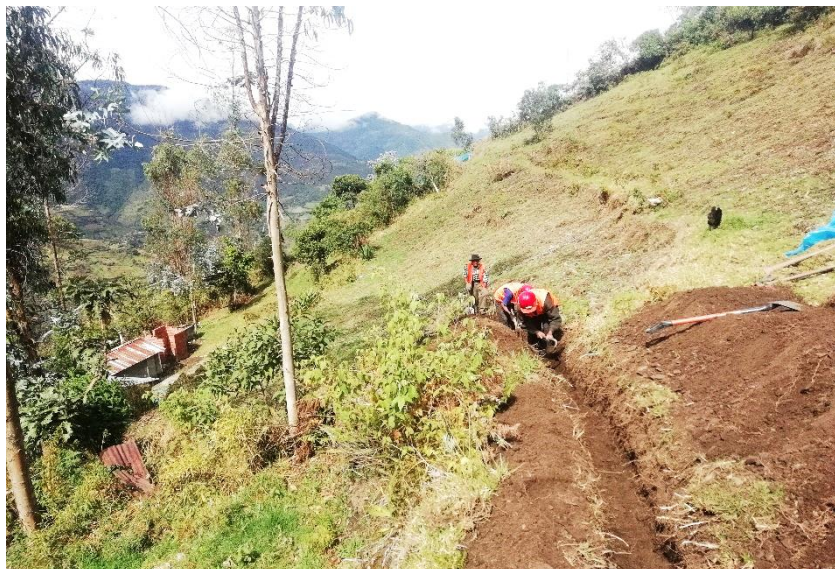
Figura 86: Vista Fotográfica de excavación de terreno normal
