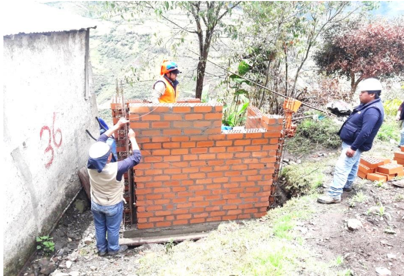
Figura 112: Vista fotográfica en la verificación de levantamiento de muros en UBS
