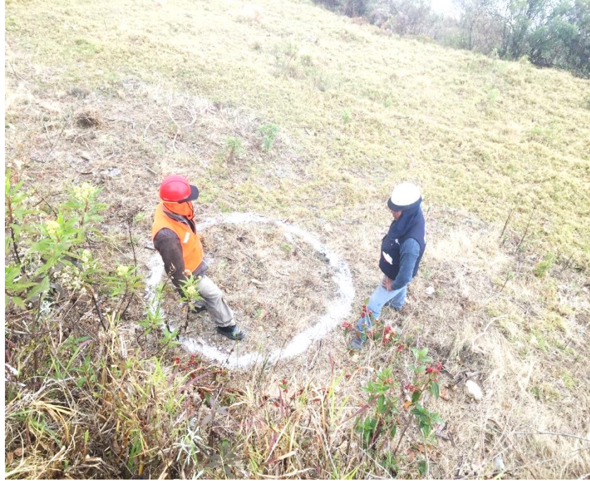
Figura 126: Vista fotográfica en la ejecución de trazos para excavaciones de biodigestor
