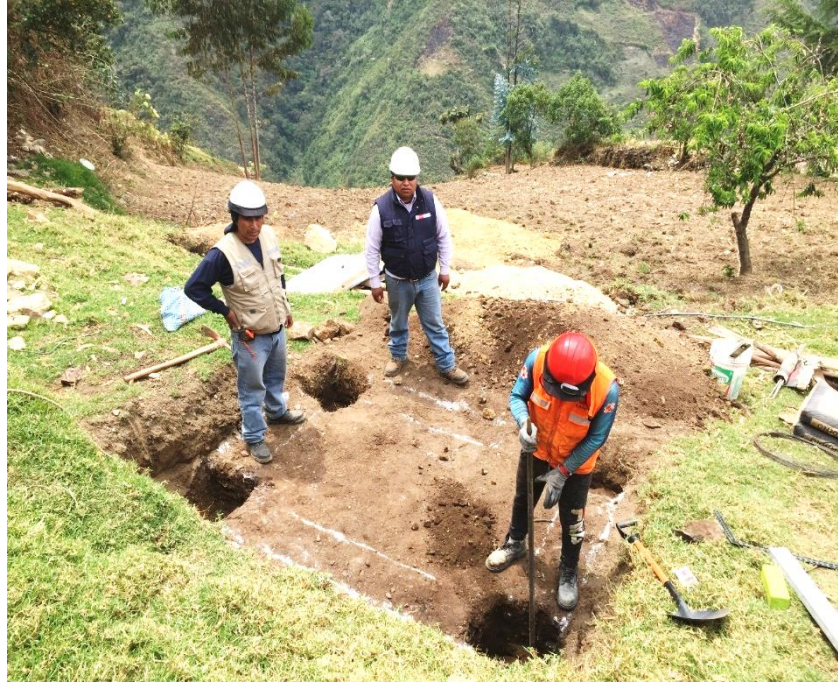
Figura 104: Vista fotográfica en proceso de excavaciones de columnas en UBS
