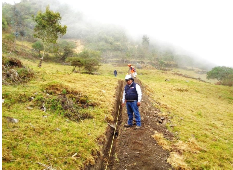
Figura 58: Vista Fotográfica de excavación de terreno normal
