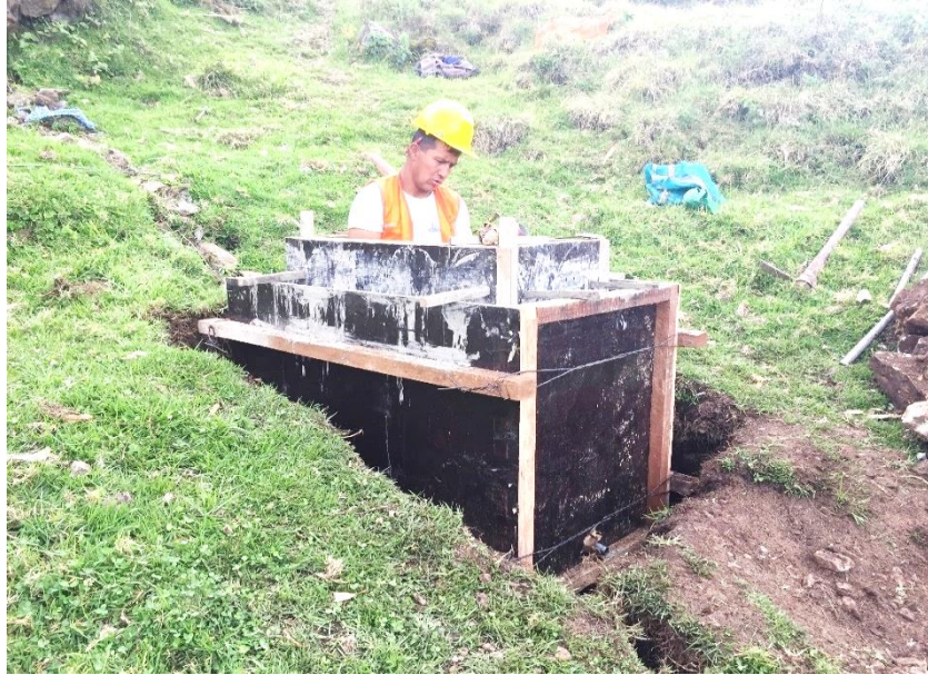
Figura 94: Vista fotográfica en los trabajos de encofrados de estructura CRP tipo
