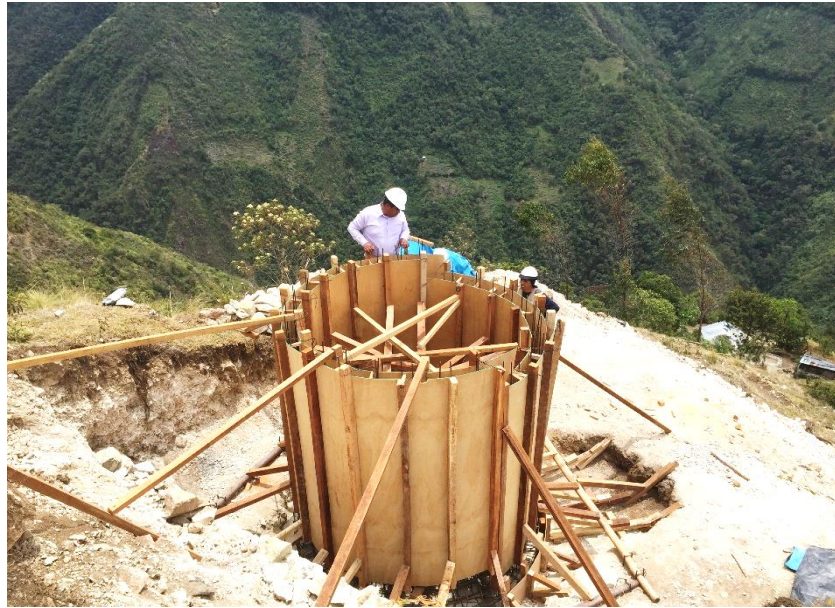
Figura 75: Vista fotográfica de verificación de encofrados en reservorios
