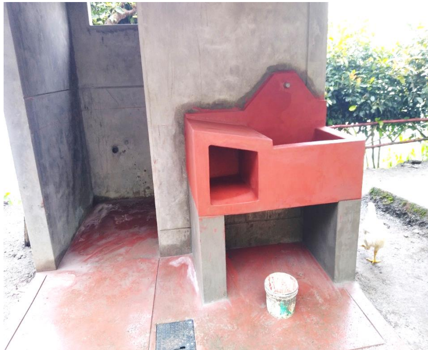
Figura 101: Vista fotográfica de lavadero domiciliario ejecutado
