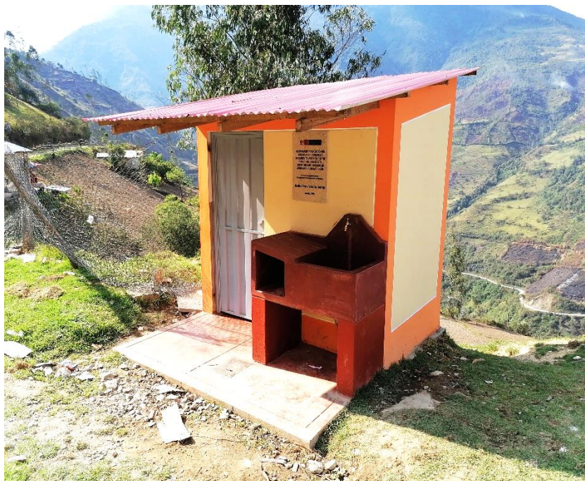
Figura 124: Vista fotográfica en donde se aprecia el módulo de UBS en funcionamiento
