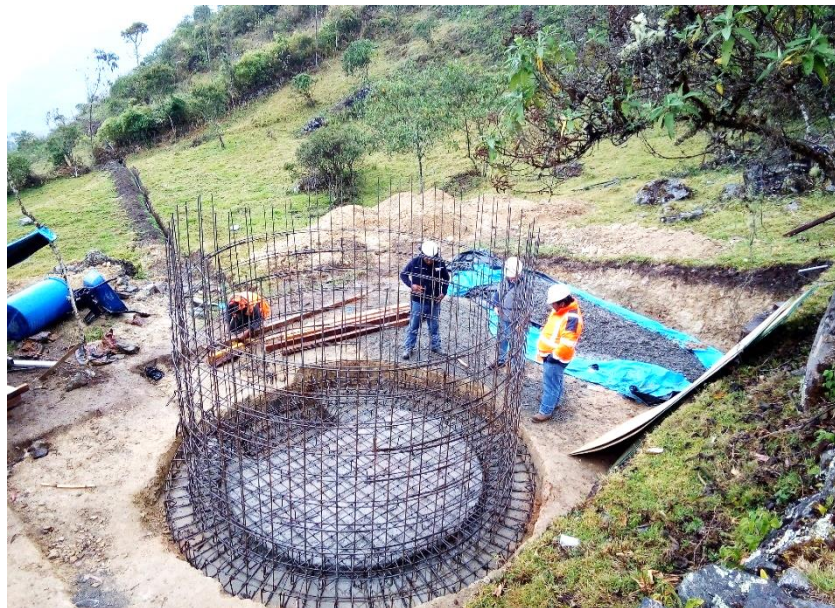
Figura 74: vista fotográfica de verificación de colocado de aceros en reservorios
