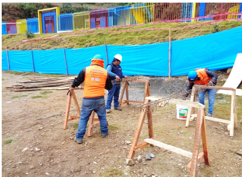
Figura 108: vista fotográfica en proceso de verificación de habilitación de aceros
