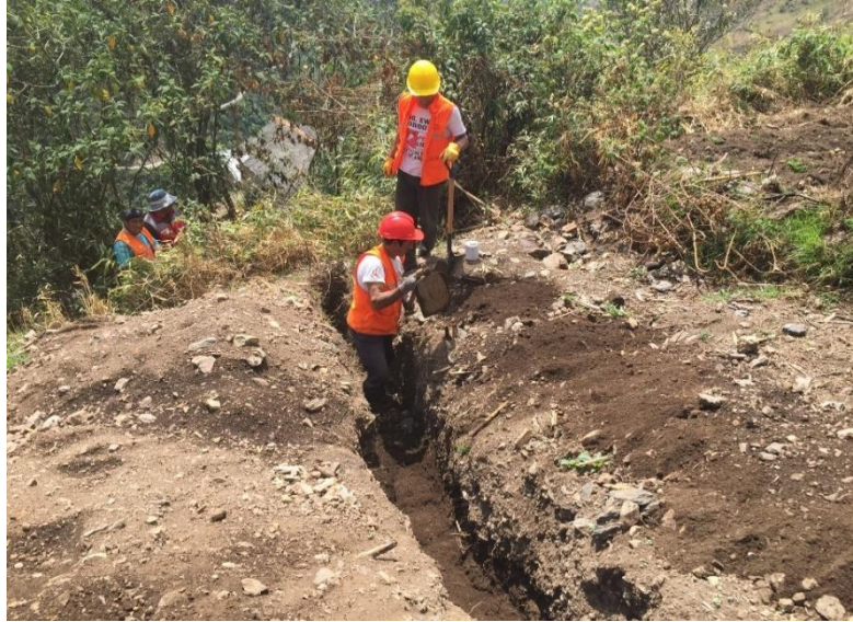
Figura 60: Vista Fotográfica en donde se aprecia el colocado de cama de apoyo para tubería
