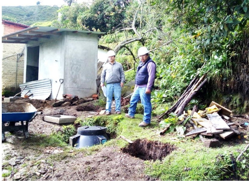
Figura 129: Vista fotográfica en la verificación de colocado de Biodigestor
