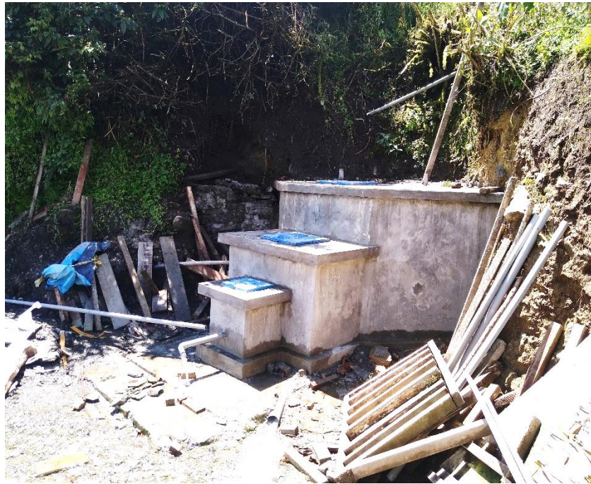
Figura 52: Vista fotográfica en donde se aprecia los acabados y tapa metálica en estructura de captación.
