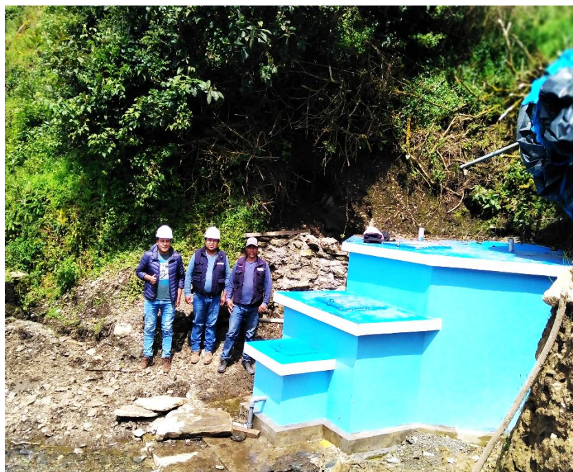
Figura 54: Vista Fotográfica de la estructura de captación pintada
