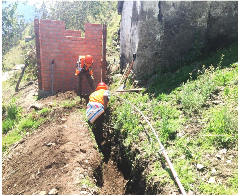
Figura 98: Vista fotográfica de instalación de conexiones domiciliarias
