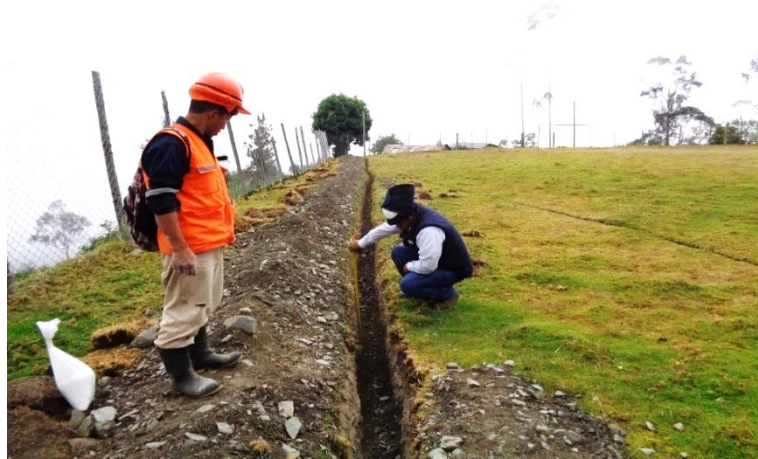
Figura 87: Vista Fotográfica en donde se aprecia la excavación de terreno semirocoso
