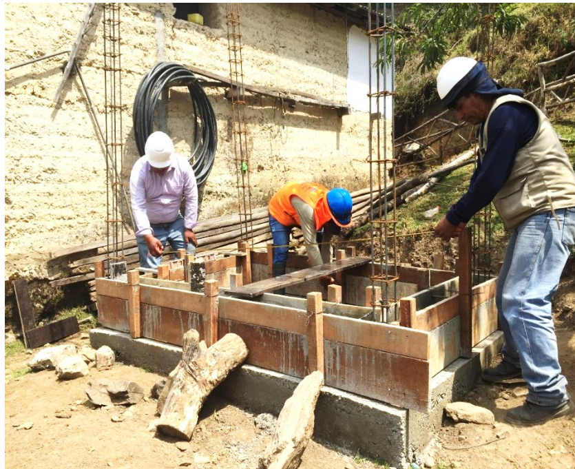
Figura 110: vista fotográfica de verificación de encofrados de sobrecimientos en UBS
