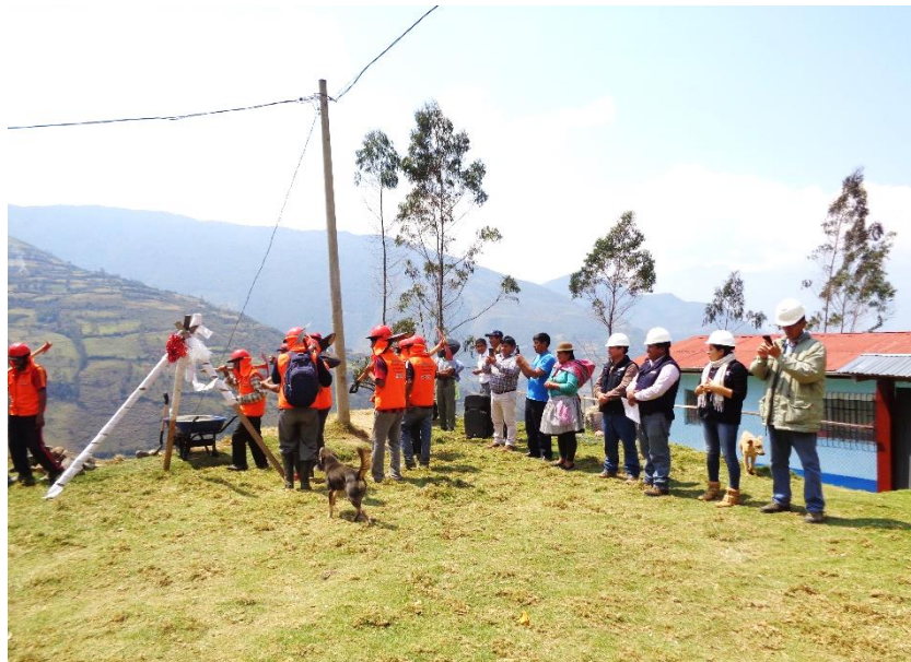
Figura 44: Acto Protocolar de Inicio de Ejecución de Obra
