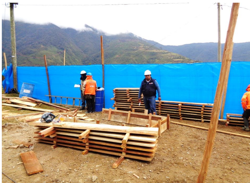
Figura 107: Vista fotográfica en proceso de verificación de formas de madera
