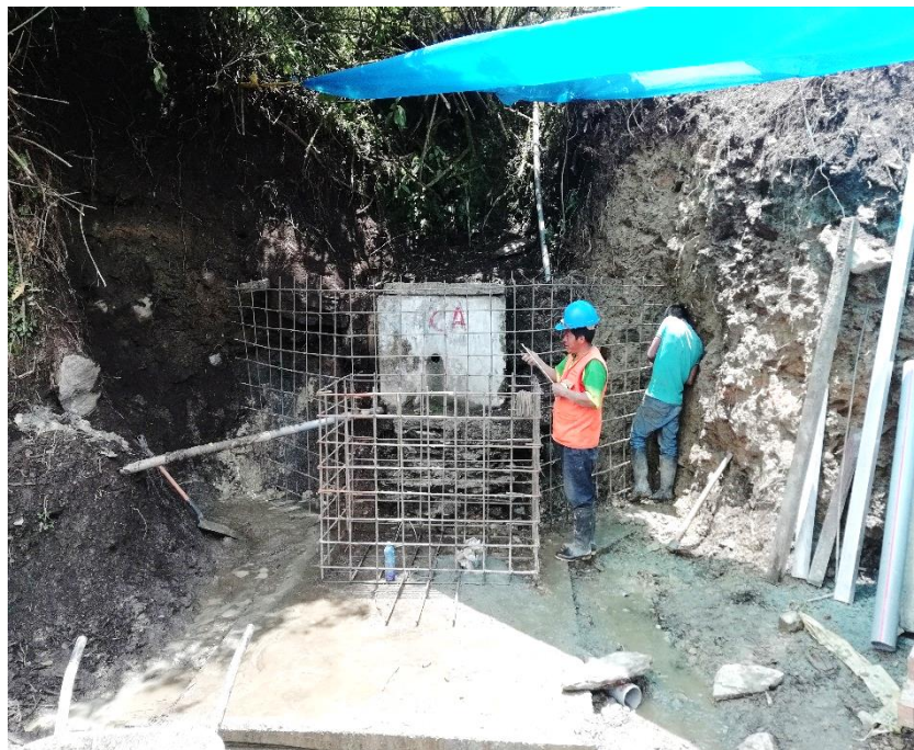
Figura 49: Vista Fotográfica de Habilidad de Acero Corrugado en Captación
