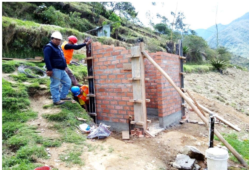
Figura 113: Vista fotográfica de verificación de encofrados de columnas de UBS
