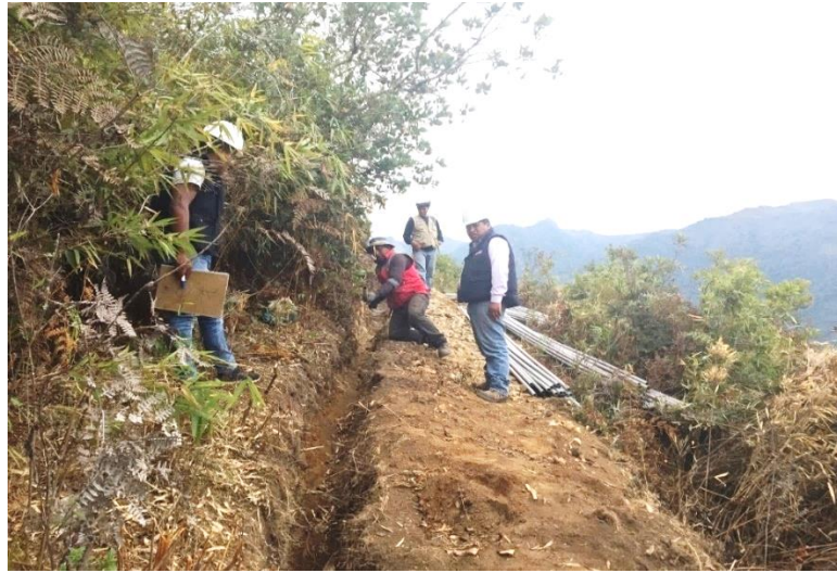
Figura 89: Vista Fotográfica en donde se aprecia la instalación de tuberías de PVC
