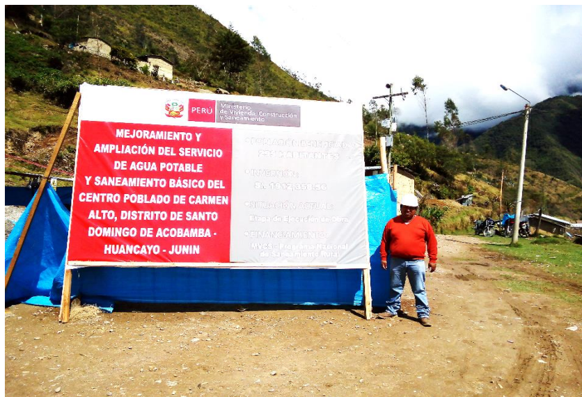
Figura 46: Vista fotográfica de instalación de cartel de obra
