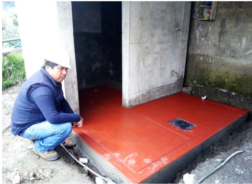
Figura 121: Vista fotográfica de verificación de acabados de veredas en UBS
