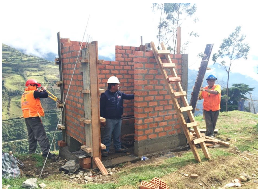
Figura 114: Vista fotográfica de verificación de desencofrados en columnas de UBS
