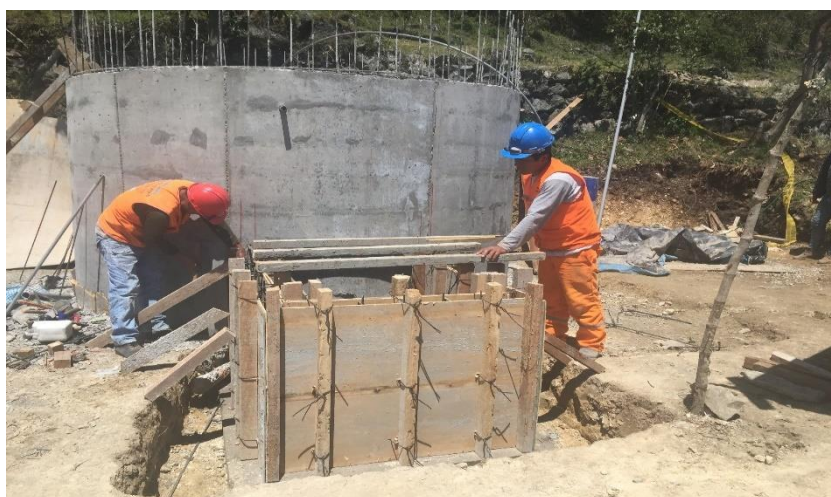
Figura 79: Vista fotográfica en proceso de vaciado de caseta de válvulas
