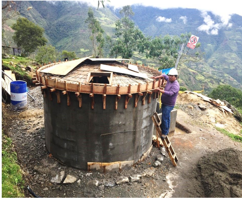
Figura 80: Vista fotográfica en verificación de encofrados de cúpula de reservorios
