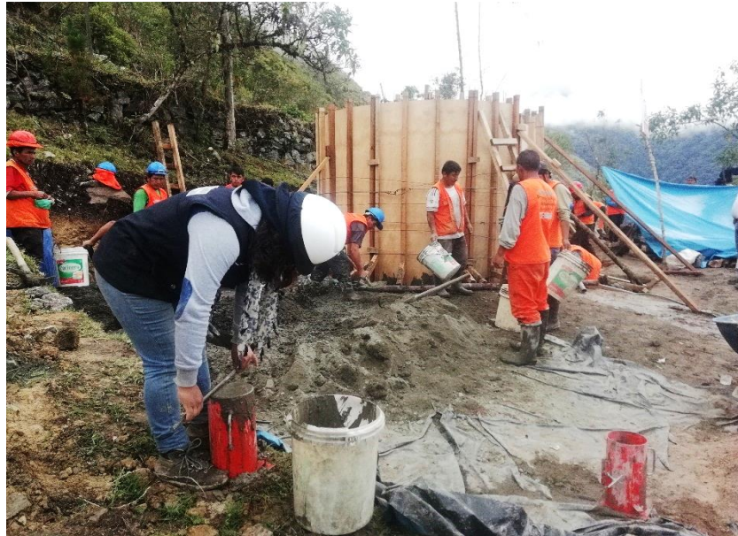
Figura 76: Vista fotográfica en proceso de toma de muestras de concreto
