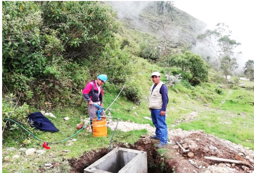
Figura 91: Vista fotográfica en proceso de ejecución de prueba hidráulica en Red de Distribución
