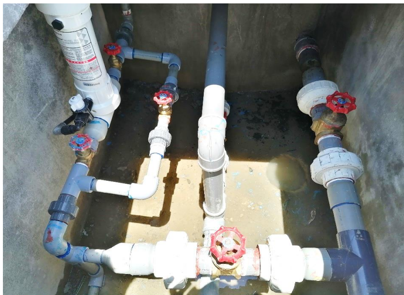
Figura 81: Vista fotográfica de la instalación del equipamiento hidráulico y sistema de cloración en caseta de válvulas de reservorio
