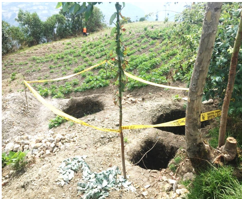
Figura 155: Vista fotográfica en donde se aprecia las señalizaciones preventivas
