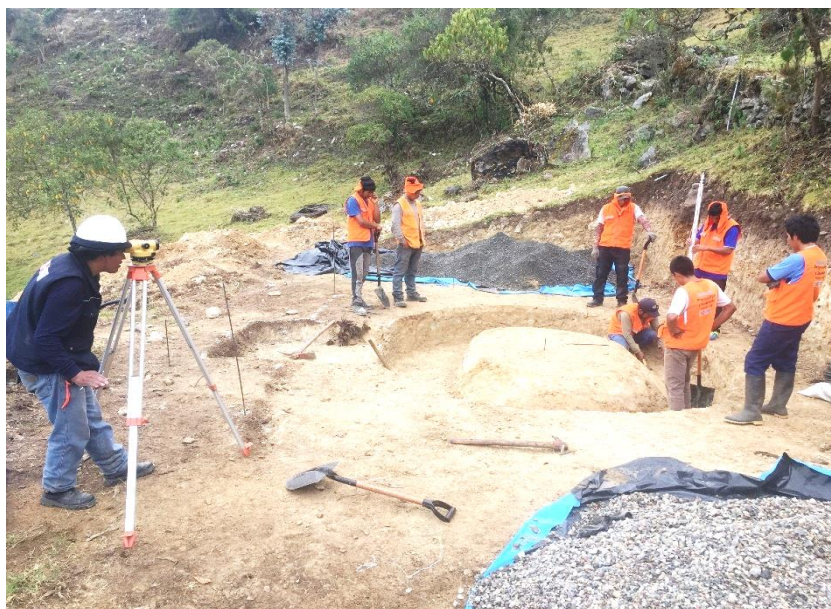
Figura 72: vista fotográfica en proceso de verificación de nivelación en reservorios
