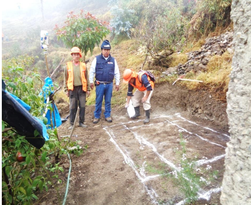
Figura 103: vista fotográfica en el proceso de trazo y replanteo de UBS
