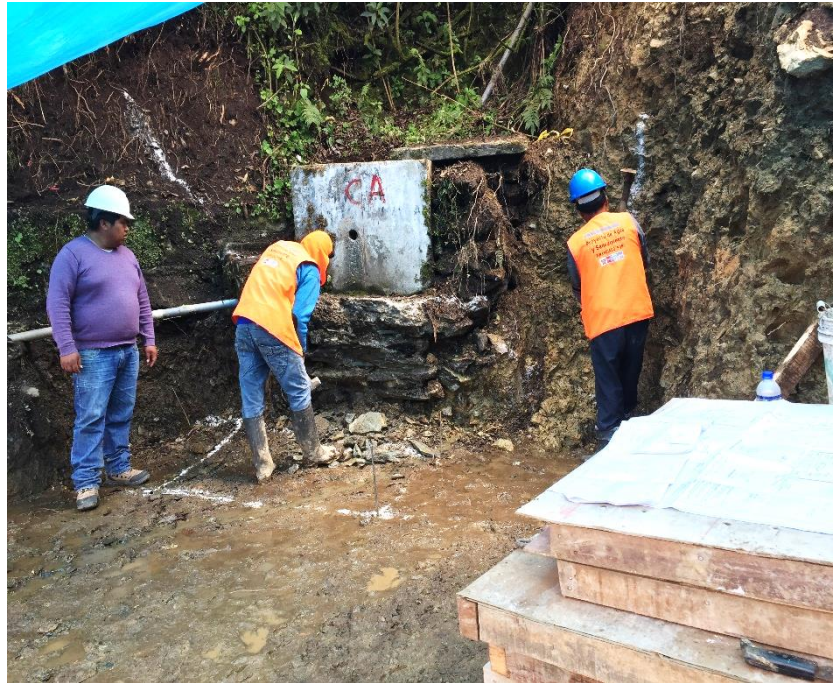
Figura 48: Vista fotográfica de ejecución de las partidas preliminares en captación
