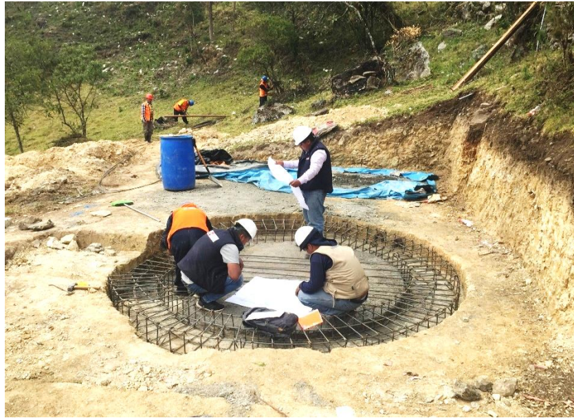
Figura 73: Vista fotográfica en proceso de verificación de aceros en reservorios
