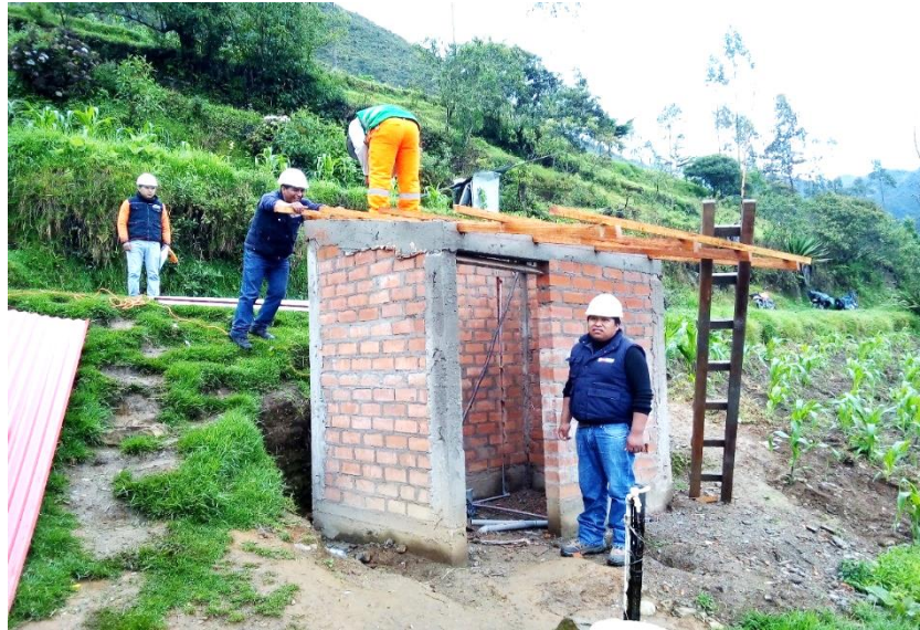
Figura 117: Vista fotográfica en el proceso de armado de estructura de techo de UBS
