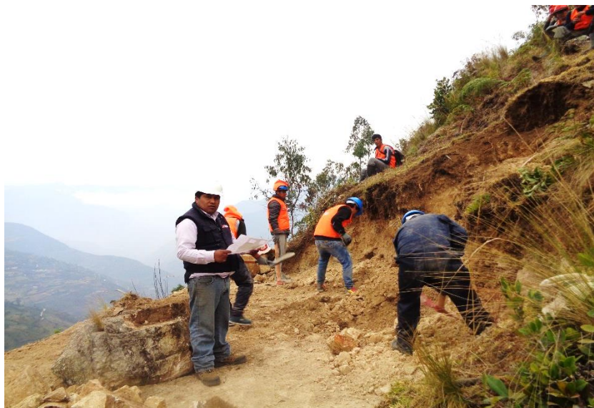
Figura 71: Vista fotográfica en ejecución de trabajos de excavaciones en reservorios
