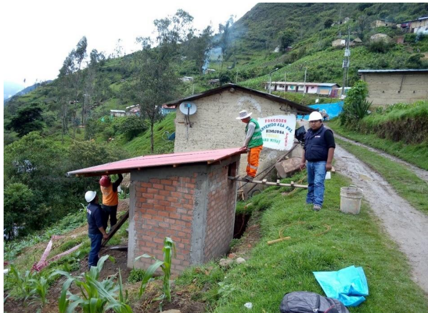
Figura 118: Vista fotográfica en el proceso de colocado de cobertura en UBS
