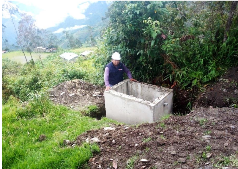
Figura 67: Verificación de estructura de concreto CRP tipo VI
