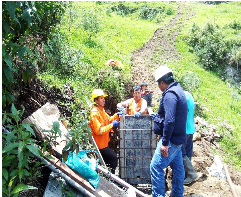
Figura 66: Trabajos de encofrado en CRP tipo VI
