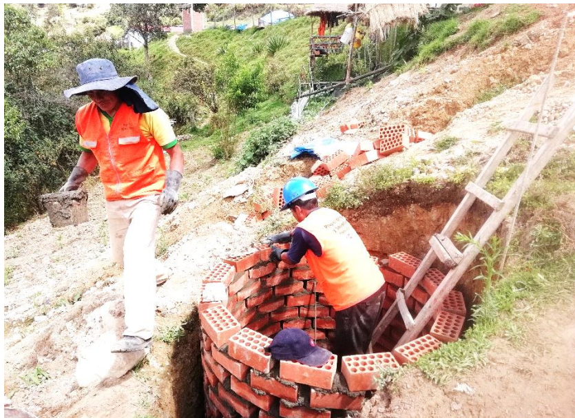
Figura 130: Vista fotográfica del proceso de construcción de pozo de percolación
