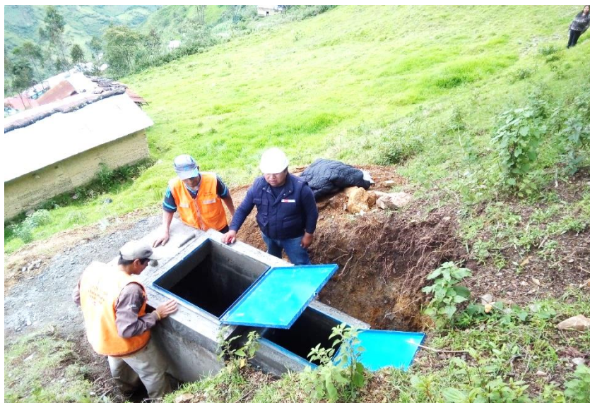
Figura 95: Vista fotografía de verificación de tapas metálicas en CRP tipo VII
