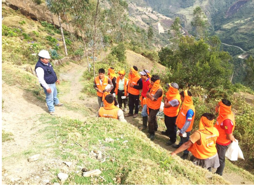
Figura 153: Vista fotográfica en proceso de charlas de seguridad en obra
