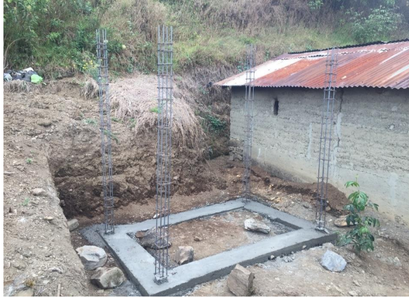
Figura 109: Vista fotográfica de colocado de aceros en UBS
