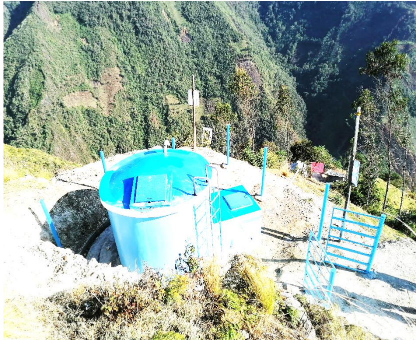
Figura 83: Vista fotográfica de reservorio de 5 m 3 de capacidad ejecutado
