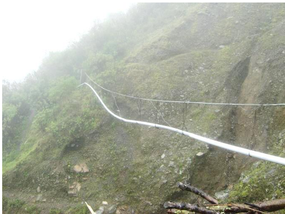
Figura 10: Pase aéreo existente de 20 m.
