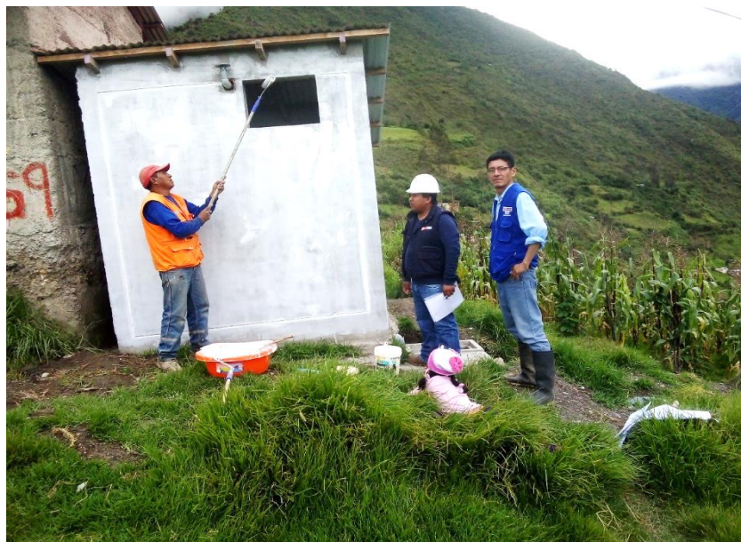
Figura 122: Vista fotográfica en proceso de pintado de UBS
