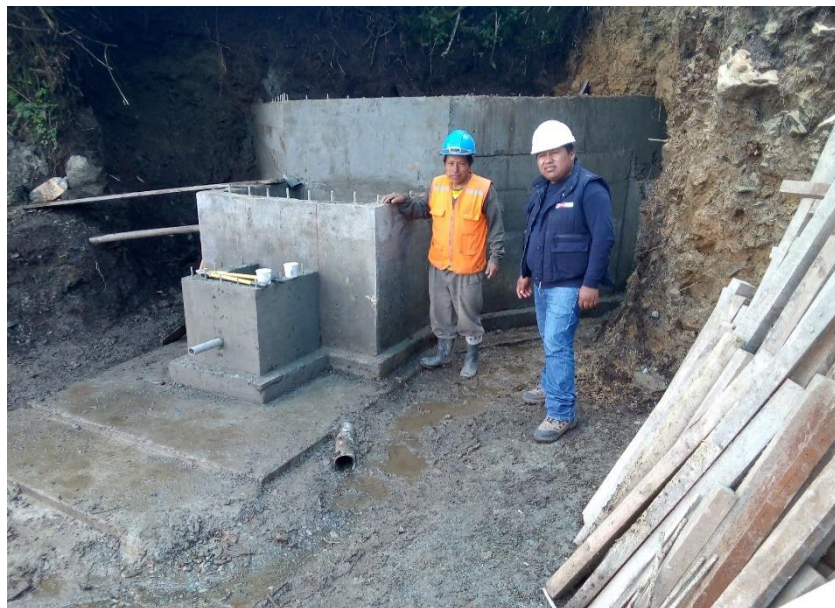
Figura 51: Vista Fotográfica de Estructura de Concreto Armado en Captación
