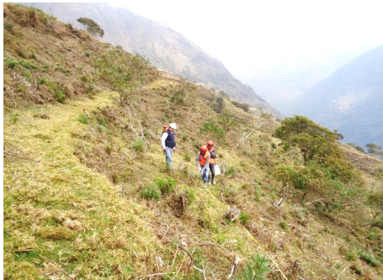
Figura 57: Vista Fotográfica en el proceso de Trazo y Replanteo
