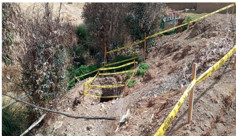
Figura 15. Apertura de la disposición final de residuos de construcción.
