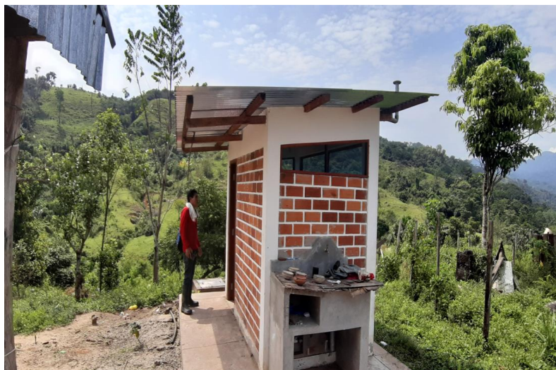
Figura 20. Unidad básica de saneamiento de arrastre hidráulico – propuesta como opción tecnológica para el centro poblado Betania – San Martín
