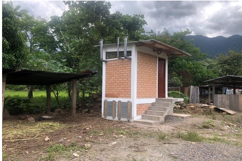
Figura 23. Cámaras de excretas, sistema de tratamiento de UBS de compostaje continuo como opción tecnológica para el centro poblado Betania – San Martín
