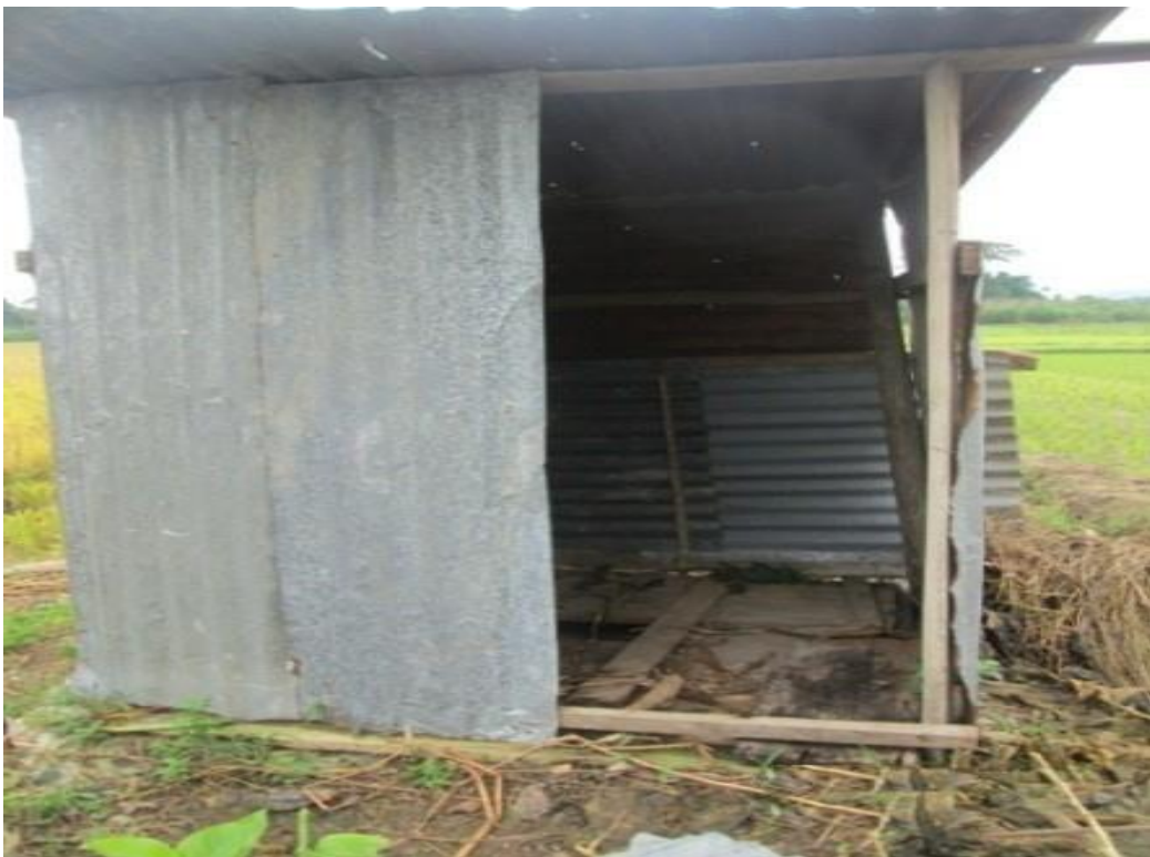
Figura 45. Caseta de saneamiento actual
