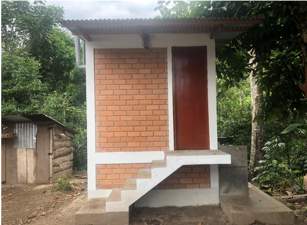
Figura 52. Unidad básica de saneamiento de compostaje continuo
