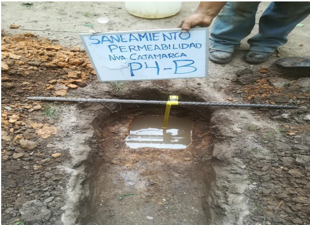
Figura 59. Ensayo de permeabilidad
