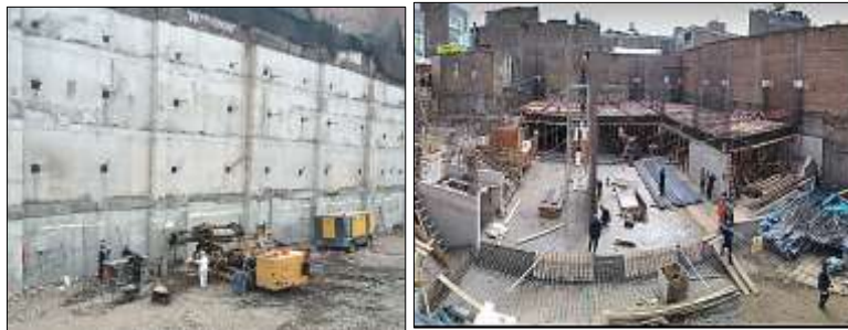
Figura 37: Construcción de los muros anclados en fase inicial del proyecto (izquierda), construcción del techo fase de culminación del sótano del proyecto (derecha)
