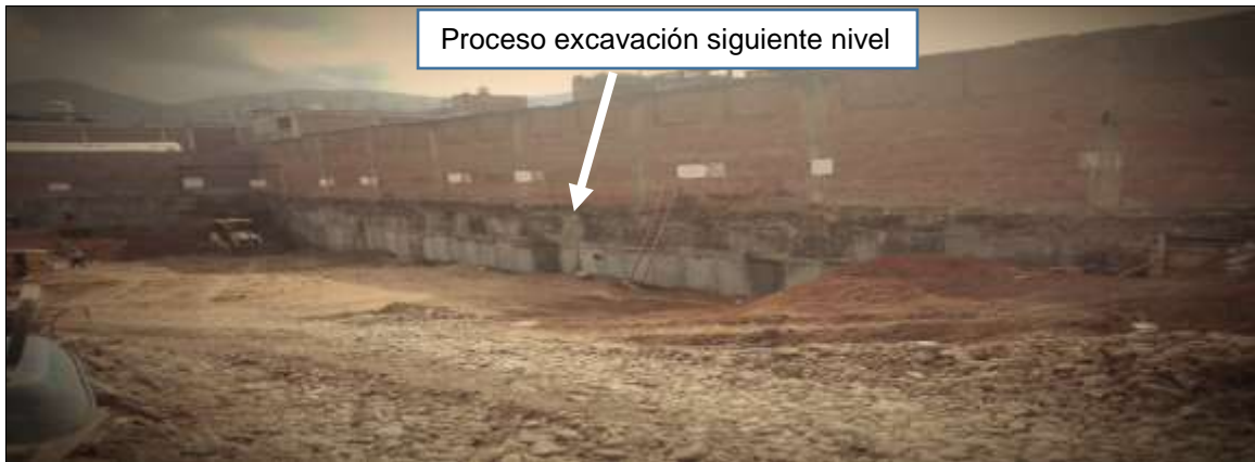
Figura 151: Proceso de excavación y ejecución de calzaduras proyecto "San Pedro"
