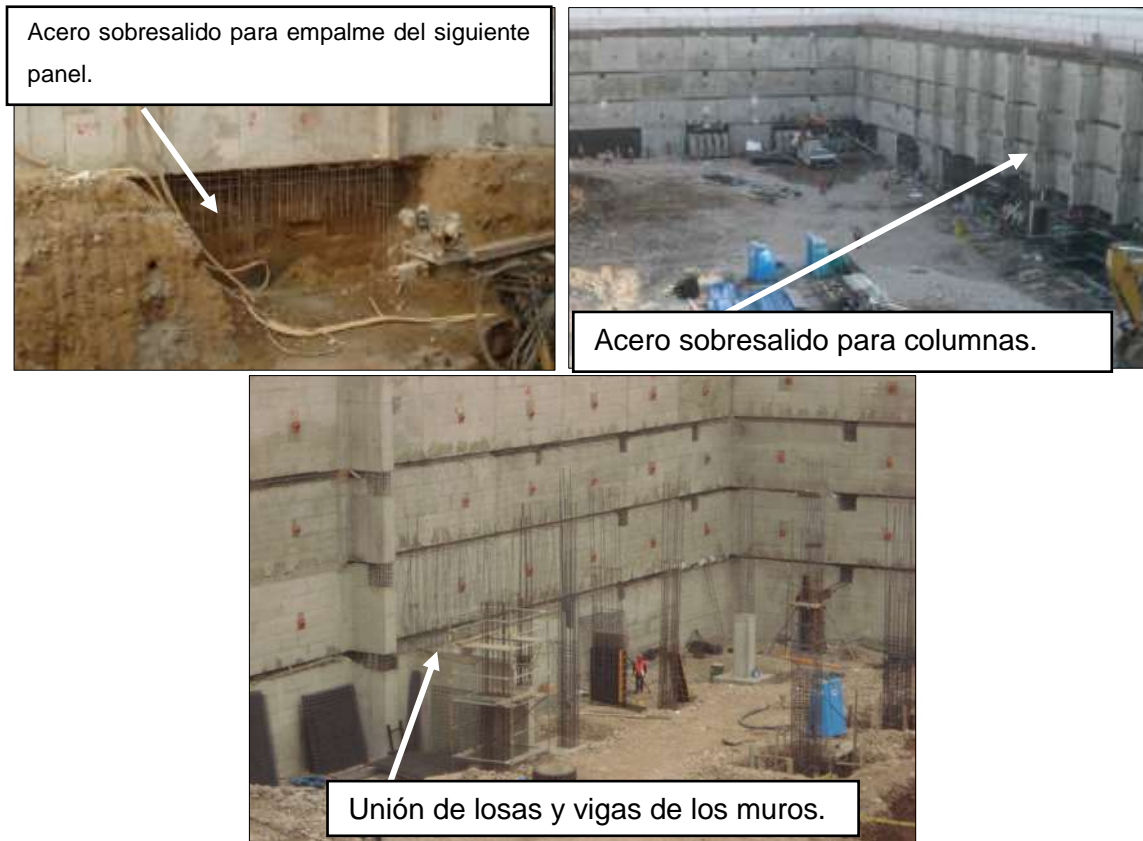
Figura 182: Proceso constructivo de empalme y arriostres laterales.
