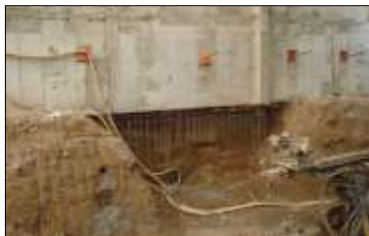
Figura 19: Construcción de un muro pantalla
