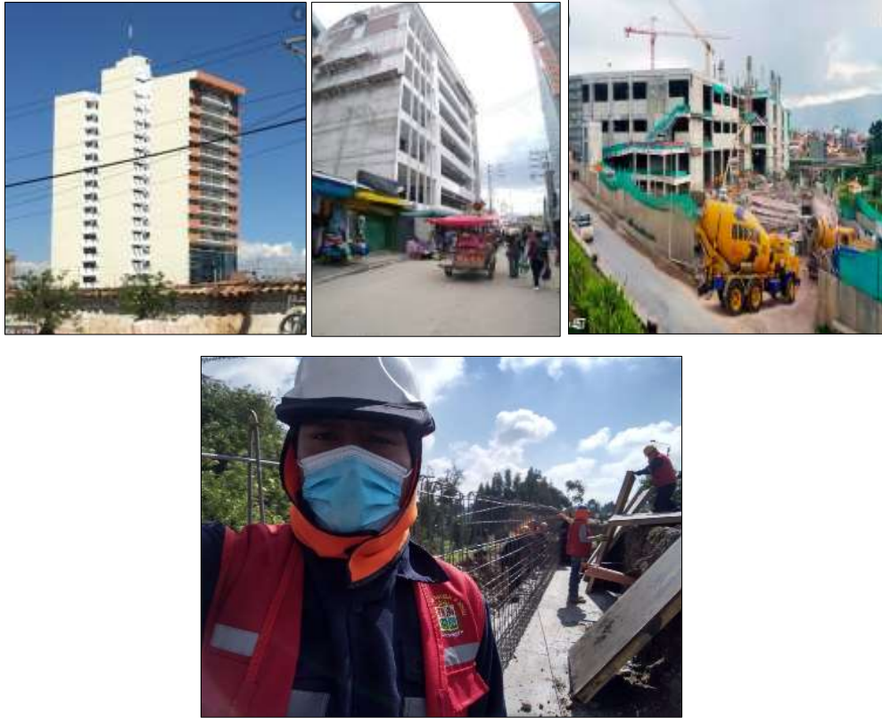
Figura 4: (Izquierda) Vista de la edificación "Las Dos Torres" de 18 pisos y 2 sótanos; (Centro) Vista de la edificación "San Pedro" de 7 pisos y 2 sótano (Derecha) Vista de los inicios de la obra de Open Plaza; (Abajo) Construcción en tiempos de COVID-19.
