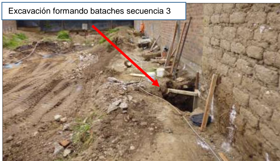
Figura 72: Proceso de excavación hasta el fondo de cimentación hacia el Jr. Tacna.
