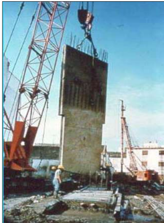
Figura 145: Transporte de muro pantalla completamente prefabricado
