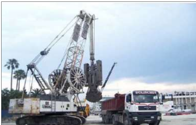
Figura 112: Excavación de zanja con cuchara bivalva hidráulica
