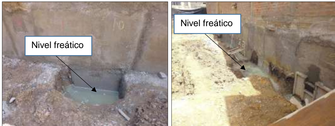
Figura 103: Proceso constructivo del segundo tramo y presencia del agua subterránea.
