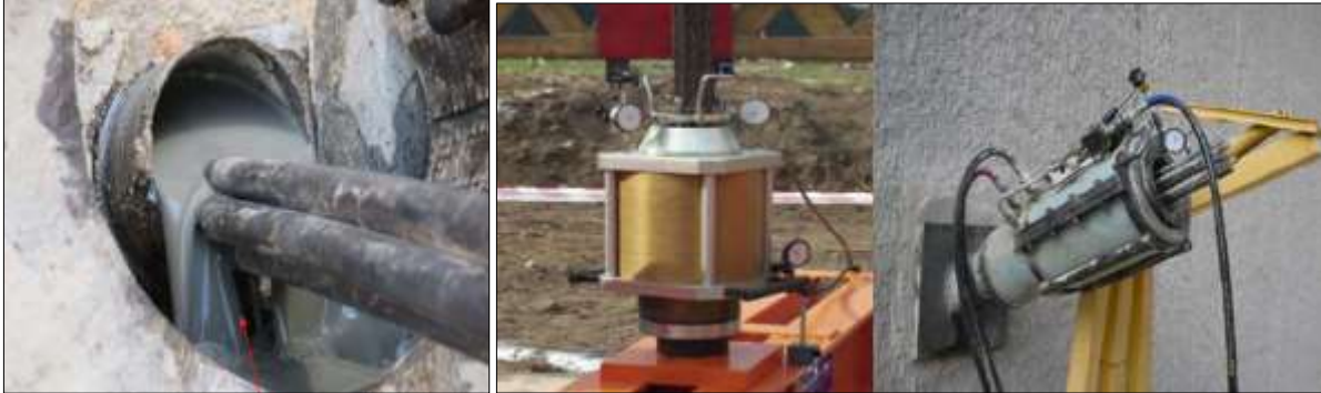
Figura 119: Uso del gato hidráulico para tensar los cables del anclaje.
