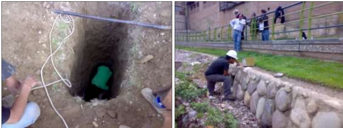
Figura 180: Calicata 01 y Ubicación de equipos para el ensayo de refracción sísmica.
