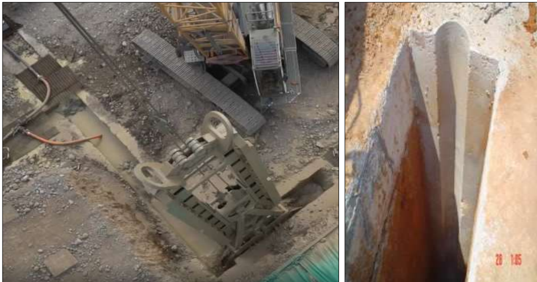
Figura 114: Lodo Bentónico usado en la excavación y colocación de juntas en las pantallas
