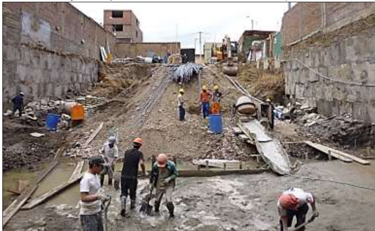
Figura 18: Muro de sótano (Sistema de Calzaduras)
