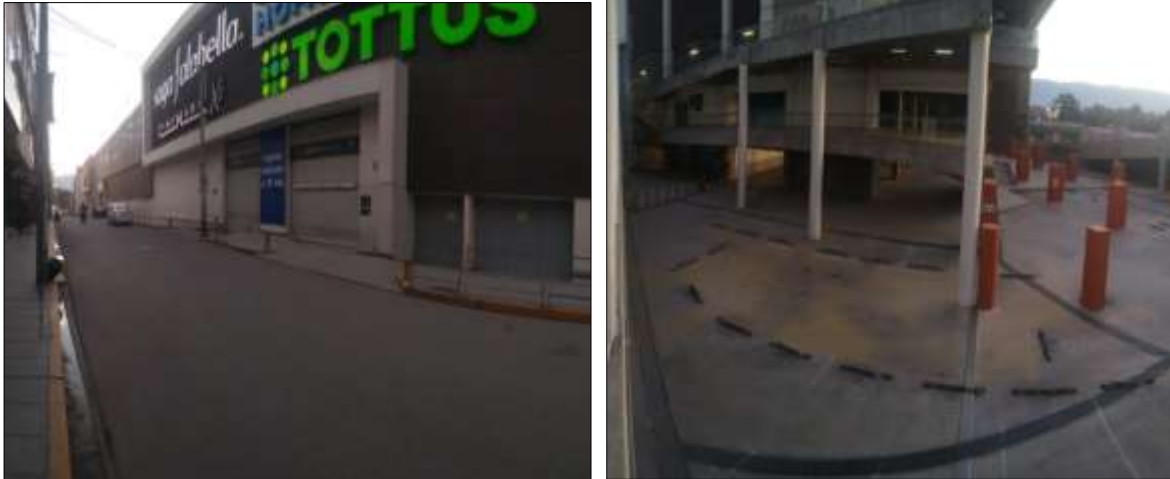
Figura 179: Calzada vehicular aledaño a la C.C. Open Plaza y vista de sótanos
