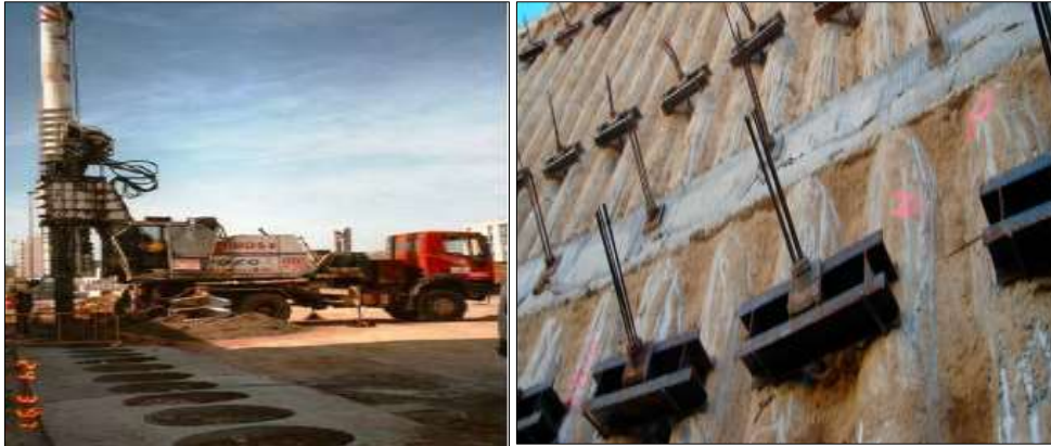
Figura 25: (Izquierda) Perforación de pilotes tangentes. (Derecha) Vigas arrioste y anclajes en pilotes tangentes.
