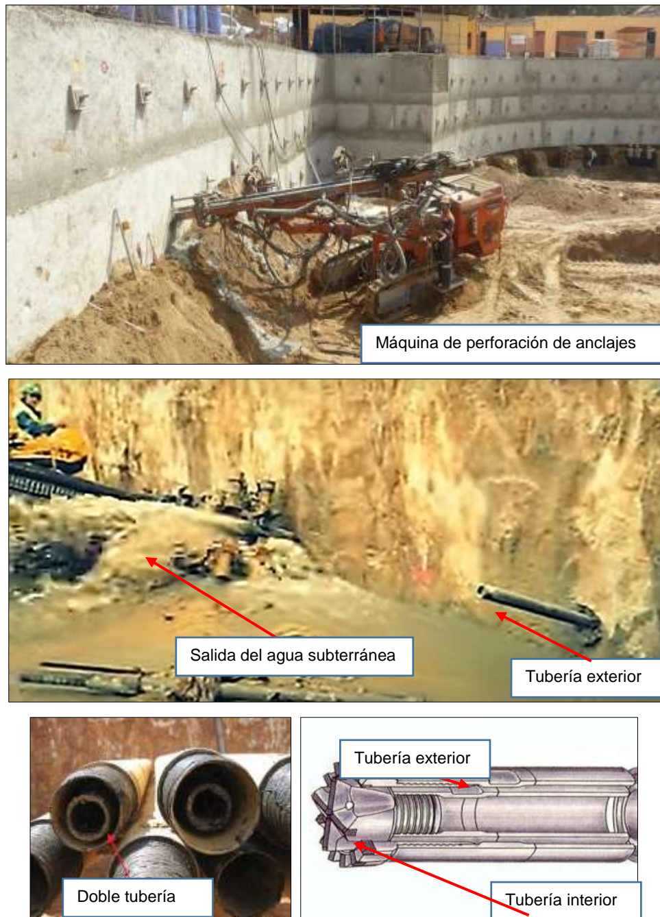
Figura 117: Proceso perforación para anclaje.
