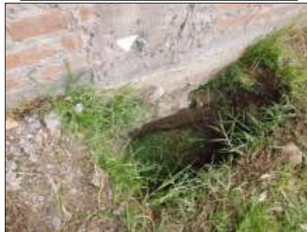
Figura 67: Calicata 01 para EMS.
