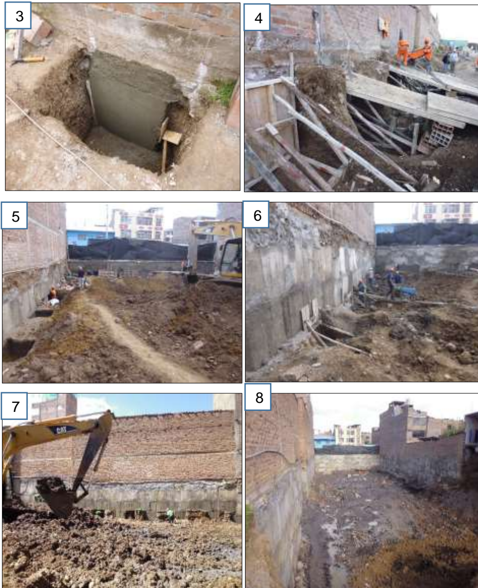
Figura 81: Proceso constructivo correcto de las Calzaduras
