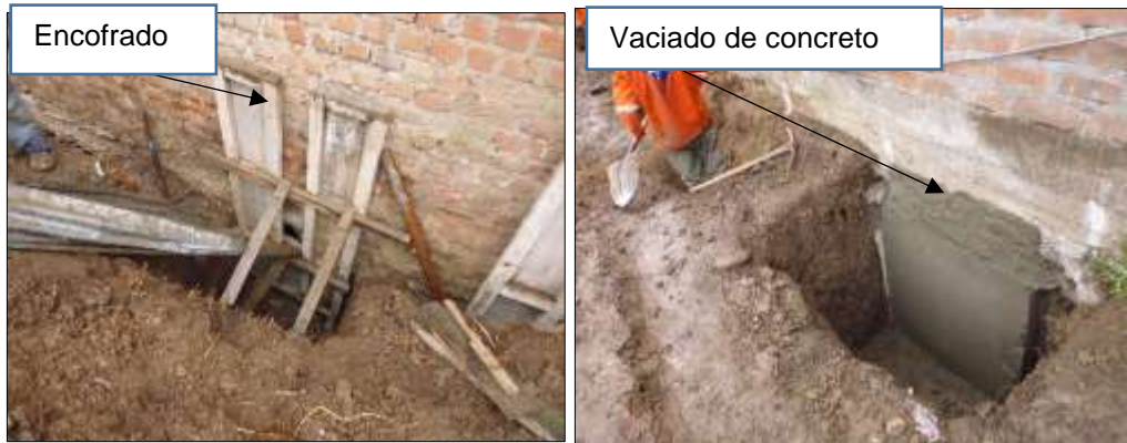
Figura 102: Proceso constructivo para el primer tramo
