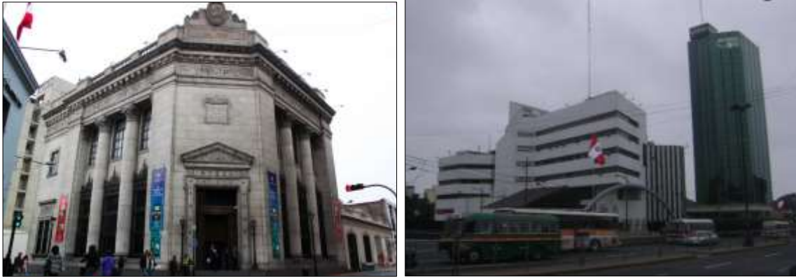
Figura 83: Banco Central de Reserva del Perú y Banco de la Nación con sistema de calzaduras.
