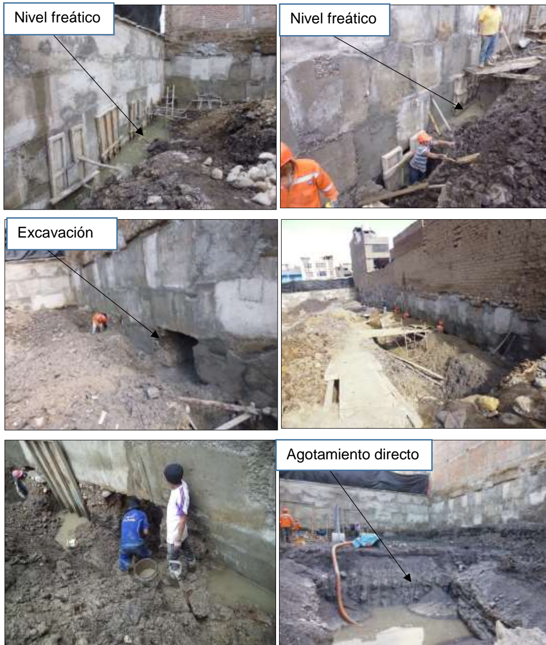
Figura 104: Proceso constructivo del tercer tramo y presencia del agua subterránea.
