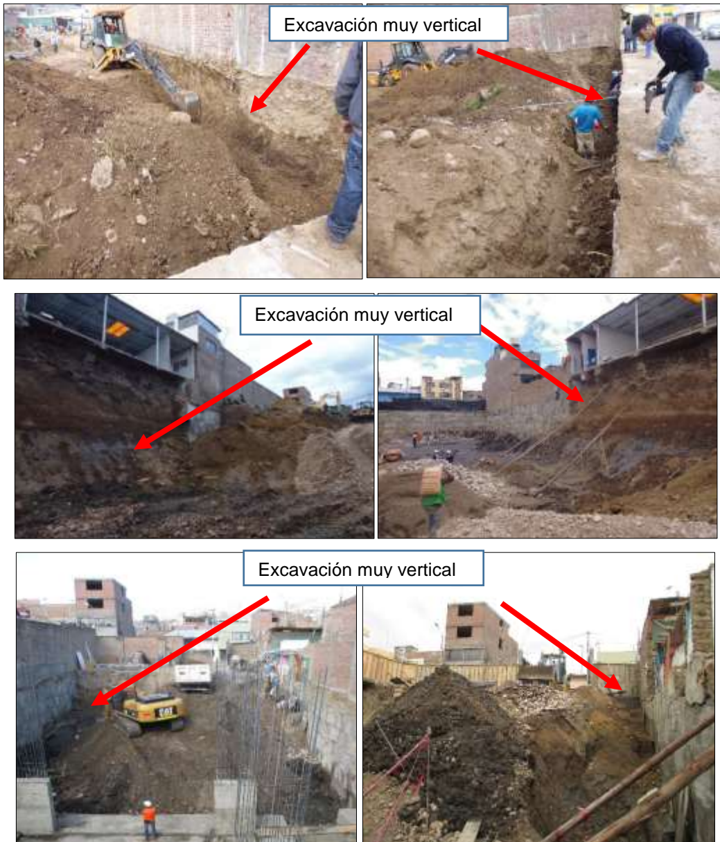
Figura 71: Excavación adoptando la secuencia 3
