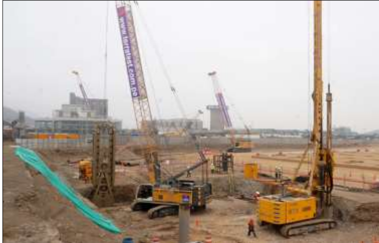
Figura 111: Excavación de zanja con cuchara bivalva de cable.
