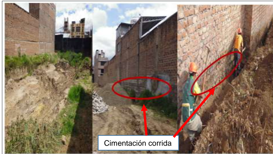
Figura 68: Construcciones aledañas al proyecto con vista de sus respectivas cimentaciones superficiales.
