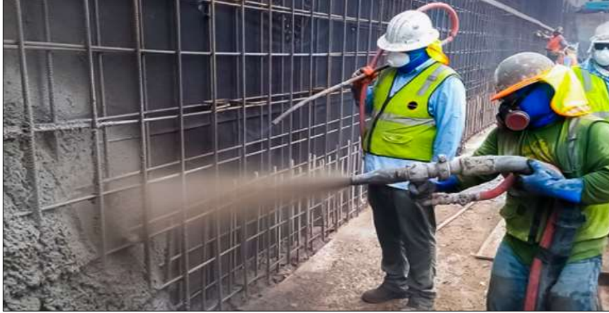
Figura 203: Equipos de lanzamiento de concreto y premezclado. Fuente: Shotcrete Vía Húmeda (Union de Concreteras S.A., 2014)
