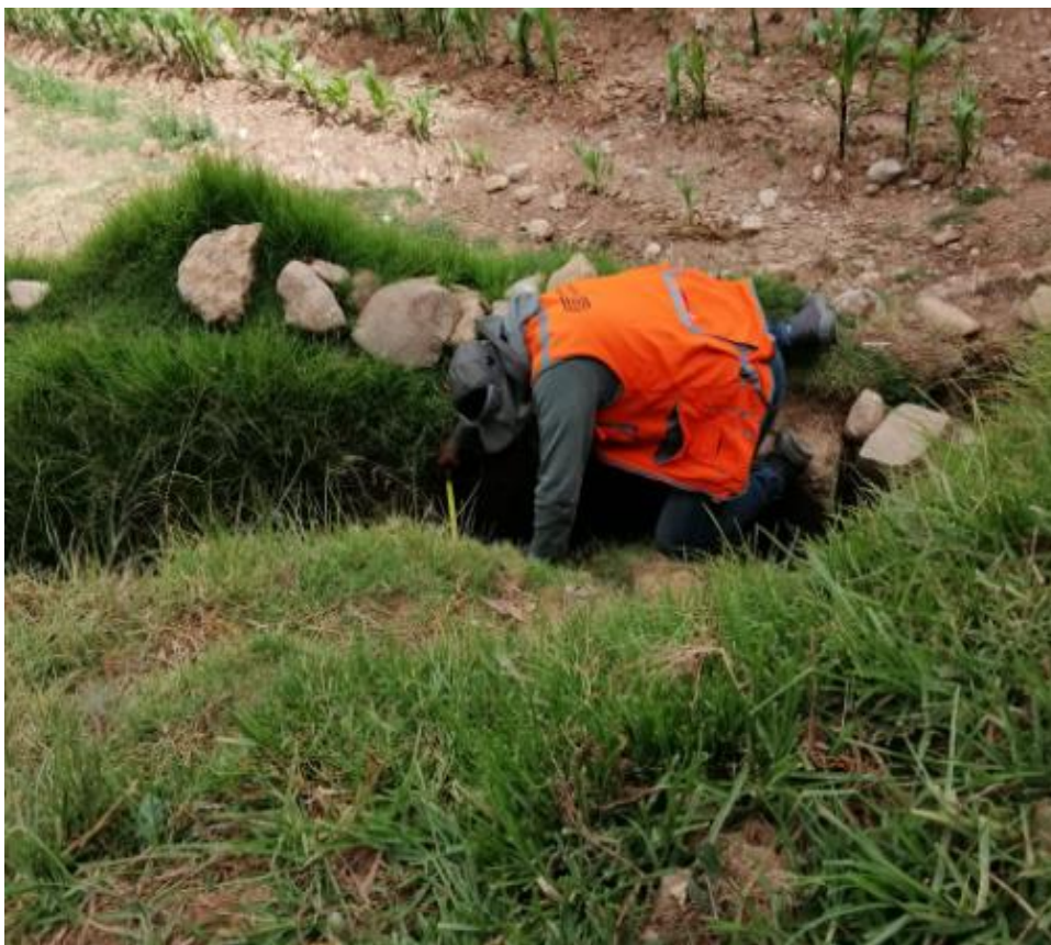
Figura 20. Toma del espejo de agua del segundo canal lateral (sección rectangular)
