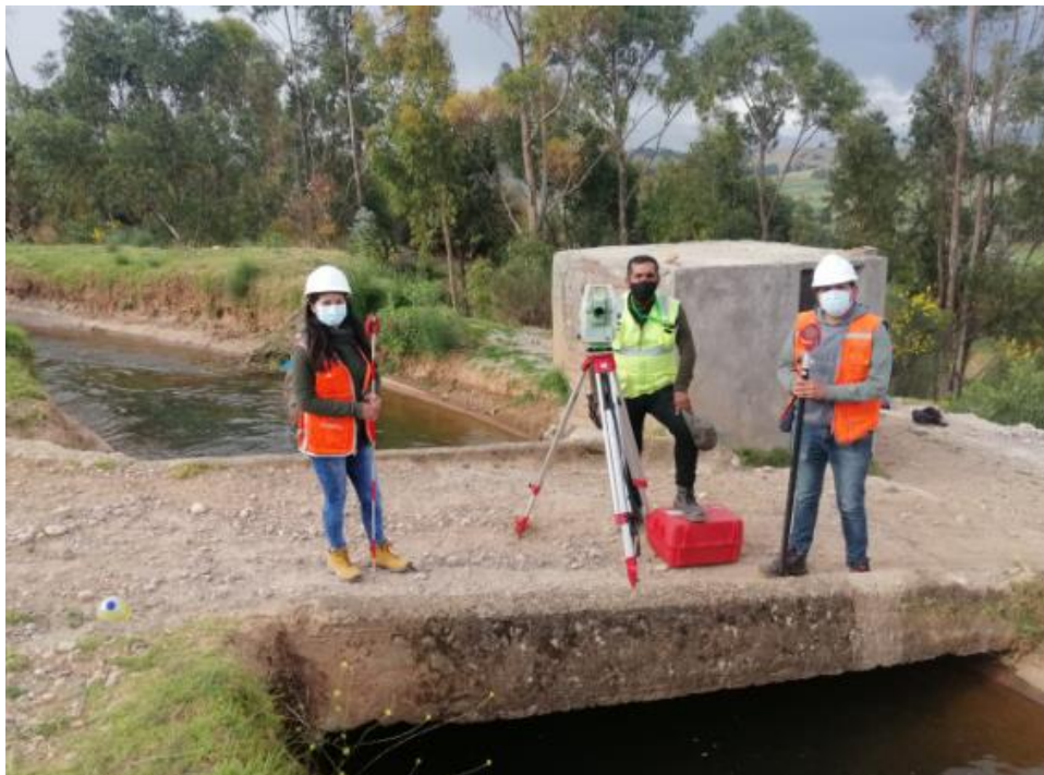
Figura 16. Levantamiento topográfico en la progresiva 2+020 km
