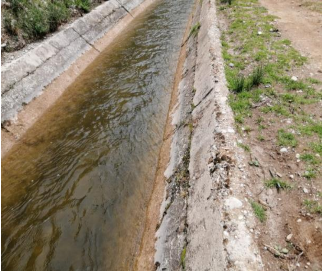
Figura 1. Conducto de riego Huayao
