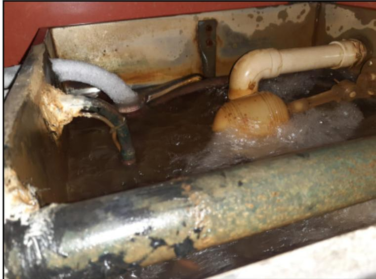
**Ilustración 44.** Tanque de agua- refrigerante con entrada de agua y enfriamiento en funcionamiento
