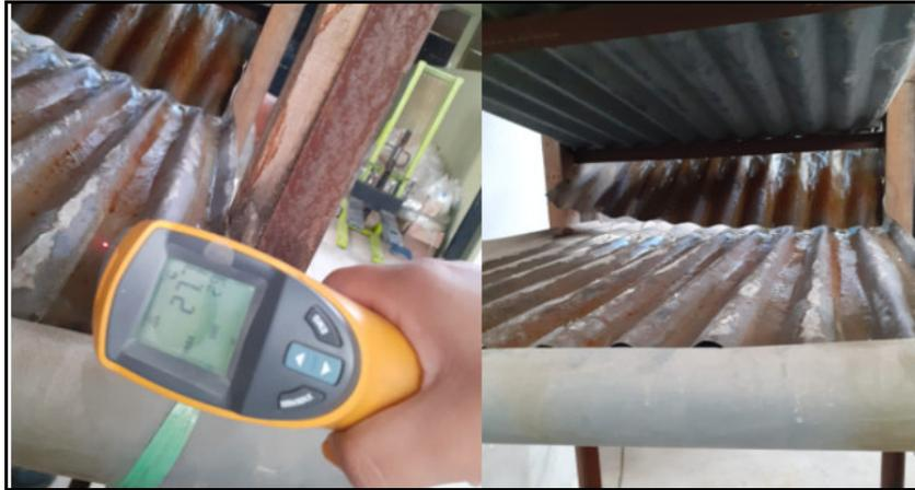
**Ilustración 38.** Medida de temperatura con Fluke 561 en torre de enfriamiento
