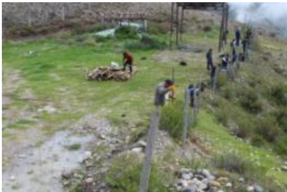
Figura 25: Cerco perimétrico del Botadero
