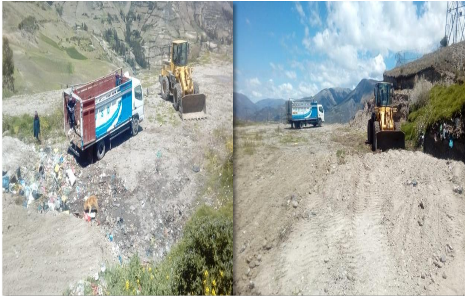
Figura 30. Disposición final botadero Pampacocha
