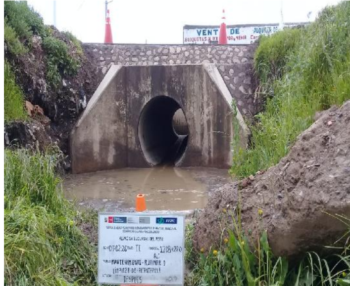
Figura 4. Limpieza de alcantarilla
