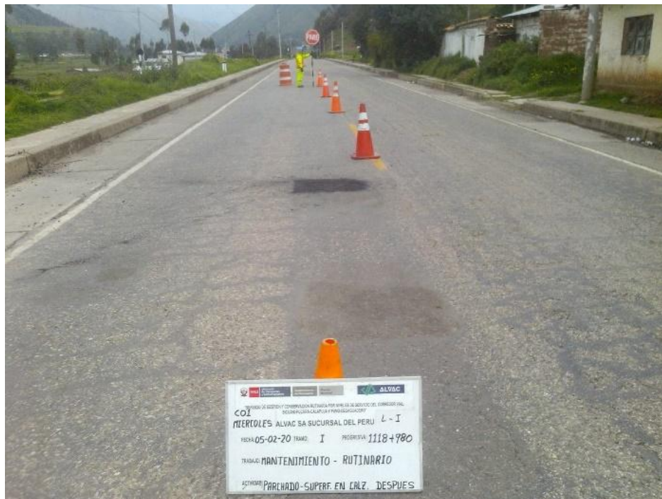
Figura 3. Parchado superficial en calzada
