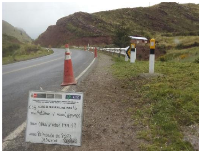
Figura 7. Reposición de poste delineador
