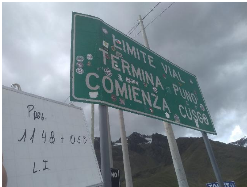
Figura 17. Reposición o Cambio de Panel de Señal Vertical Informativa Encontrada como Defecto Producto de la Evaluación no Programada
