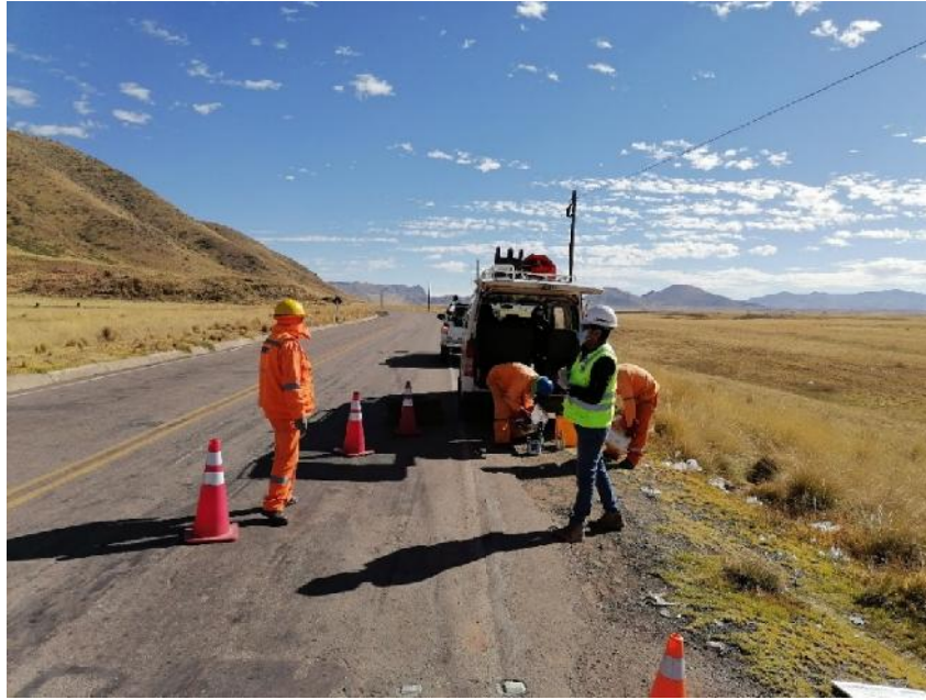
Figura 10. Coordinación con el Capataz de Cuadrilla para la Emisión de la Orden por Defectos No Admitidos
