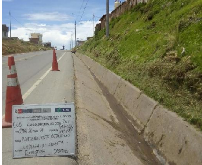
Figura 8. Limpieza de cunetas revestidas
