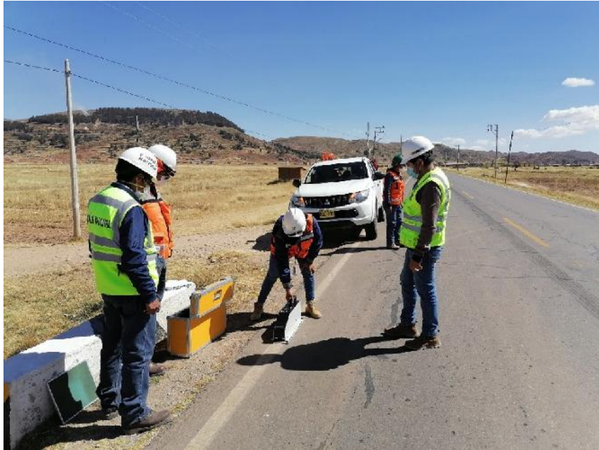
Figura 25. Defecto Detectado (Marcas en el Pavimento) en las Evaluaciones Programadas
