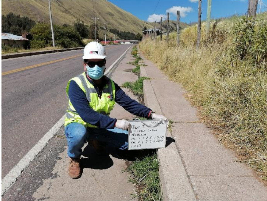
Figura 12. Anotación del Defecto Encontrado en la Vía
