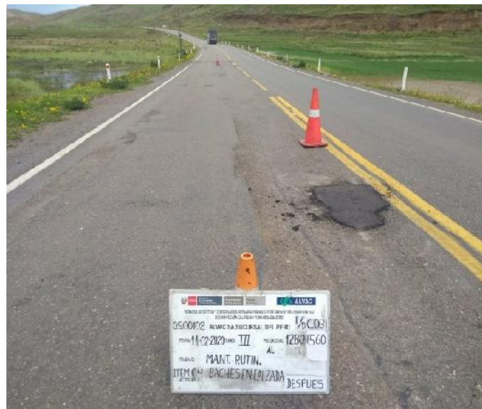
Figura 5. Parchado superficial en calzada
