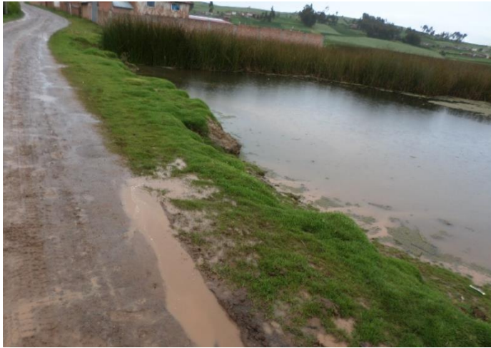
Ingreso de sedimentos por escorrentía directamente de la carretera.
