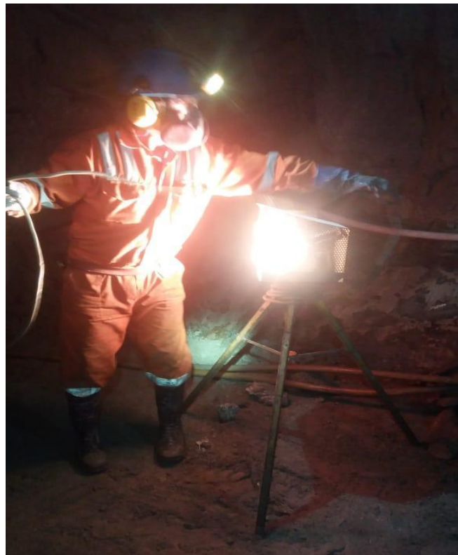
Figura 38. Instalación de iluminación en el área de perforación
