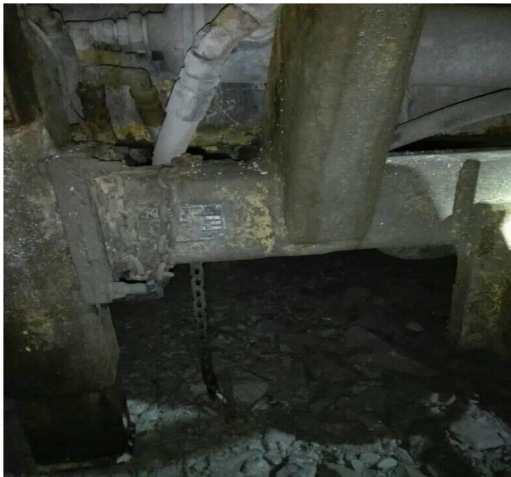
Figura 32. Instalación de línea tierra del equipo PTL
