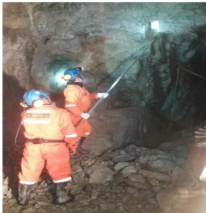
Figura 28. Desatado de rocas en el SN 4 A, XC 405
