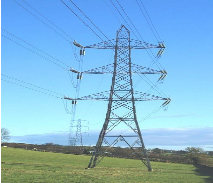
Figura 6. Apoyo de ángulo doble de doble terna Fuente: http://www.tuveras.com/lineas/aereas/lineasaereas
