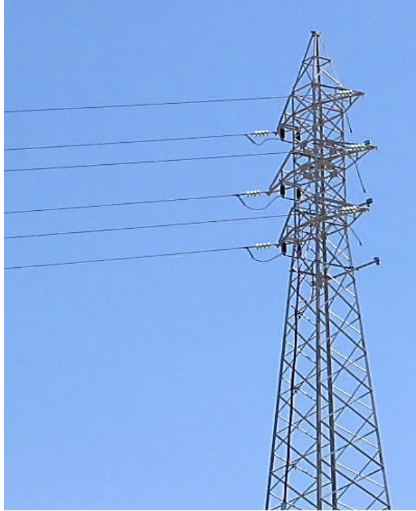
Figura 8. Apoyo simple de doble terna de fin de línea
