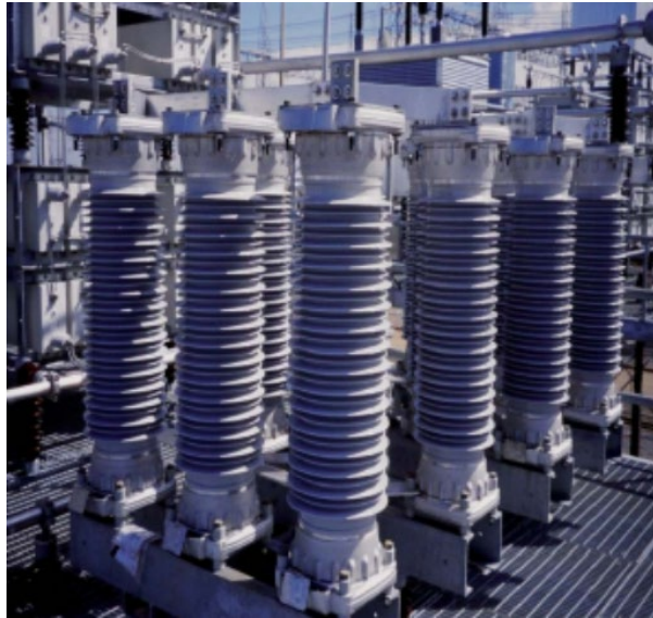
Figura 24. Varistor de óxido metálico Fuente: https://docplayer.es/5921011-3-compensacion-serie-de-reactivos-power-solutions.html
