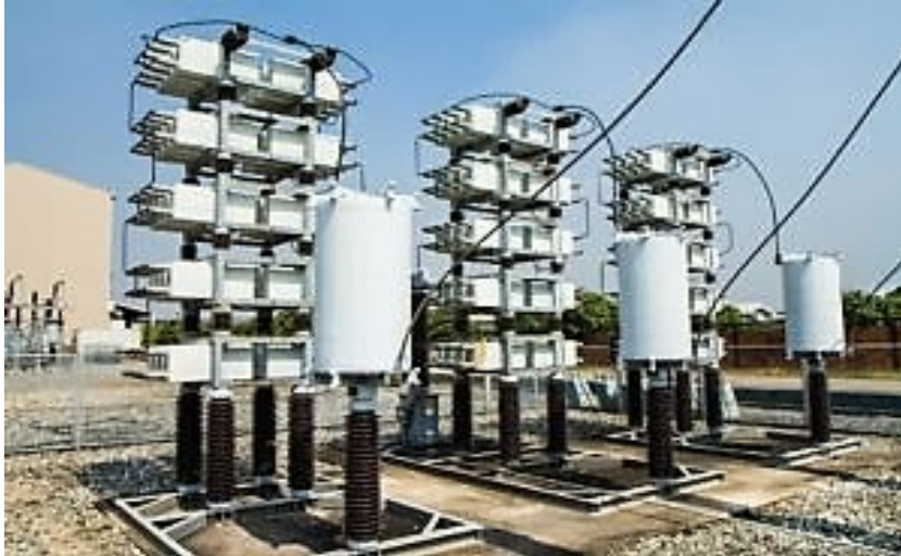
Figura 19. Condensadores en serie en una LT
