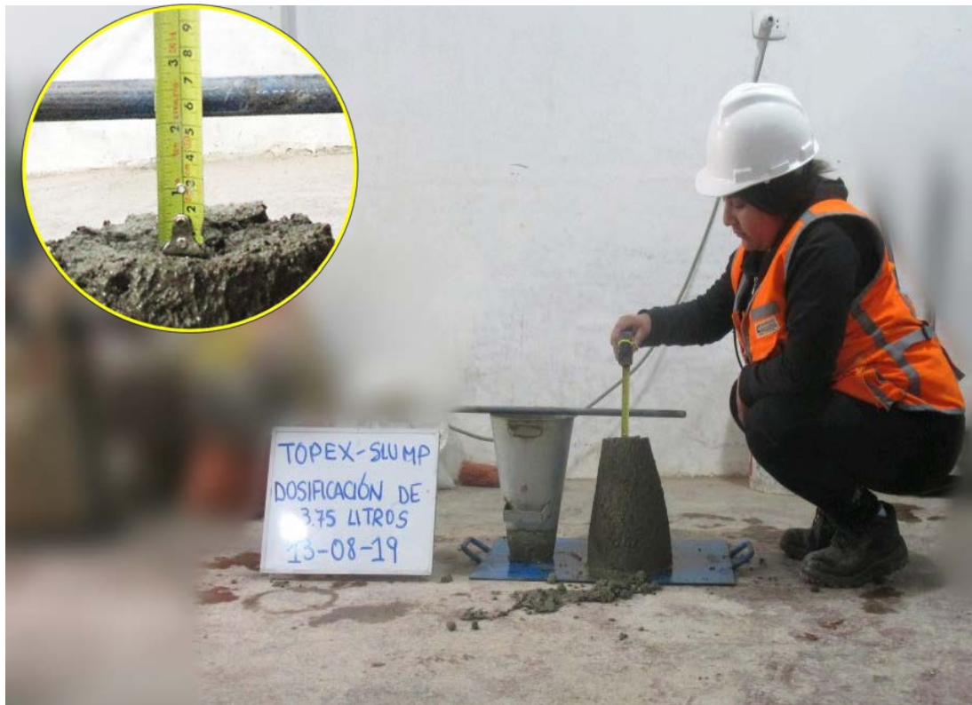
Fotografía 16: Control de asentamiento 2" de slump de dosificación de 3.75 litros de agua del embolsado Topex.
