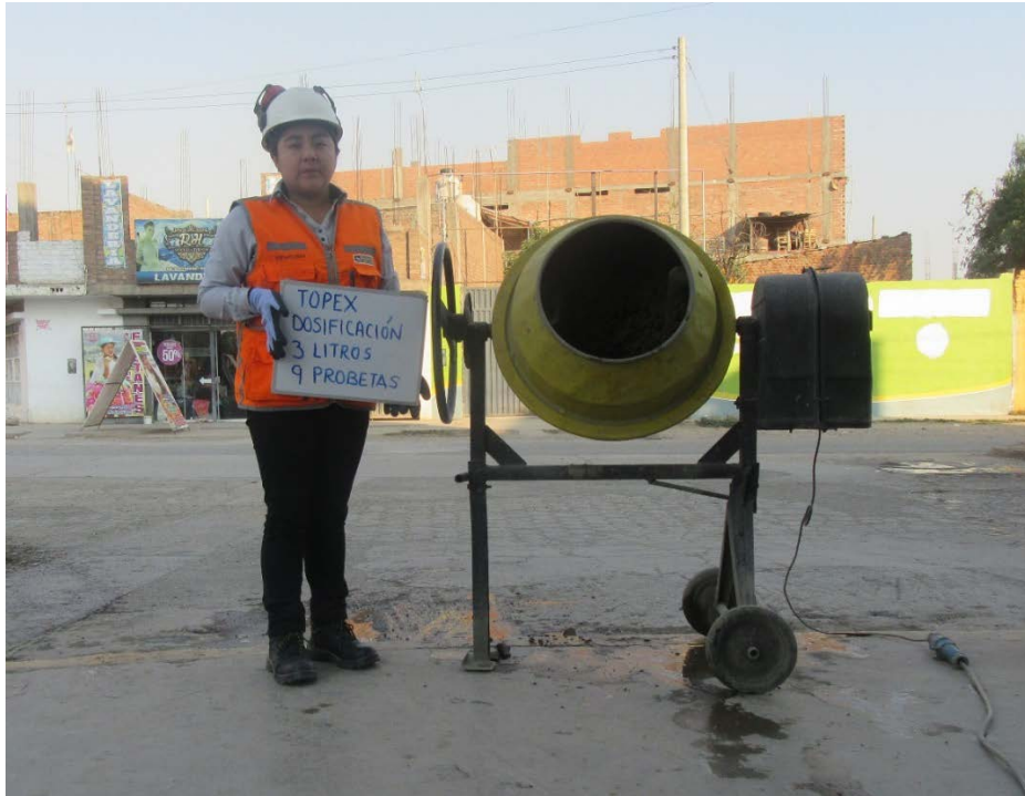
Fotografía 7: Mezclado de materiales para la elaboración del concreto.
