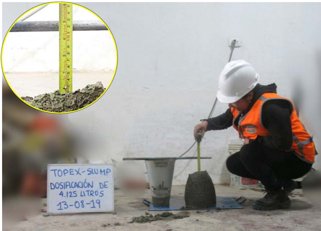
Fotografía 18: Control de asentamiento 4 1/4" de slump de dosificación de 4.125 litros de agua del embolsado Topex.
