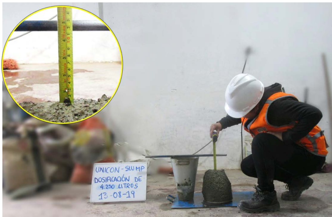
Fotografía 28: Control de asentamiento 4 1/2" de slump de dosificación de 4.25 litros de agua del embolsado Unicon.
