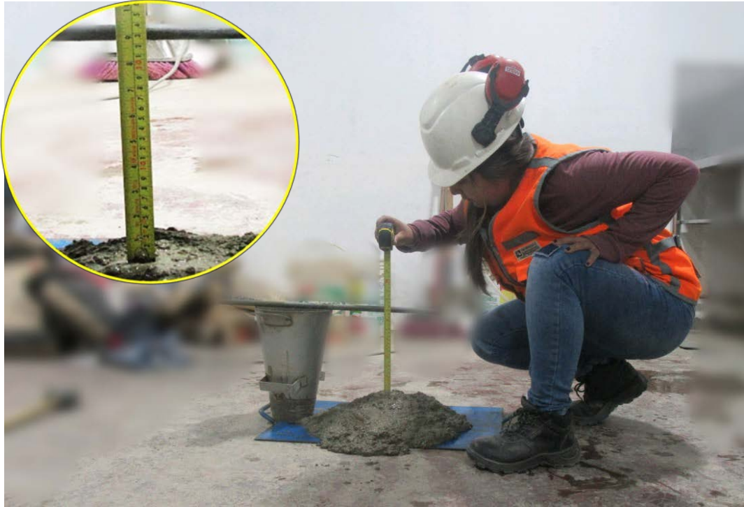
Fotografía 21: Control de asentamiento 8 3/4" de slump de dosificación de 4.75 litros de agua del embolsado Topex..
