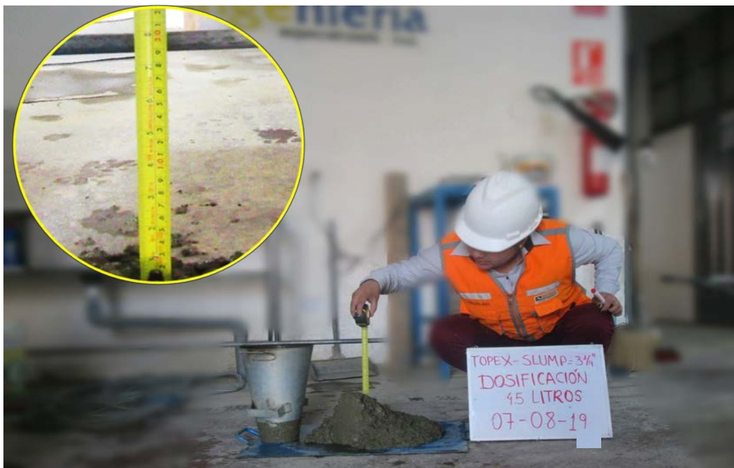
Fotografía 20: Control de asentamiento 7" de slump de dosificación de 4.50 litros de agua del embolsado Topex.
