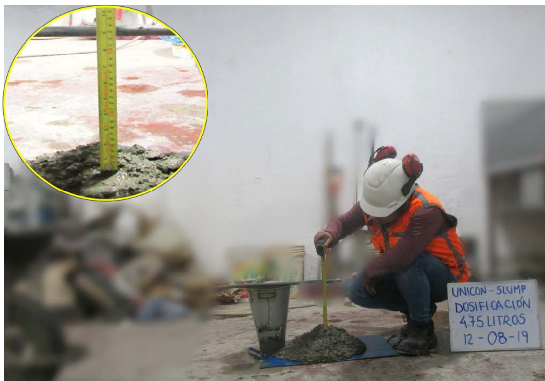
Fotografía 30: Control de asentamiento 8\frac{3}{4} " de slump de dosificación de 4.75 litros de agua del embolsado Unicon.
