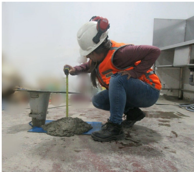
Figura 62. Realizando la medida del asentamiento.
