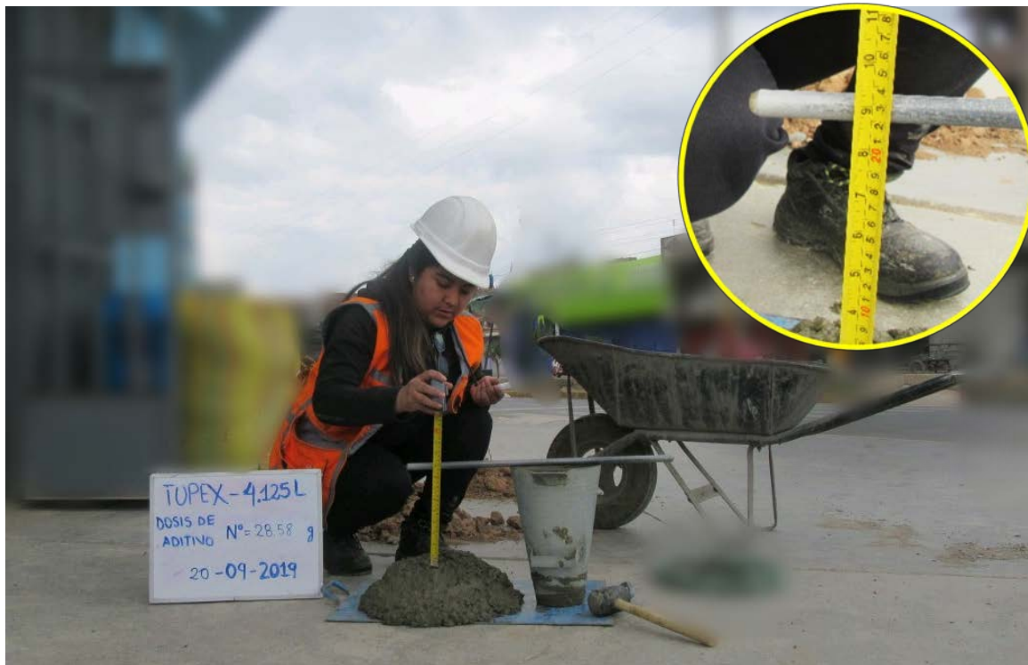
Fotografía 40: Control de asentamiento 8 1/2" de slump de dosificación de 28.58g de aditivo Sika Cem Plastificante del embolsado Topex.
