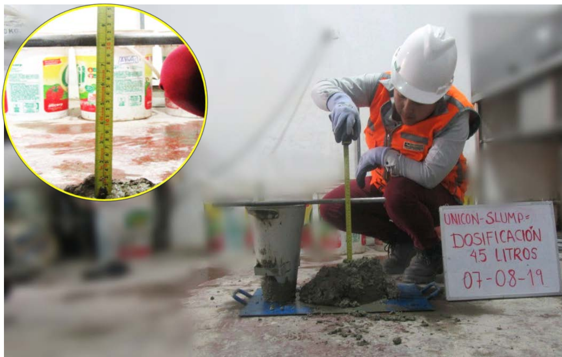
Fotografía 29: Control de asentamiento 7\frac{3}{4} " de slump de dosificación de 4.50 litros de agua del embolsado Unicon.
