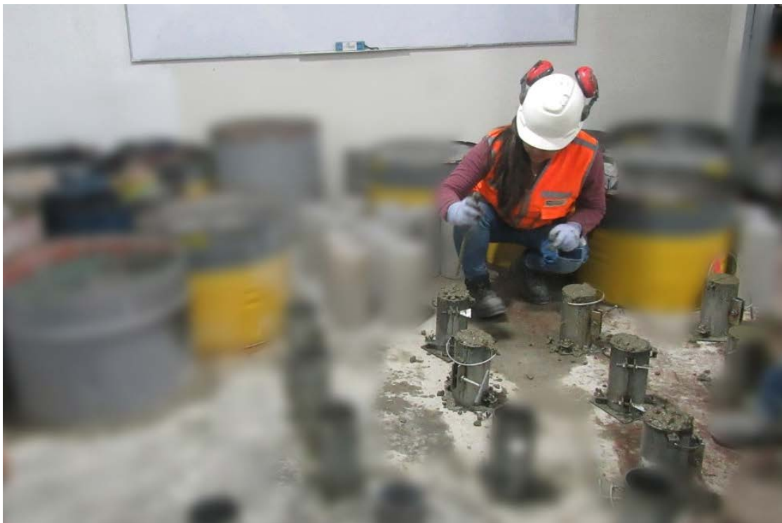
Fotografía 32: Elaboración de especímenes cilíndricos de 4" de diámetro y 8" de altura.
