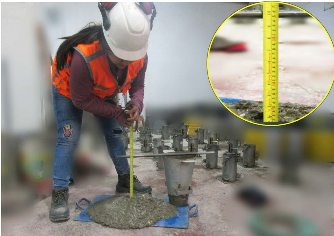
Fotografía 22: Control de asentamiento 9 3/4" de slump de dosificación de 5.00 litros de agua del embolsado Topex.
