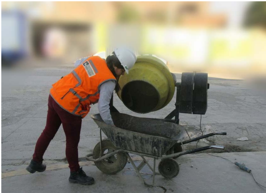
Fotografía 8: Mezclado de concreto.
