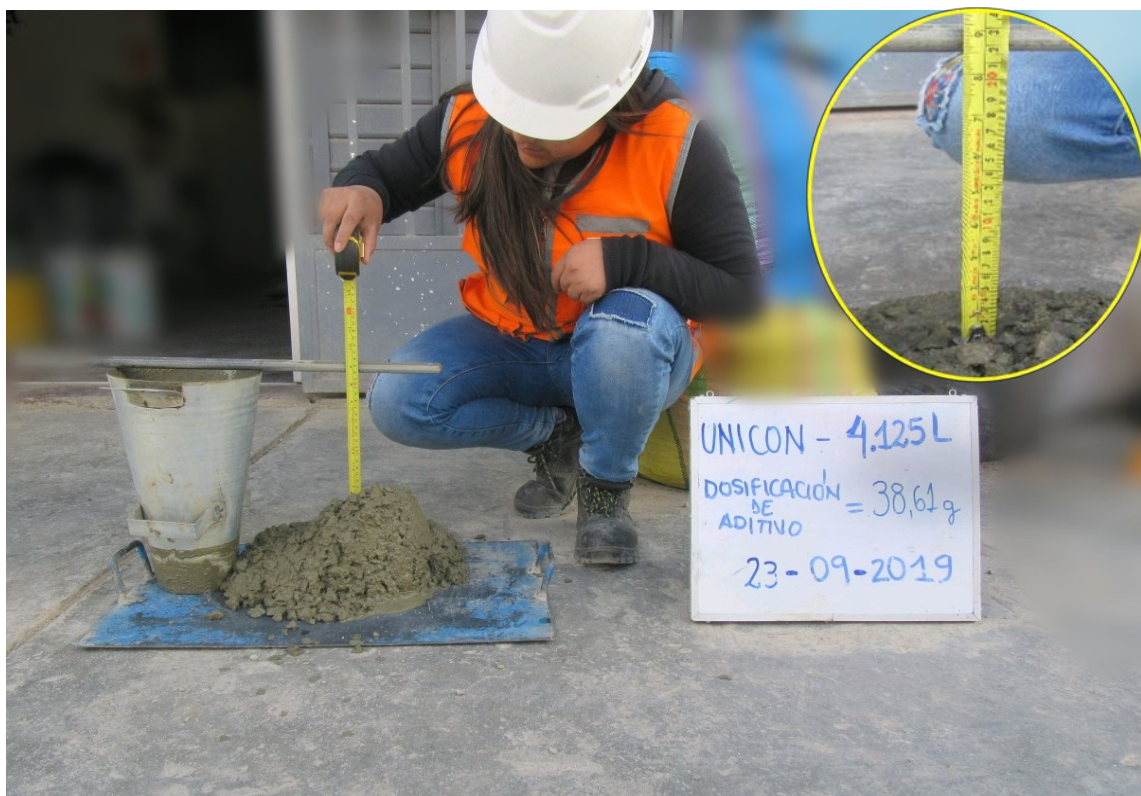
Fotografía 48: Control de asentamiento 8 3/4" de slump de dosificación de 38.61g de aditivo Sika Cem Plastificante del embolsado Unicon.
