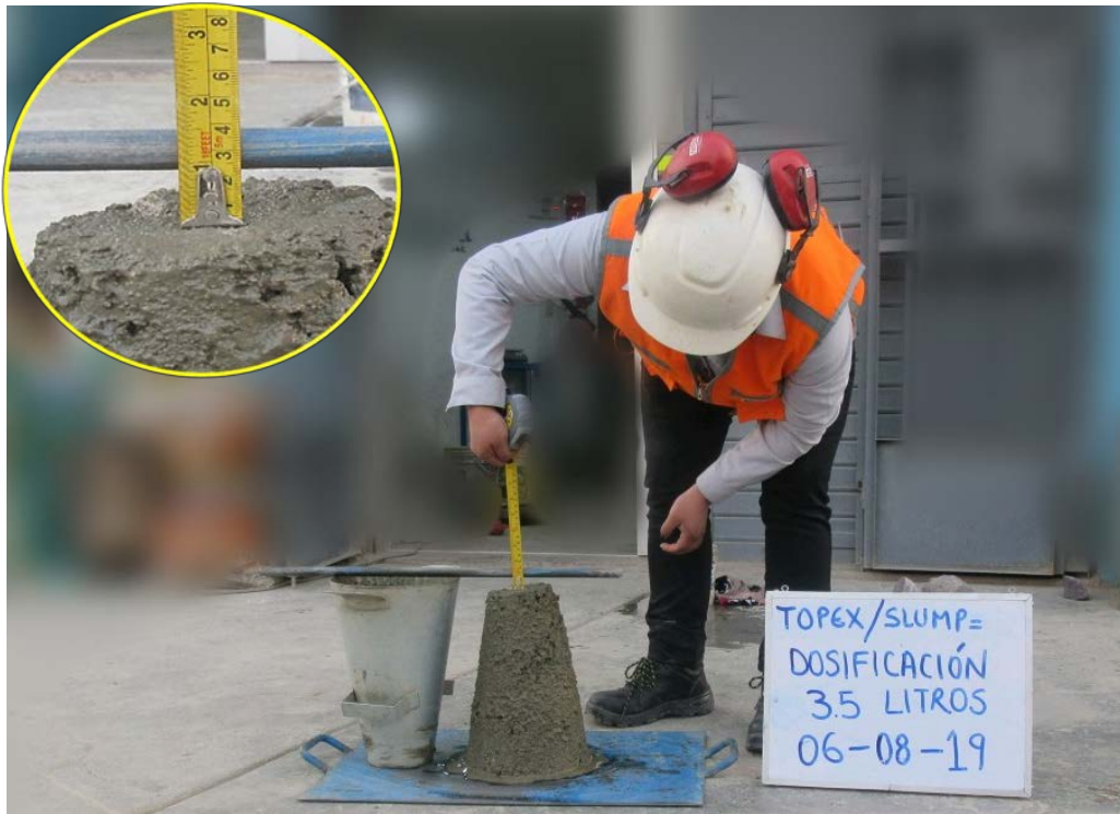
Fotografía 15: Control de asentamiento 1" de slump de dosificación de 3.5 litros de agua del embolsado Topex.
