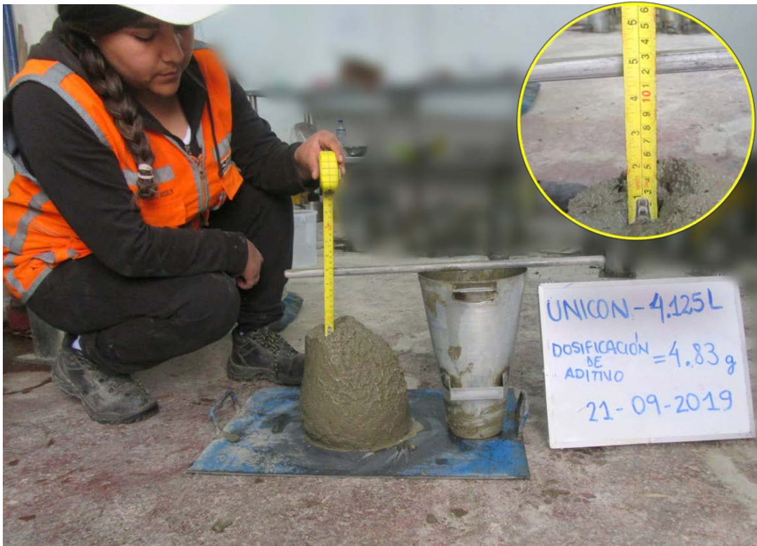
Fotografía 44: Control de asentamiento 4 1/2" de slump de dosificación de 4.83g de aditivo Sika Cem Plastificante del embolsado Unicon.
