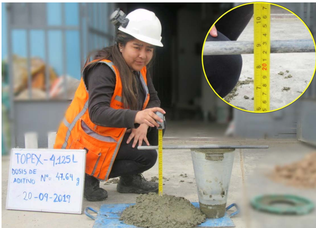
Fotografía 42: Control de asentamiento 9" de slump de dosificación de 47.64g de aditivo Sika Cem Plastificante del embolsado Topex.
