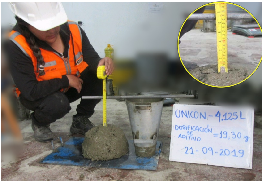
Fotografía 46: Control de asentamiento 6 3/4" de slump de dosificación de 19.30g de aditivo Sika Cem Plastificante del embolsado Unicon.
