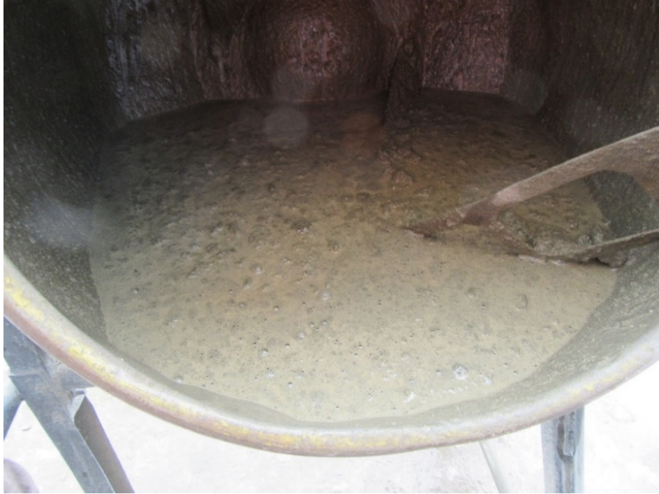
Figura 89. Mezcla de concreto después de terminar el mezclado antes de ser vertida en la carretilla.
