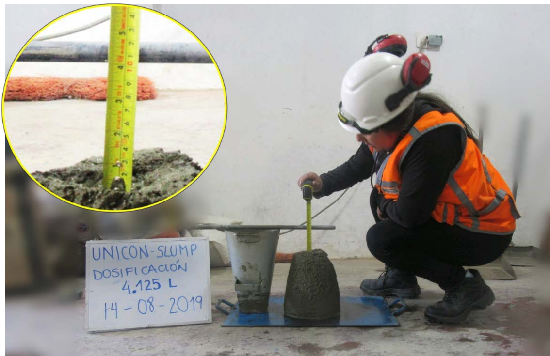
Fotografía 27: Control de asentamiento 4" de slump de dosificación de 4.125 litros de agua del embolsado Unicon.
