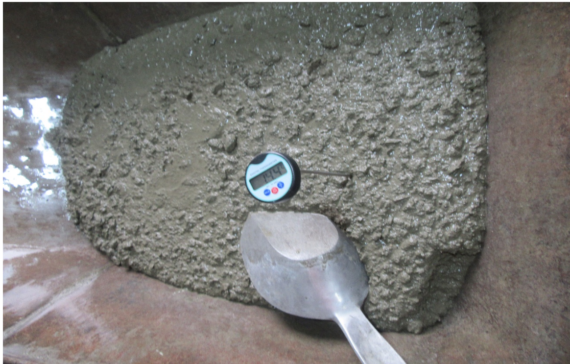
Fotografía 51: Medición de la temperatura en el concreto fresco.
