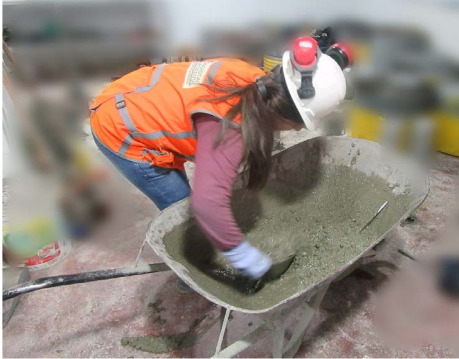
Fotografía 9: Muestreo de concreto para la elaboración de testigos de concreto
