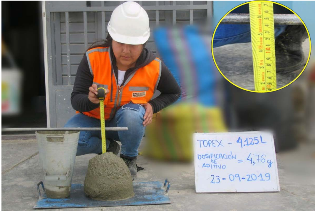
Fotografía 37: Control de asentamiento 5 1/2" de slump de dosificación de 4.76 g de aditivo Sika Cem Plastificante del embolsado Topex
