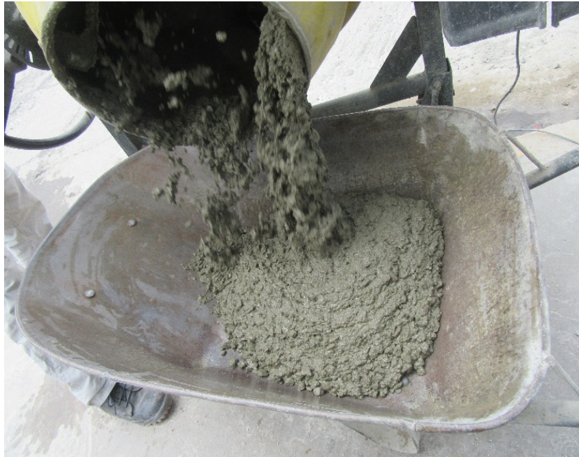
Figura 59. Vertiendo la mezcla después del mezclado.
