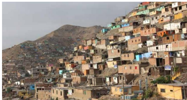
Figura 27. Zona vulnerable por viviendas en laderas sobre pircas.
