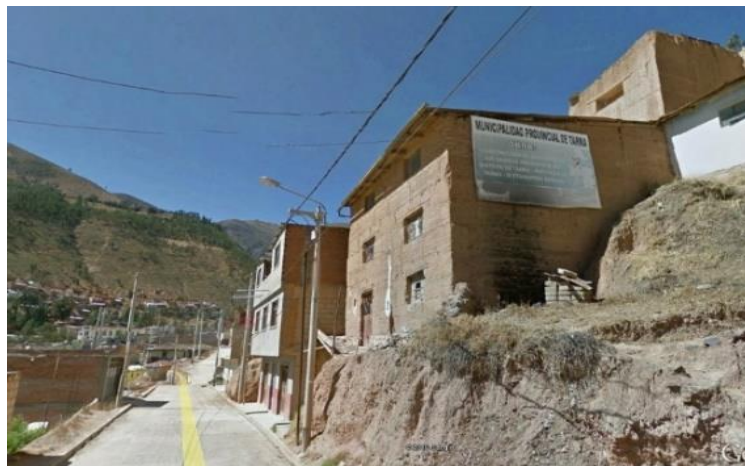
Figura 23. Construcción de las viviendas
