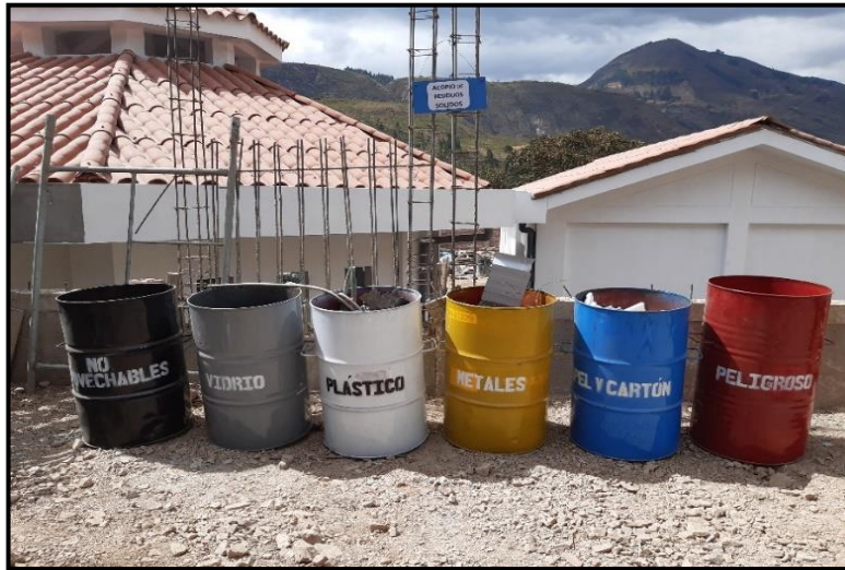
Figura 97. Cilindros para residuos sólidos de mayor volumen para la generación general del proyecto, poseen colores según la norma técnica 900.058-2019.
