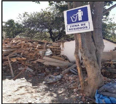
Figura 95. Zona de residuos ubicada en el almacén de obra.
