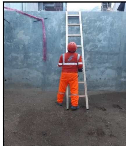
Figura 42. Inspección de escaleras con peldaños en buen estado.
