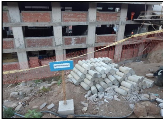
Figura 98. Almacenamiento de testigos para ser reutilizados en los rellenos de cimentación.
