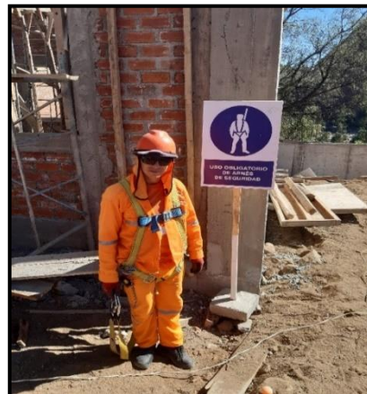
Figura 20. El trabajador encargado de armado de fierros portando arnés de seguridad.
