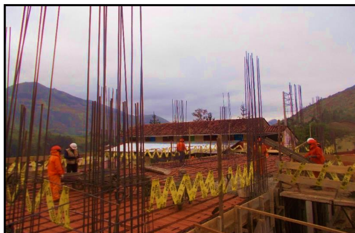
Figura 35. Cerco perimétrico de cintas de seguridad y fierros como protección a los contornos de trabajo.
