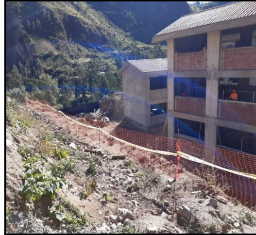
Figura 37. Uso de mallas de protección para cercar el área de excavación.
