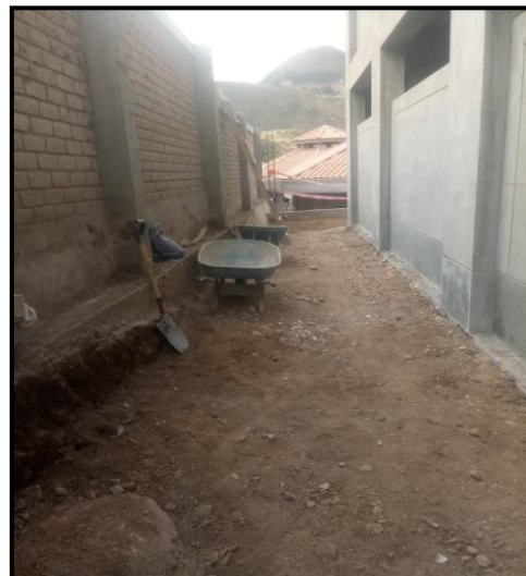
Figura 53. Inspección de áreas con orden y limpieza.
