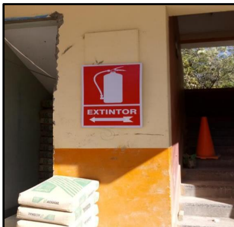
Figura 47. Señalización de extintor.
