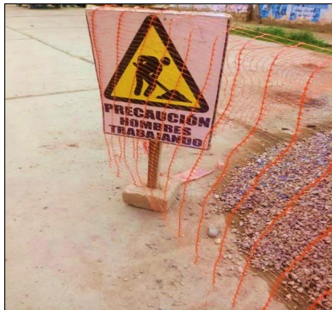
Figura 26. Señalización de Hombres trabajando en el frontis del trabajo.
