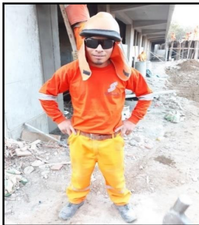
Figura 17. Trabajador de la cuadrilla de tarrajeo usando correctamente el uniforme y equipo de protección personal.
