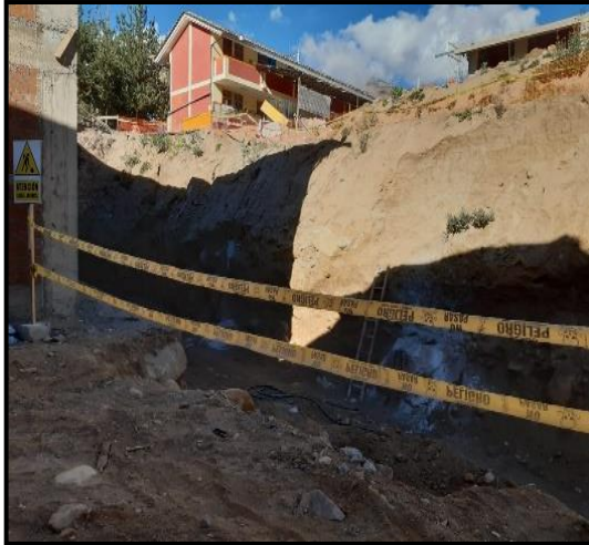
Figura 36. Zona de excavación para muro de contención, uso de cintas de seguridad.
