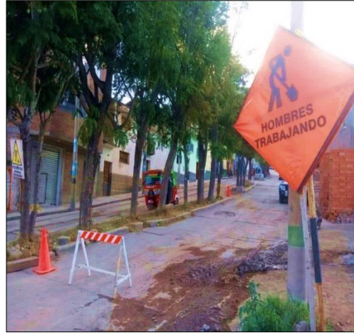
Figura 25. Restricción y señalización de vía para la salida y entrada de maquinarias con participación de vigía.
