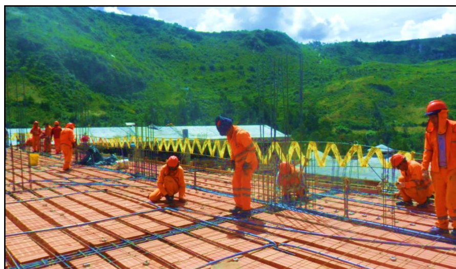
Figura 5. Obra de construcción del colegio Señor de Los Milagros- distrito de San Miguel- provincia La Mar.
