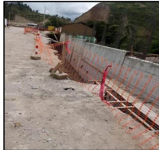
Figura 39. Uso de mallas, cintas y cachacos para cercar la excavación del nivel primario.
