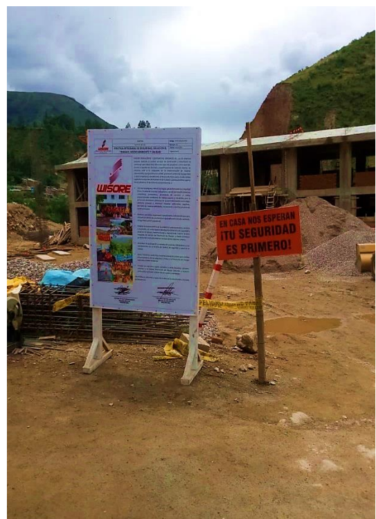
Figura 15. La Política de Seguridad y Salud en el Trabajo ubicada en el ingreso de la obra, entrada principal.
