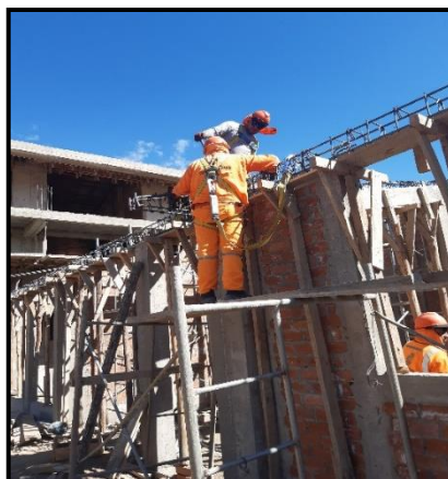
Figura 19. Uso de arnés con línea de vida en trabajos de altura.
