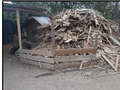
Figura 101. Almacenamiento de residuos de madera, son utilizados como leña para el comedor de obra.
