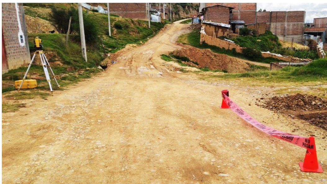
Figura N.º 2. Av. Integración Este-Torre Torre, Huancayo. (Subrasante a estabilizar)
