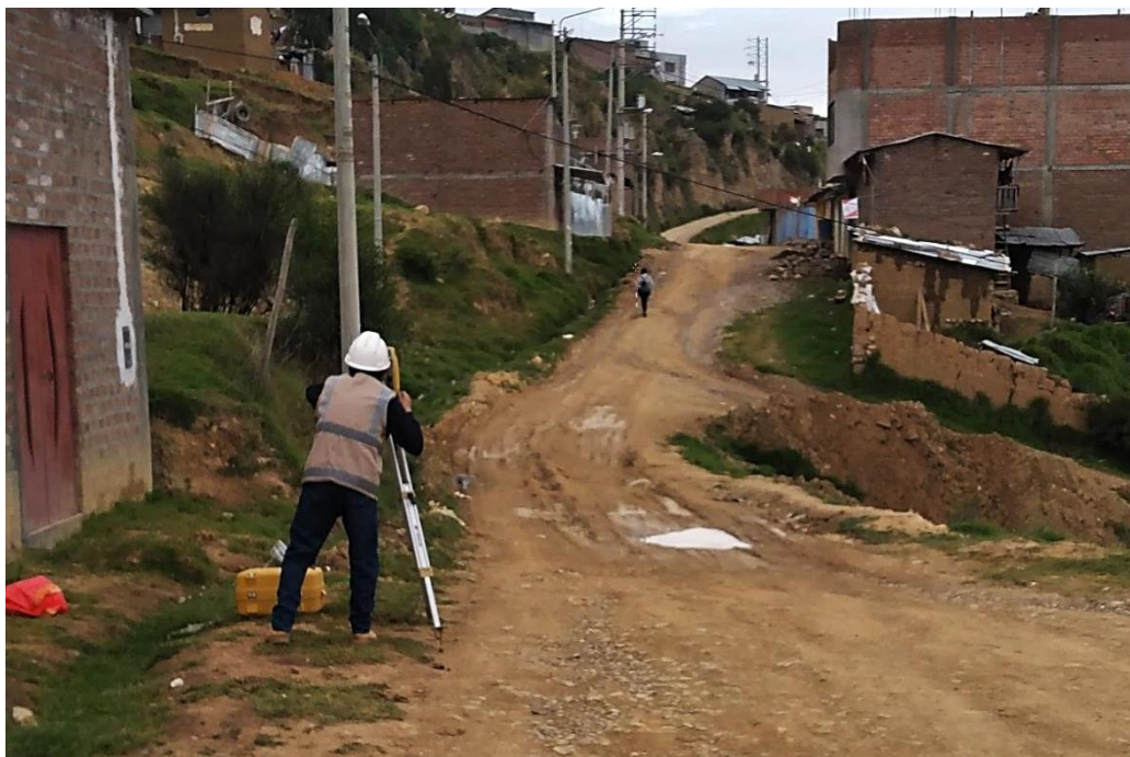
1. (Foto de Wilbert C.) (08/03/2021, Torre Torre, Huancayo). Levantamiento topográfico de la Av. Integración Este, tramo entre Jr. Orión -l Jr. Álamos, longitud de 198 m.
