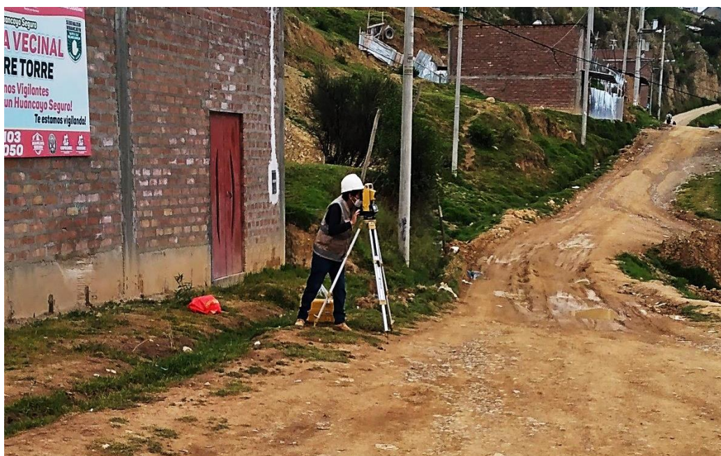
2. (Foto de Wilbert C.) (08/03/2021, Torre Torre, Huancayo). Levantamiento topográfico de accesos de la Av. Integración Este.
