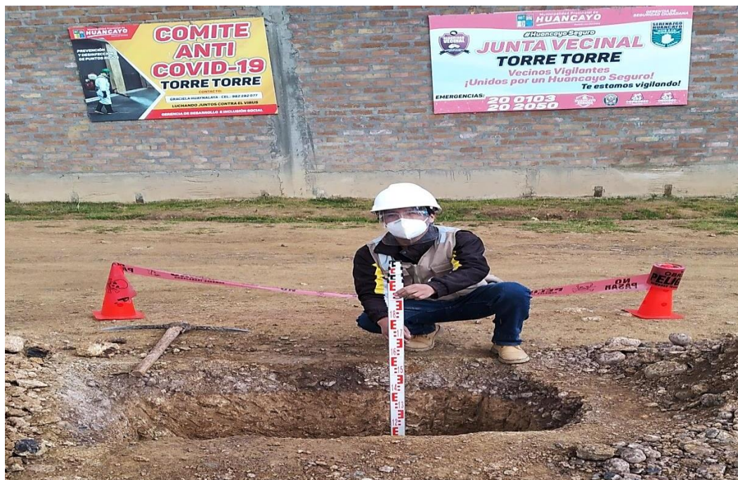
3. (Foto de Wilbert C.). (08/03/2021, Torre Torre, Huancayo). Excavación de 1.5 metros de profundidad (calicata N.º 1).
