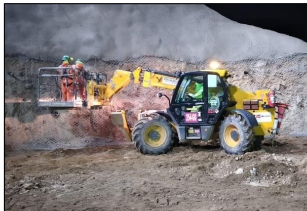
Figura 68. Colocación de barbacanas
