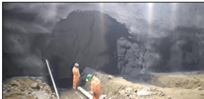
Figura 100. Marcación de puntos para encofrado de marco
