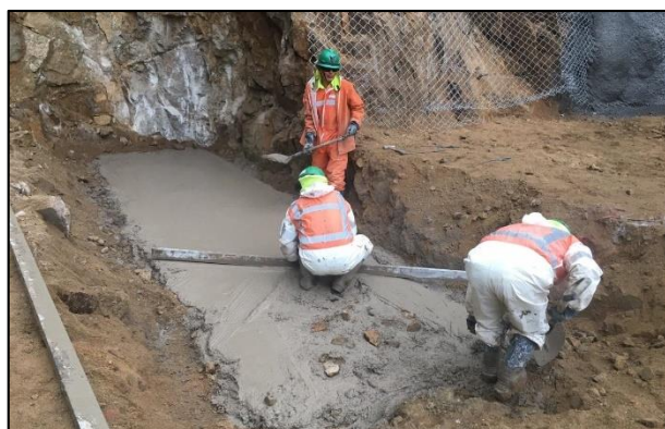
Figura 93. Reglado de solado
