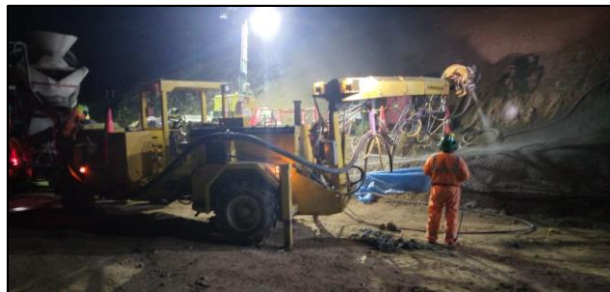
Figura 75. Lanzado de shotcrete en tramo 2G, cota 0+91 Fuente: Elaboración propia
