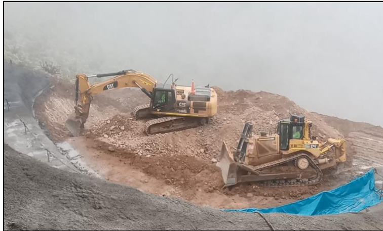
Figura 42. Excavación y limpieza de banco 2A
