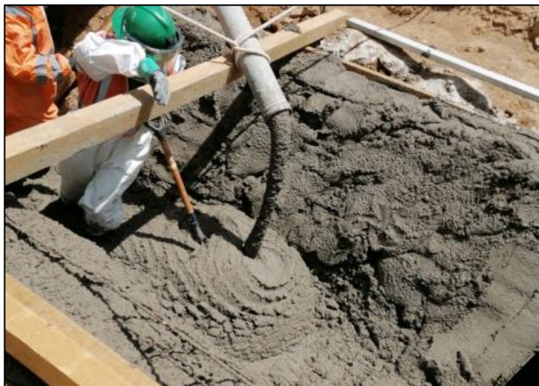
Figura 31. Vaciado de la zanja de coronación (Contrafoso)
