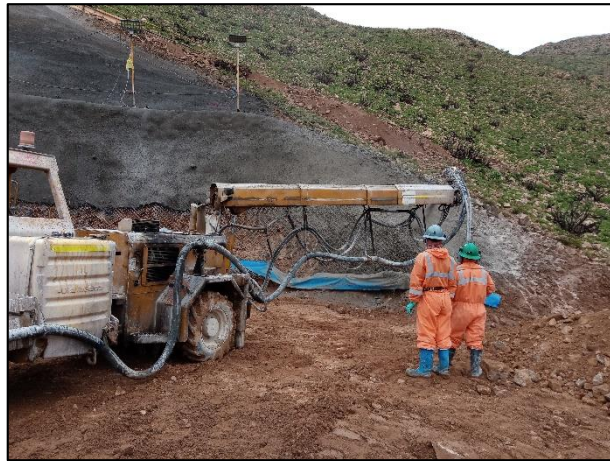
Figura 74. Lanzado de shotcrete banco 2C, cota 0+00. Fuente: Elaboración propia
