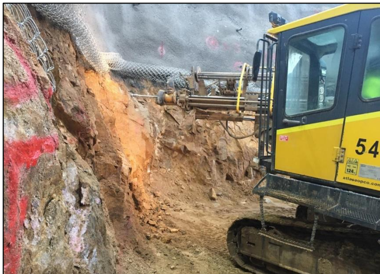
Figura 49. Perforación para barbacanas o lloronas banco 2F Fuente: Elaboración propia
