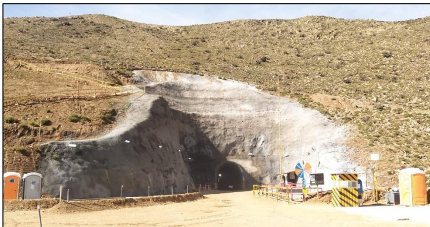
Figura 117. Portal entrada totalmente fortificado Fuente: Elaboración propia
