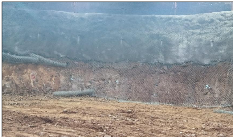
Figura 54. Tendido de malla en banco 2C
