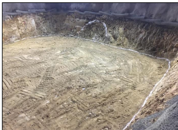
Figura 82. Marcación de paraguas del falso túnel
