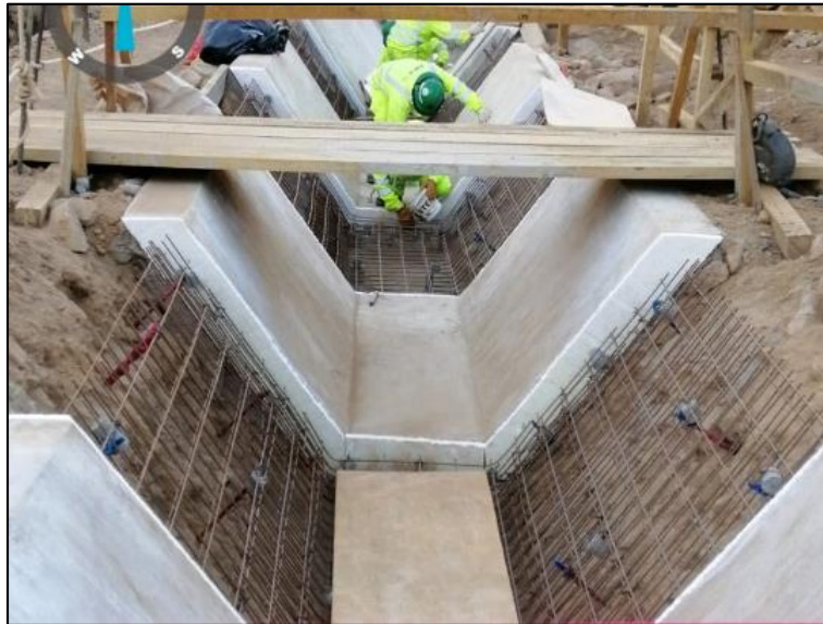
Figura 30. Colocación de mallas electro soldada
