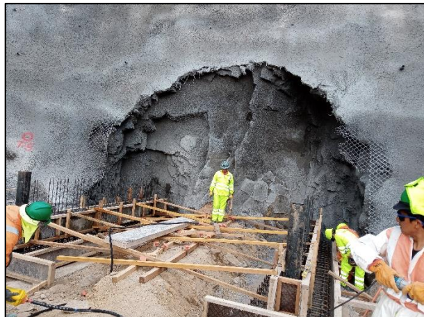
Figura 103. Encofrado de cimentación Fuente: Elaboración propia
