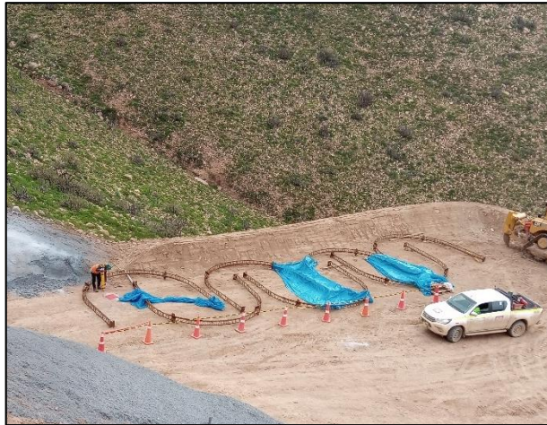
Figura 102. Torqueo de pernos en marcos reticulados (7 unidades) Fuente: Elaboración propia
