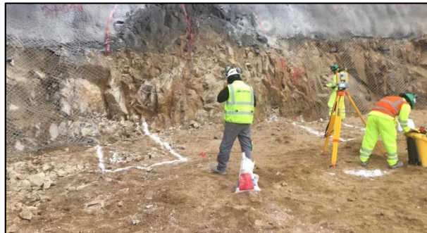
Figura 89. Marcación de zapata para falso tunel Fuente: Elaboración propia
