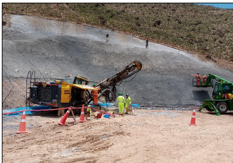
Figura 47. Perforación con Rock Drill para pernos helicoidales banco
