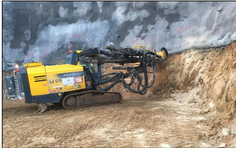
Figura 48. Perforación para pernos helicoidales en banco 2F Fuente: Elaboración propia
