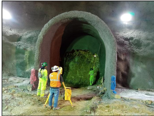
Figura 116. Verificación del eje del falso túnel y liberación Fuente: Elaboración propia
