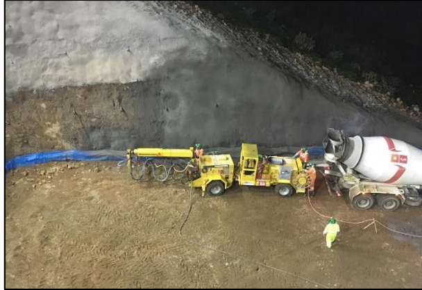
Figura 76. Lanzado de shotcrete en tramo 2G, cota 0+08 Fuente: Elaboración propia
