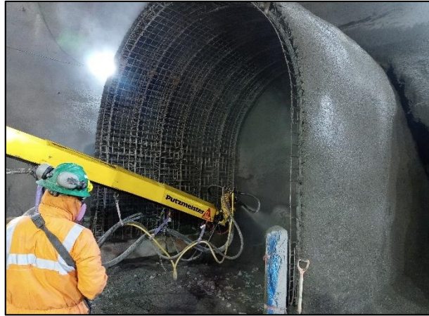
Figura 115. Lanzado de shotcrete por Interior de Falso tunel Fuente: Elaboración propia
