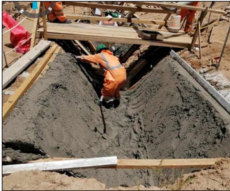
Figura 32. Reglado de zanja de coronación
