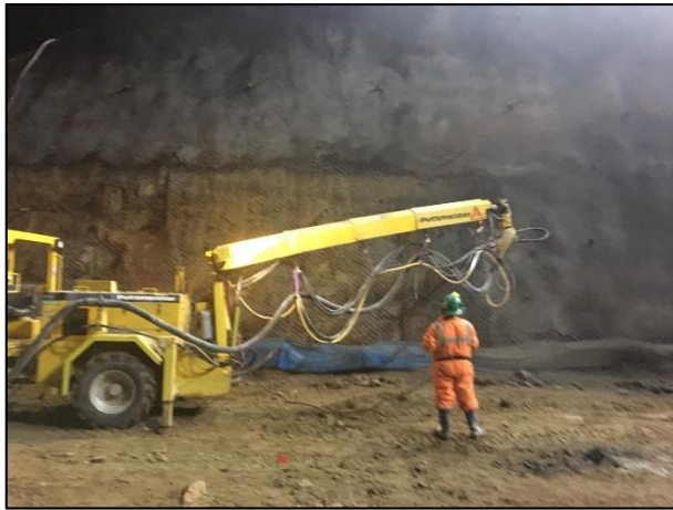
Figura 77. Lanzado de shotcrete en tramo 2G, cota 0+75 Fuente: Elaboración propia
