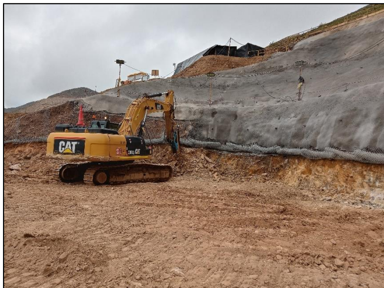
Figura 43. Percusión con martillo hidráulico en banco 2B
