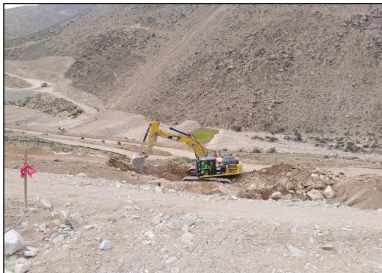
Figura 39. Inicio de excavación del talud, banco 1A
