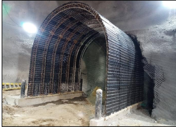
Figura 113. Falso túnel listos para ser recubierto con shotcrete Fuente: Elaboración propia
