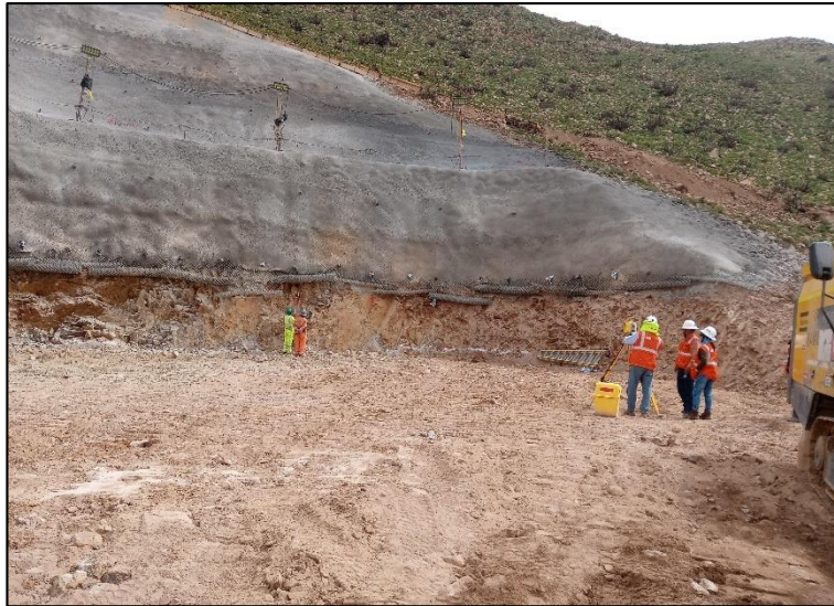
Figura 46. Verificación topográfica de banco excavado 2E
