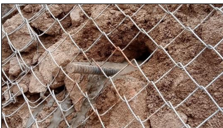
Figura 59. Perno helicoidal inyectado con lechada
