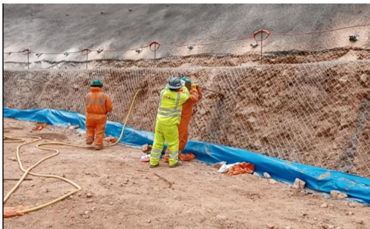
Figura 57. Colocado de Lechada a/c<0.35
