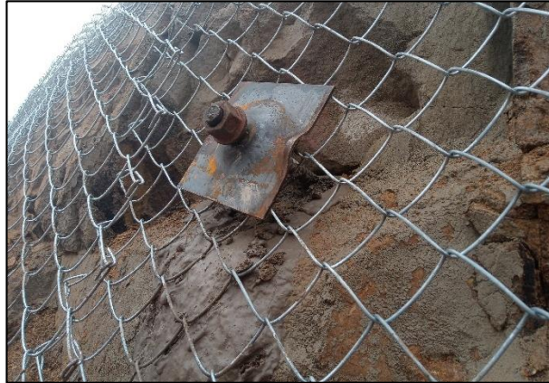
Figura 60. Perno helicoidal con placa y tuerca de sujeción
