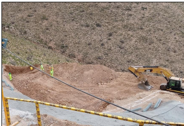
Figura 45. Personal ingresando para desquinche banco 2E Fuente: Elaboración propia
