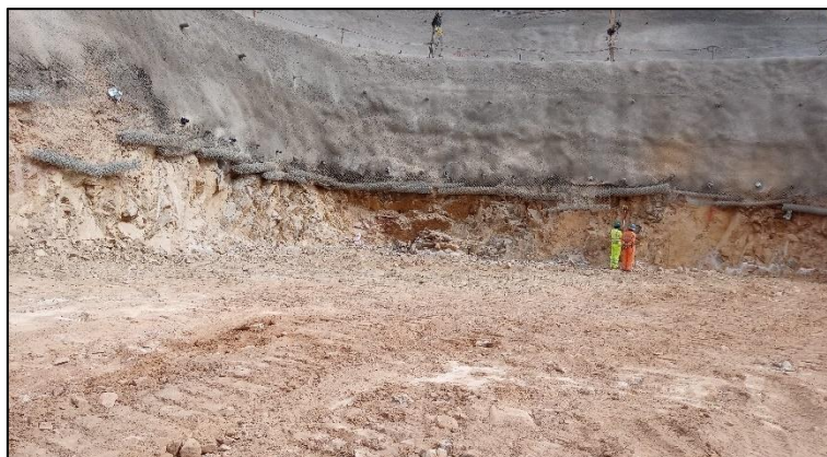
Figura 50. Frente totalmente perforado, banco 2C Fuente: Elaboración propia
