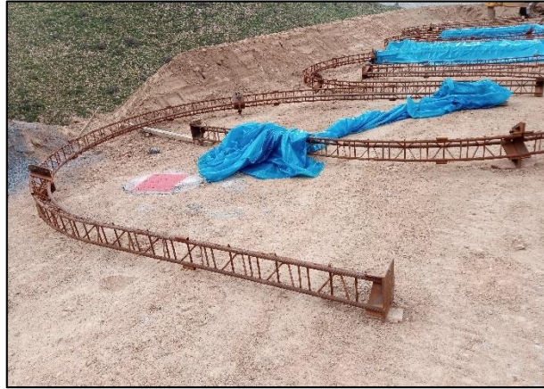
Figura 101. Marco reticulado, armado y torqueado 80 lb. Fuente: Elaboración propia
