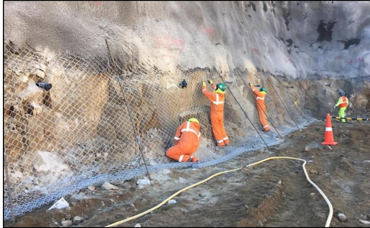
Figura 53. Tendido de malla en banco 2C
