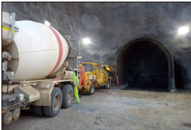
Figura 114. Lanzado de shotcrete por Exterior Fuente: Elaboración propia
