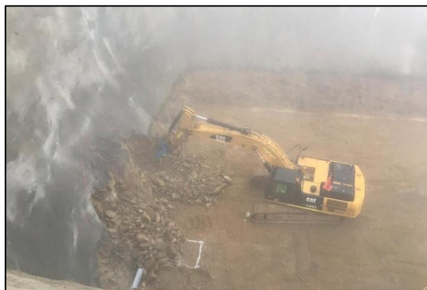
Figura 90. Excavación de zapata para falso tunel Fuente: Elaboración propia
