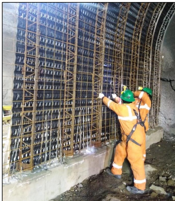
Figura 112. Colocado de mallas electro soldadas interior
