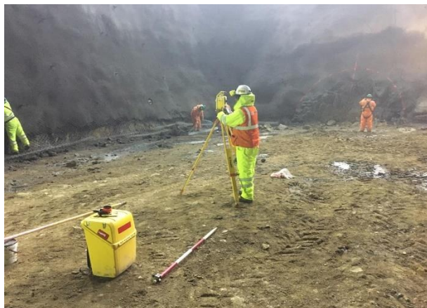
Figura 78. Verificación de la pendiente y liberación tramo 2G Fuente: Elaboración propia
