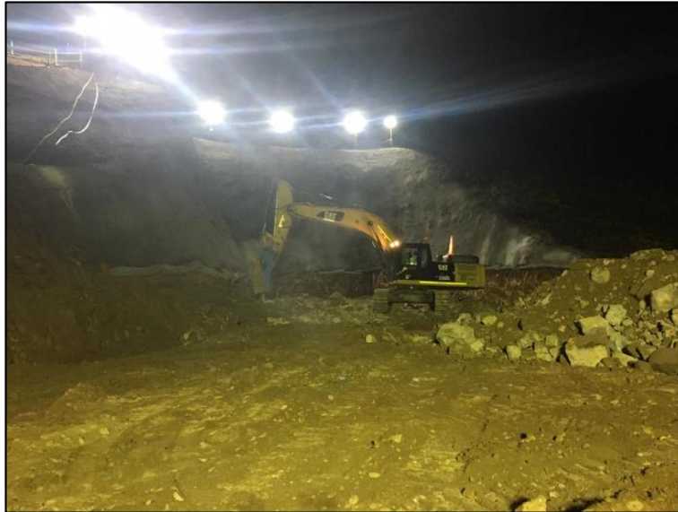
Figura 44. Percusión con martillo hidráulico en banco 2G Fuente: Elaboración propia
