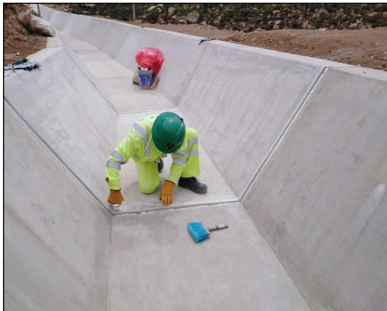
Figura 33. Aplicado de Sika flex en junta
