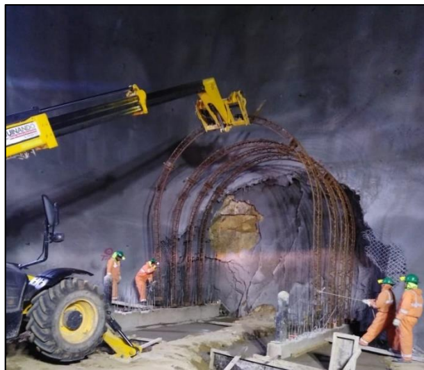
Figura 108. Colocación de los demás marcos reticulados Fuente: Elaboración propia
