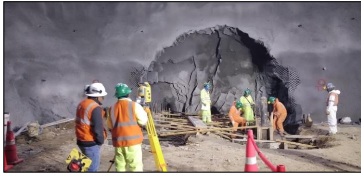
Figura 104. Verificación de cimentación previo al vaciado
