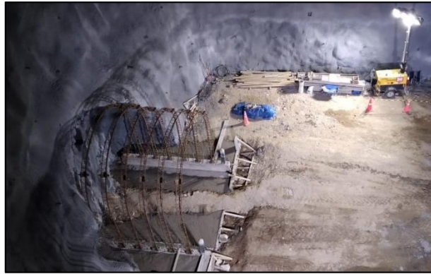
Figura 109. Marco reticulado completado
