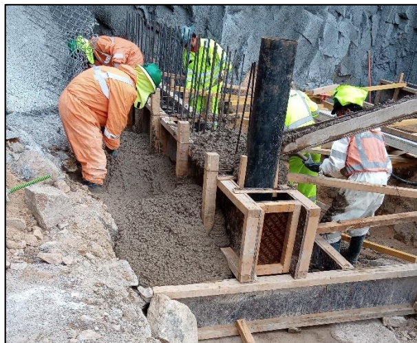
Figura 105. Vaciado de cimentación
