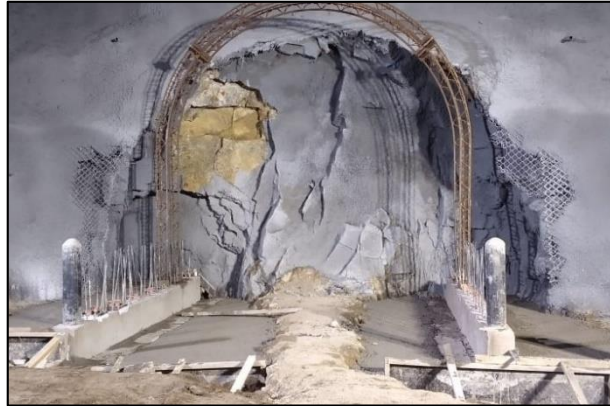
Figura 107. Colocación del primer marco reticulado Fuente: Elaboración propia
