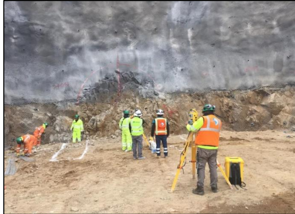
Figura 88. Global mapping marcando zapata Fuente: Elaboración propia
