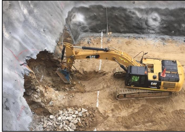
Figura 91. Percusion de zapatas para falso túnel
