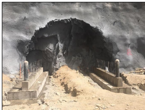
Figura 106. Cimentación de marco reticulado
