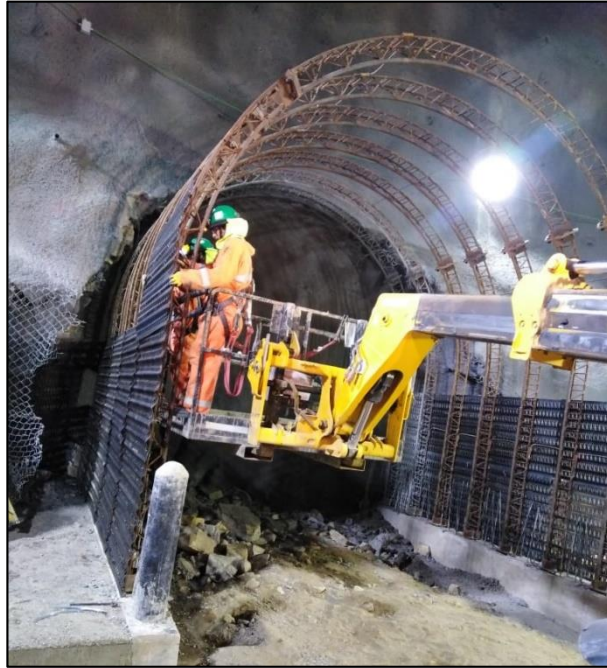
Figura 111. Colocación de las planchas bernold en otro extremo
