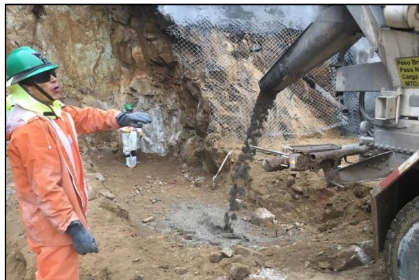
Figura 92. Vaciado de solado para cimentación
