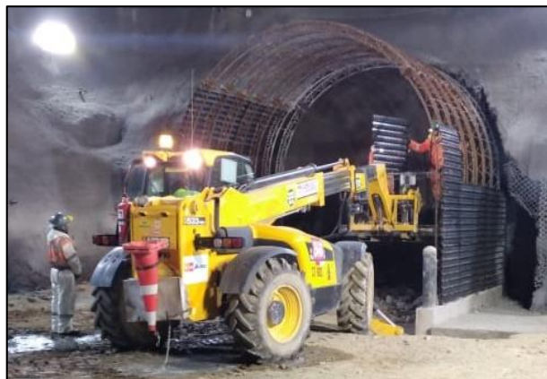
Figura 110. Colocación de las planchas bernold
