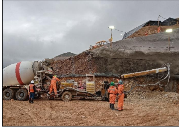
Figura 73. Lanzado de shotcrete banco 2C Fuente: Elaboración propia
