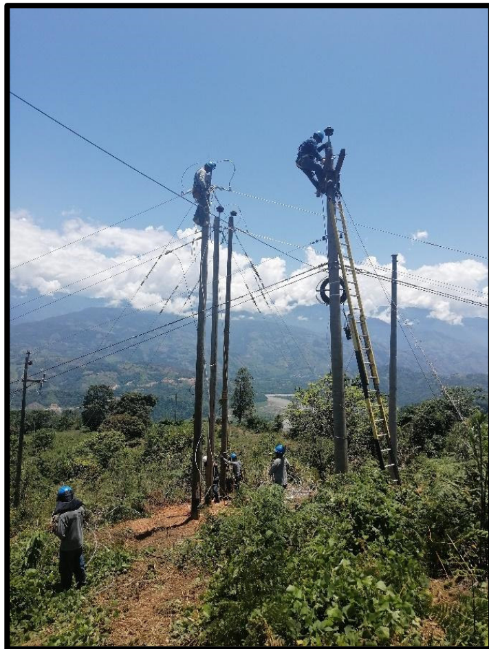
Figura 21. Ejecución de los trabajos de mantenimiento de las estructuras de MT
