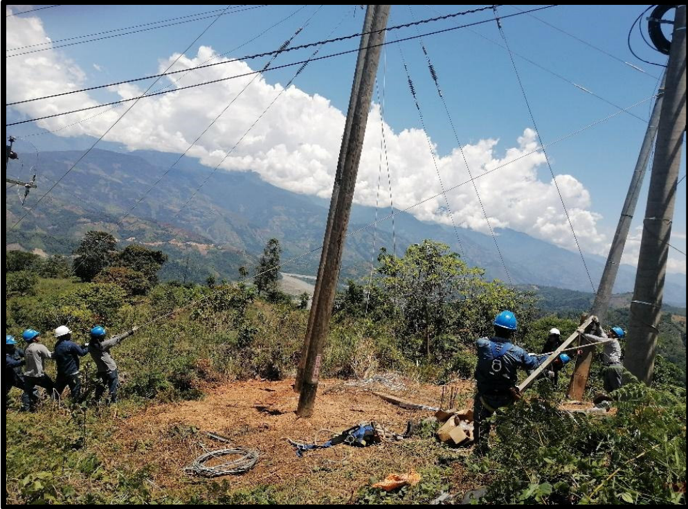
Figura 22. Trabajos de verticalización de postes en el alimentador A4028
