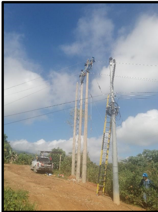
Figura 15. Supervisión de los trabajos de correctivos en las redes eléctricas del alimentador A4028
