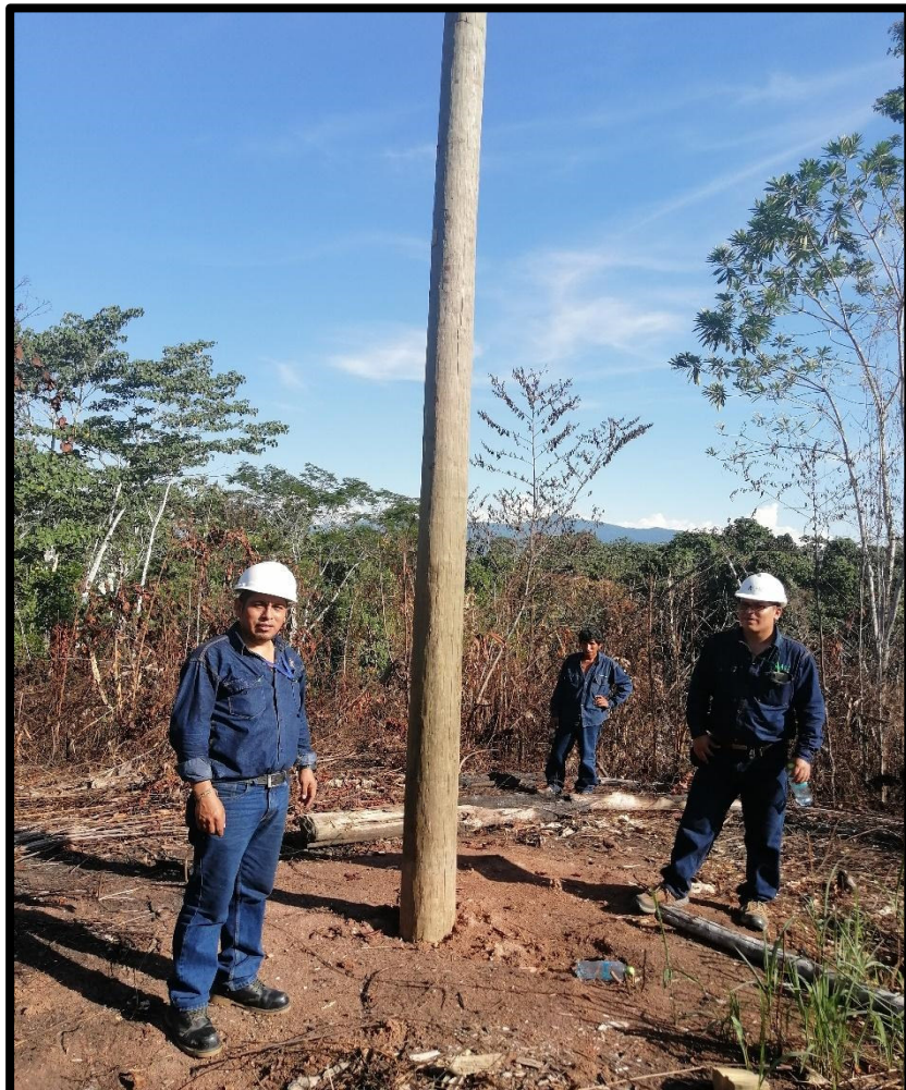
Figura 23. Supervisión e inspección de las actividades realizadas por la contratista
