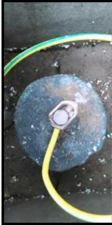
**Figura 12. Cemento conductivo adherido a una barra**
