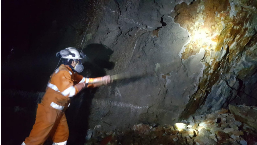
Supervisión de sistema de sostenimiento (Shotcrete)
