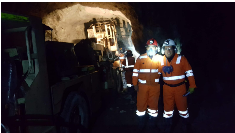
Supervisión de la perforación
