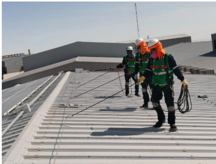
Figura 3: Limpieza industrial (Limpieza en alturas)
