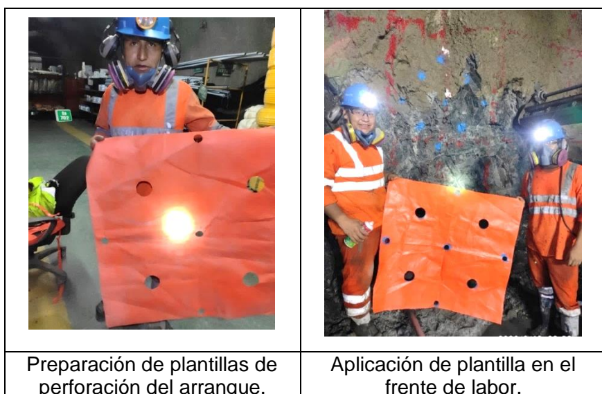
Figura 51. Plantilla de perforación de arranque
