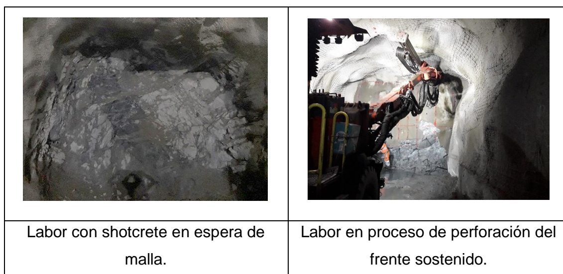
Figura 41. Proceso de shotcrete y perforación de la Rp 073
