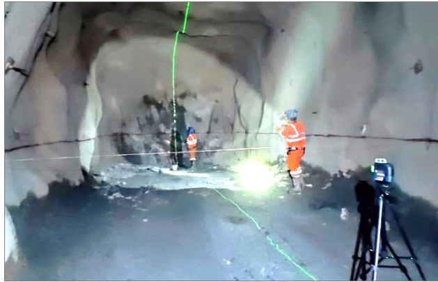
Figura 49. Marcado de malla con el equipo marcador laser
