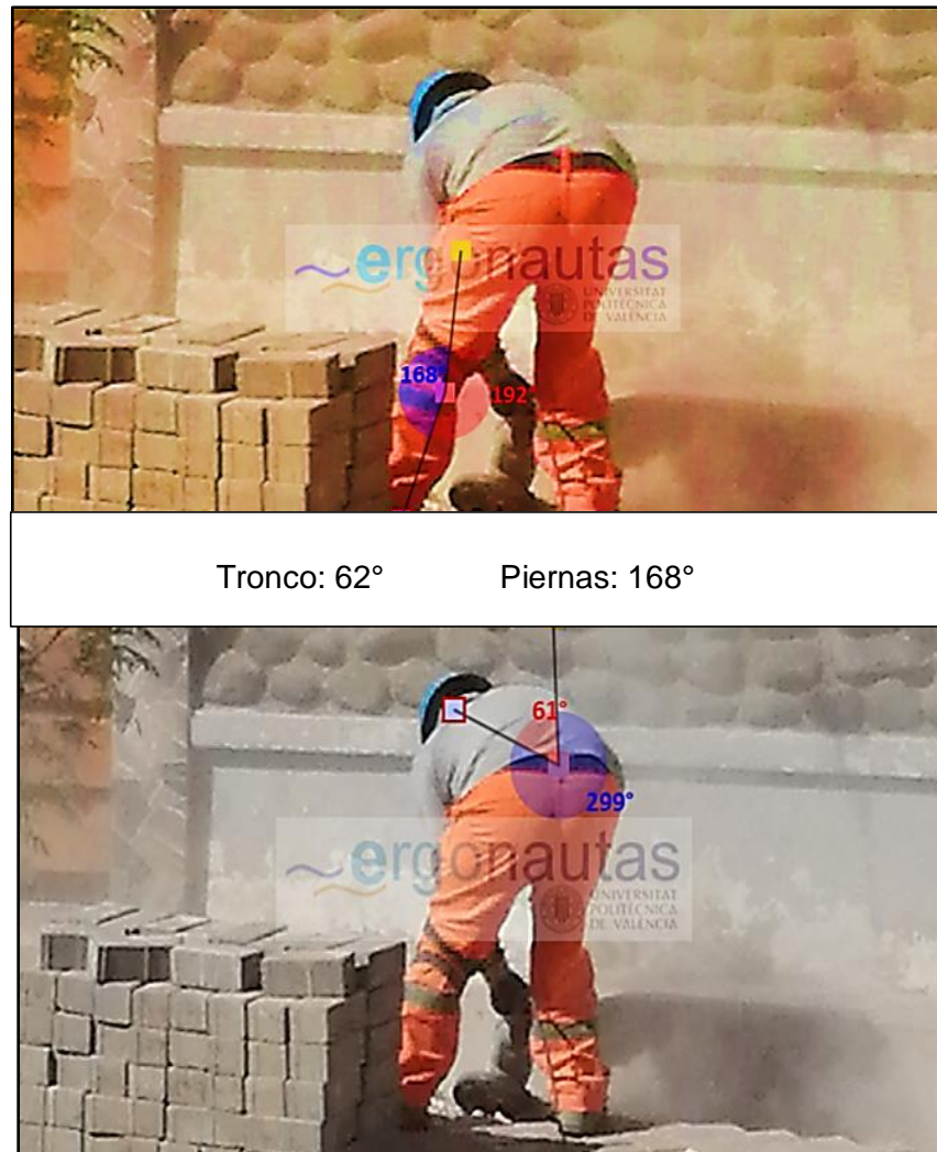
Figura 15. Operario 4 en corte para ajustes de instalación
