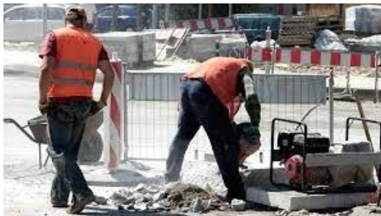
Figura 36. Manipulación manual de adoquines y equipos de corte
