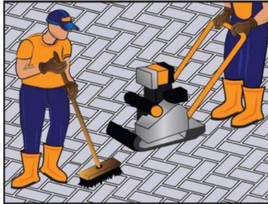
Figura 8. Sellado de las juntas. Tomada de «Guía de instalación de adoquines de concreto», por Instituto del Cemento y del Concreto de Guatemala, 2017, p. 33.
