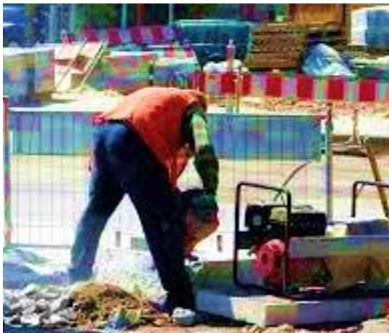
Figura 10. Corte para ajustes de instalación.
