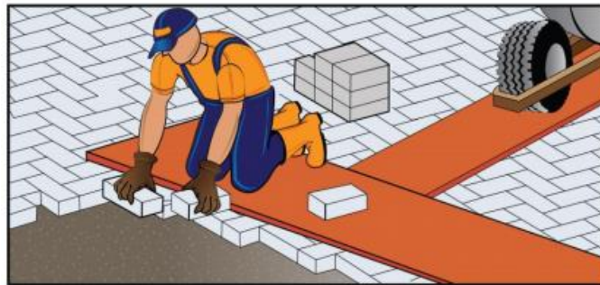
Figura 5. Colocación de los tramos del pavimento. Tomada de «Guía de instalación de adoquines de concreto», por Instituto del Cemento y del Concreto de Guatemala, 2017, p. 30.
