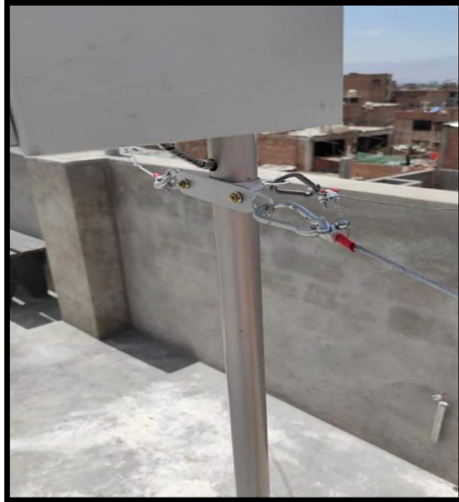
Figura 51. Anclajes para estabilización
