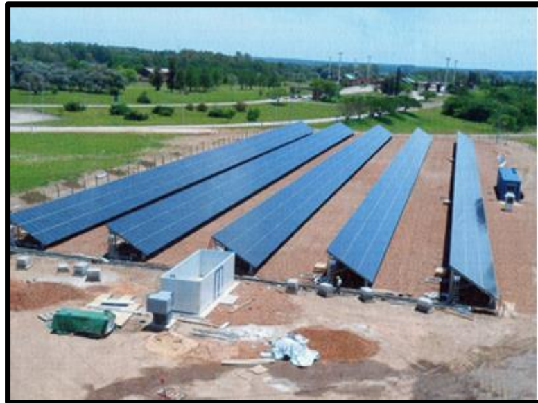
Figura 20. Generador fotovoltaico. Tomada de Ir21.com.uy
