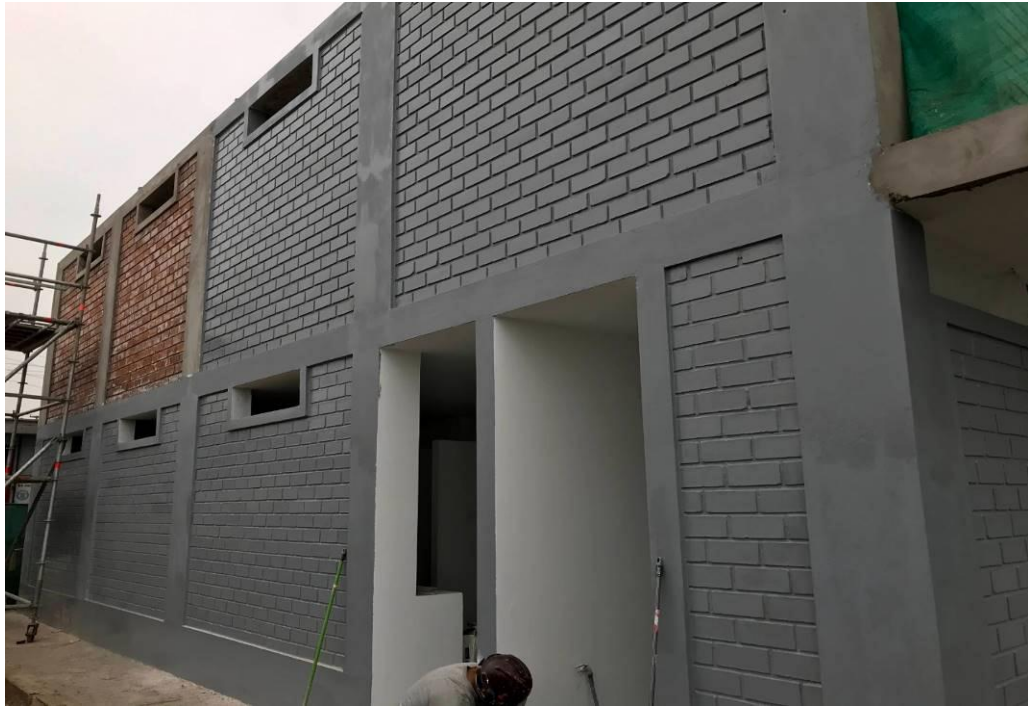
Figura 32. Pintado de muros
