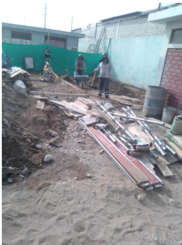
Figura 24. Excavación manual para cimientos
