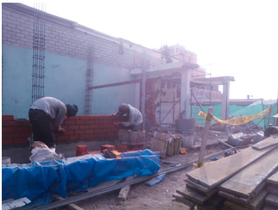
Figura 28. Levantamiento de muro
