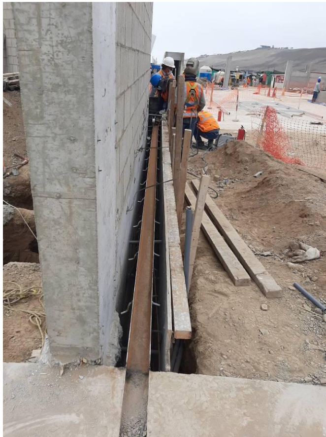
Figura 62. Instalación de riel para portón en patio de estacionamiento
