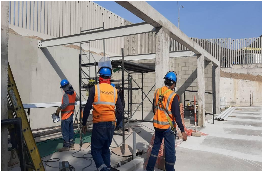
Figura 56. Montaje de estructura en el cuarto de residuos
