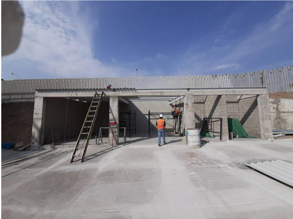
Figura 57. Montaje de TR4 en el cuarto de residuos
