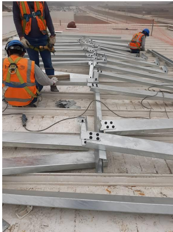
Figura 64. Montaje de estructura sobre nave
