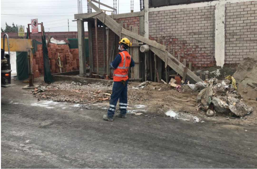
Figura 30. Encofrado de escalera
