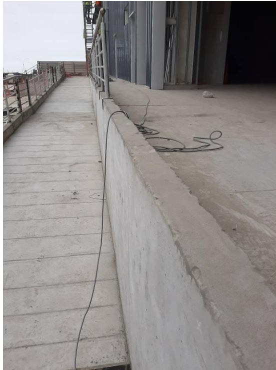
Figura 59. Instalación de Barandas exterior de nave
