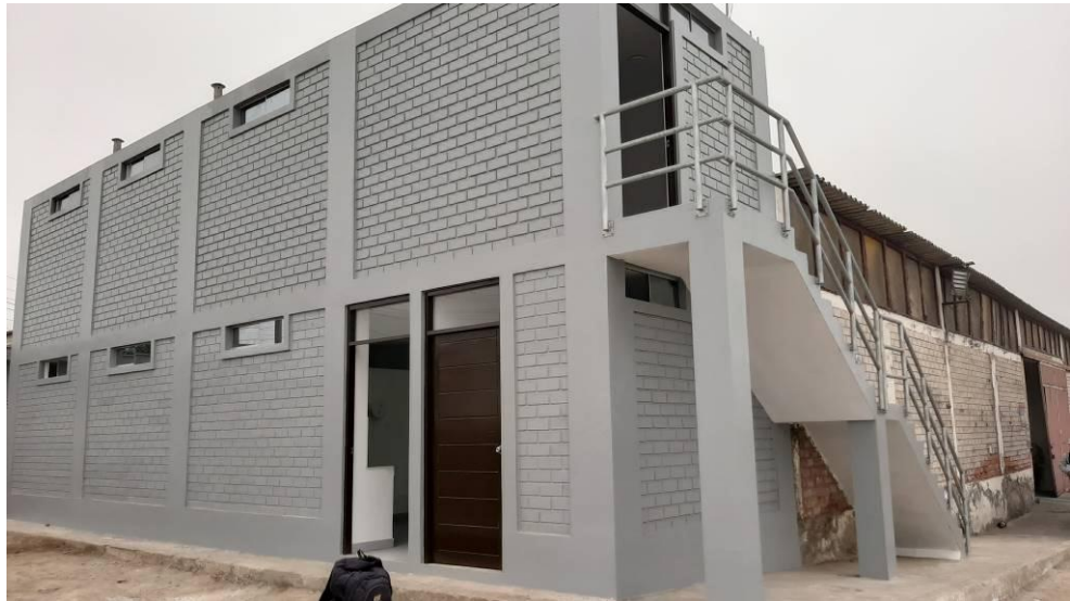
Figura 2. Obra concluida “Vestidores y SS.HH. – Oquendo 1” – Quimpac
