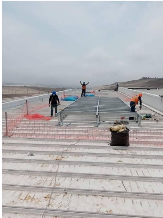
Figura 65. Montaje de Estructura en fase final
