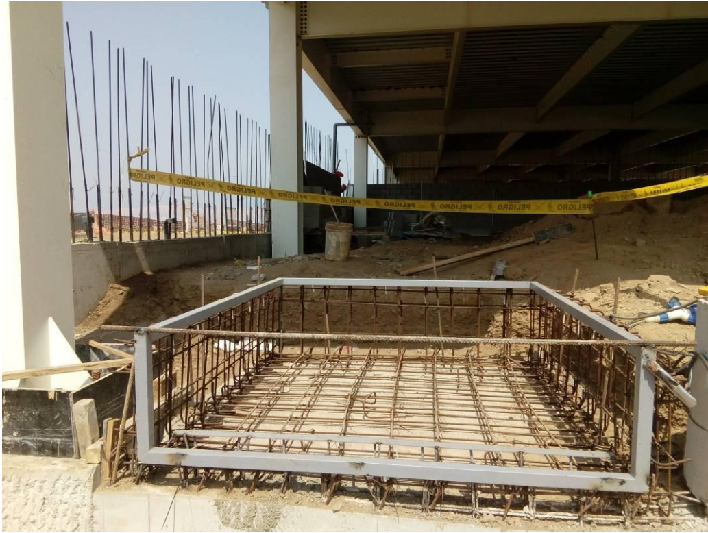
Figura 55. Montaje de estructura para plataforma elevadiza
