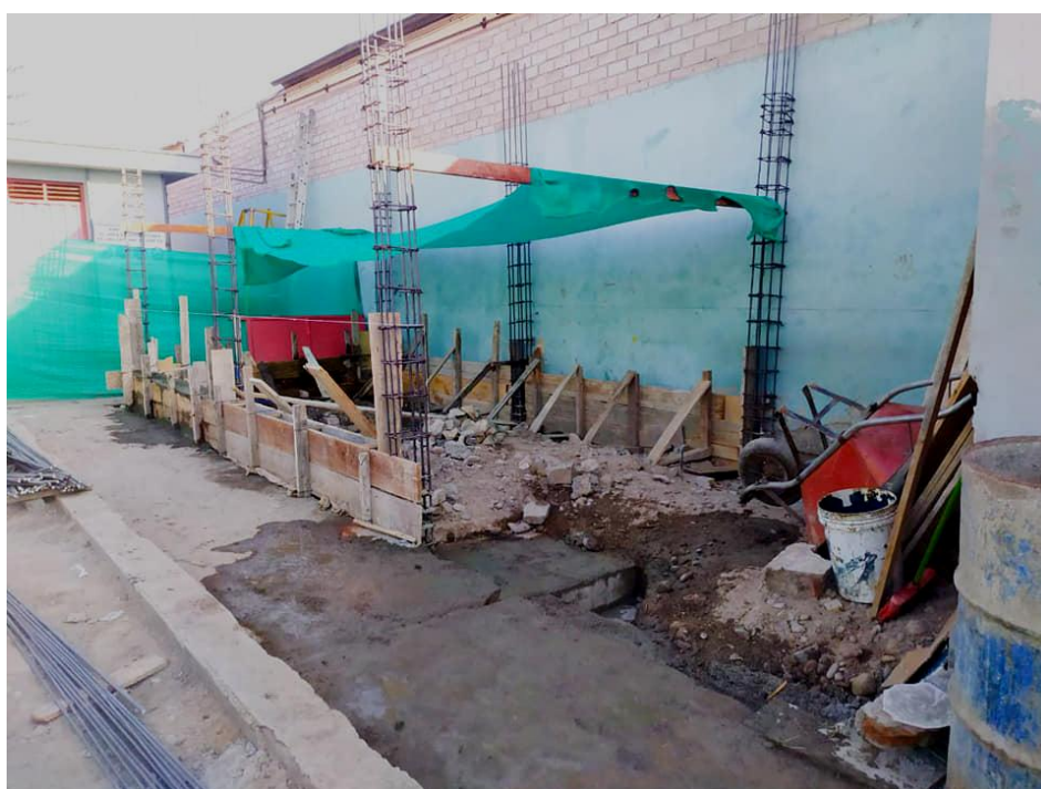
Figura 27. Vaciado de sobre cimientos
