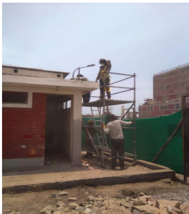
Figura 25. Demolición de SS.HH. existentes
