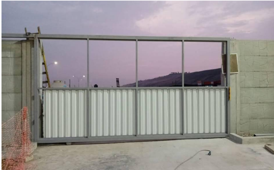
Figura 63. Montaje de portón en el patio de maniobras
