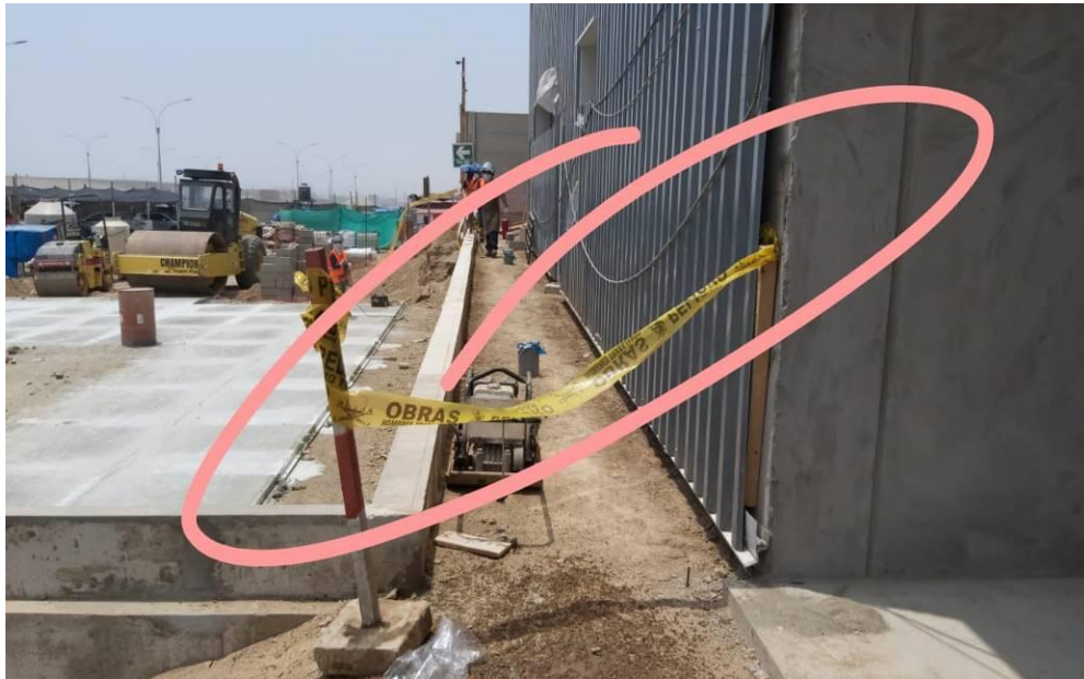
Figura 40. No se limita de manera correcta el área de trabajo
