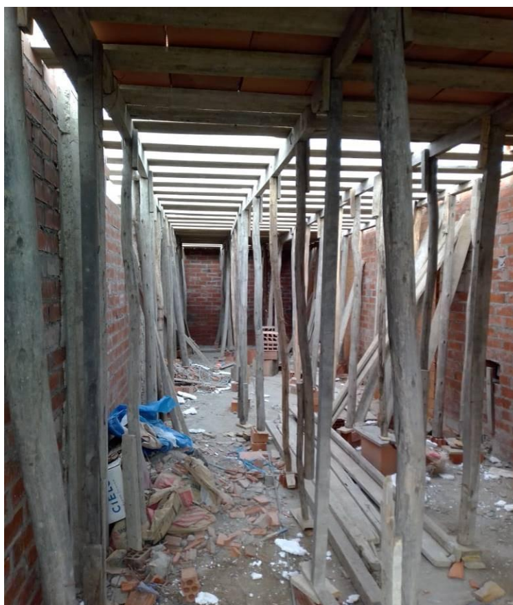
Figura 29. Encofrado de losa
