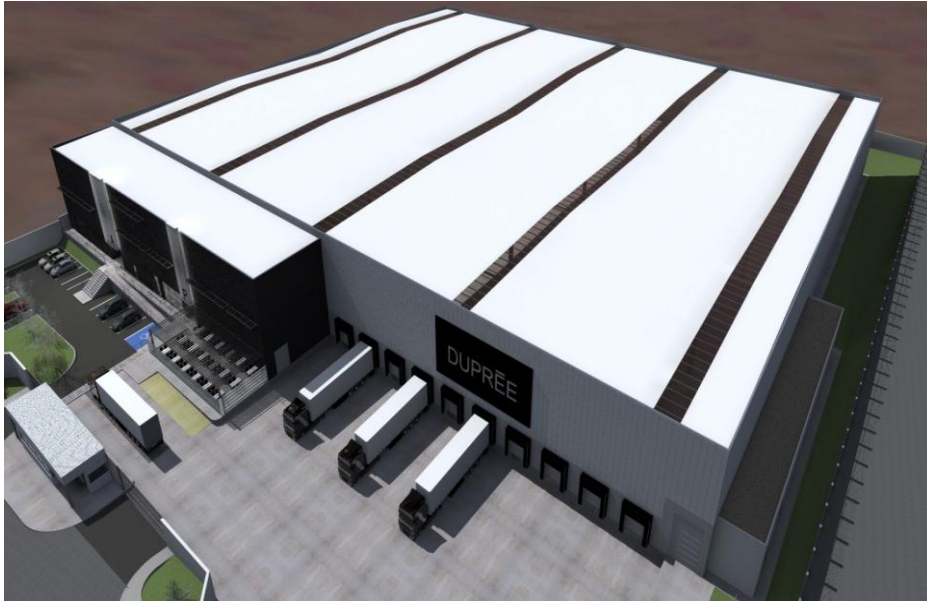
Figura 34. Nuevo Centro de Distribución Dupree
