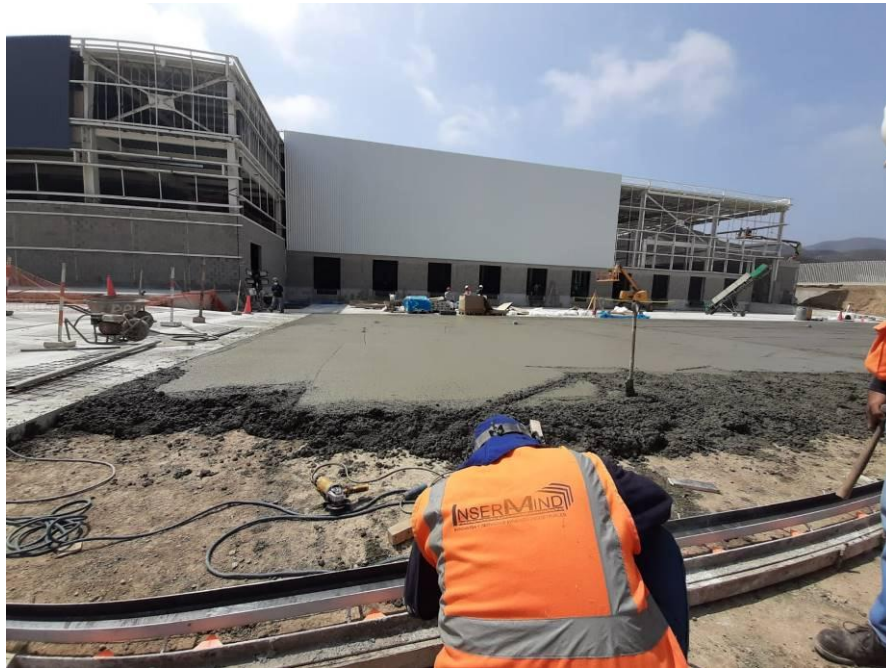
Figura 61. Instalación de riel para portón en patio de maniobras
