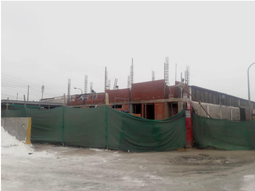
Figura 31. Levantamiento de muro segundo piso
