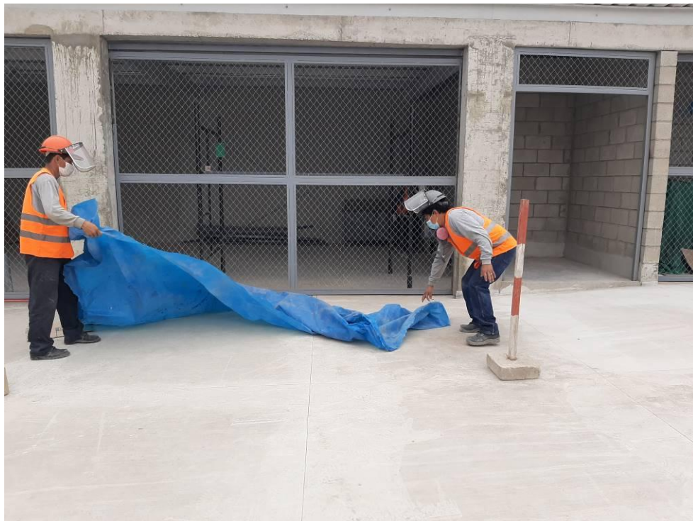
Figura 58. Montaje y Pintado de Portones metálicos de cuarto de basura
