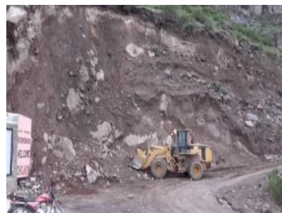
Figura 1. Rehabilitación de vía por deslizamiento Fuente: Propio
