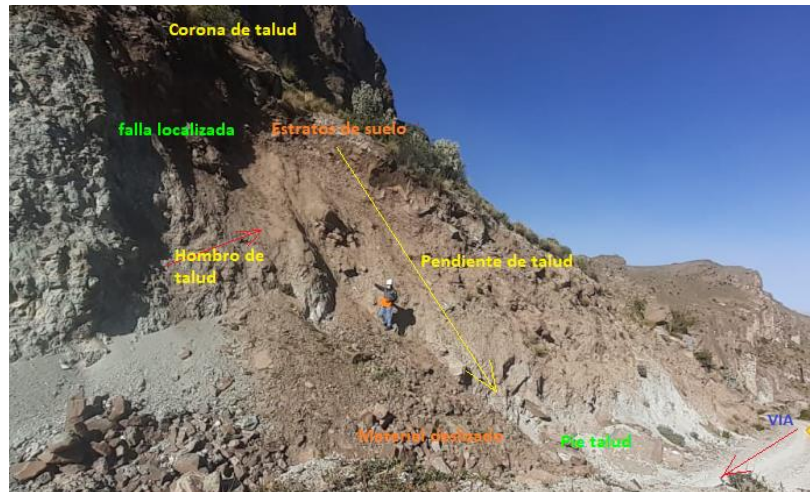
Figura 17. Falla por Rotacion.
