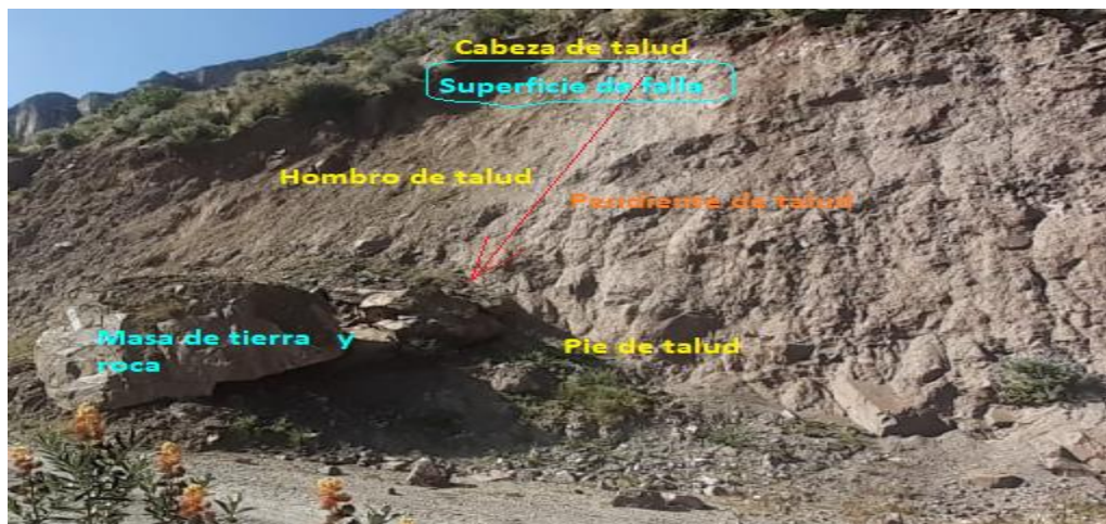
Figura 18. Falla Superficial Local.
