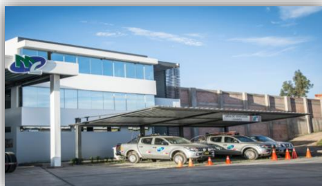
Figura N.º 1. Oficinas administrativas MC Transportes S.R.L.
